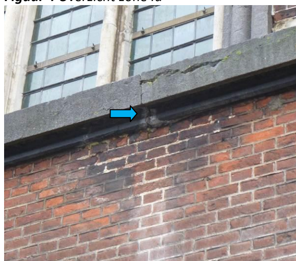
Figuur 5 Openstaande en aangetaste voegen ter hoogte van de afwatering, onder de raamdorpels en boven het grafmonument aan de buitengevel ter hoogte van zones lc en ld
