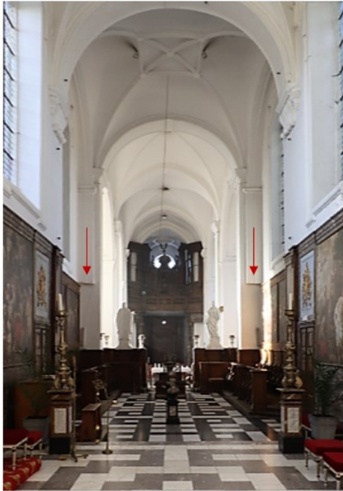
Afb. 20: koor met zicht naar het schip en aanduiding van de onderbroken hoekpilasters
