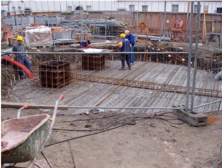
november 2004. (Zie: foto Pauwels – Stoop Architecten)
