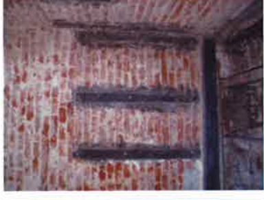
Ingewerkte houten stijlen in ruimte 04.
