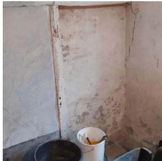
Afb. 57: Dichtgemaakte deuropening.
