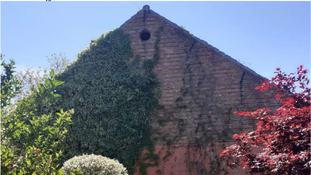
Afb. 153: Linker gevel stal.
