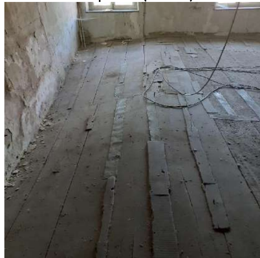
Afb. 72: Gebolde vloer travee 3.
