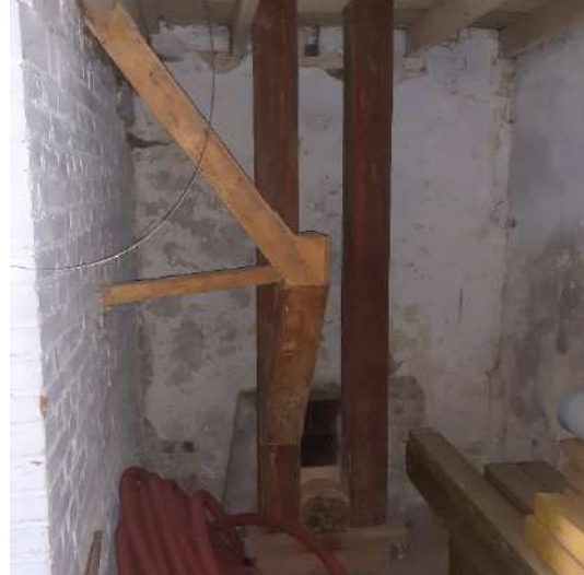
Afb. 132: Jacobsladder voor transport gemalen bloem naar steenzolder.
