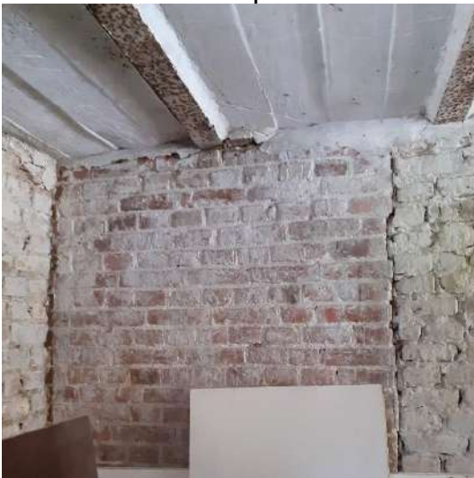
Afb. 156: Verschillende bouwfases tussenwand.
