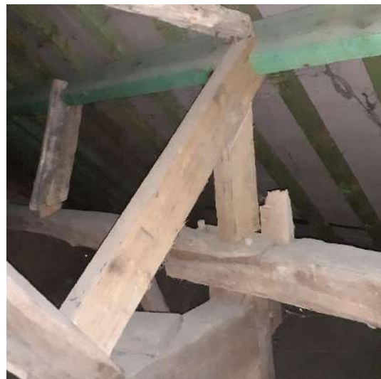
Afb. 93: Constructie die nieuwe gording draagt.
