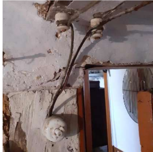
Afb. 61: Oude elektriciteitsinstallatie.
