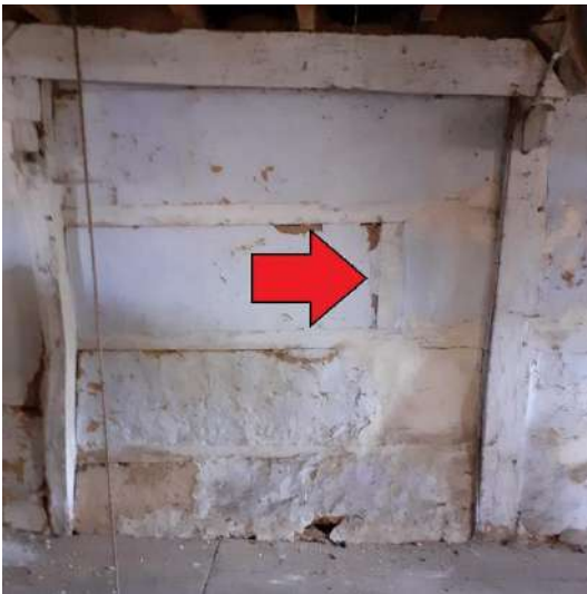
Afb. 104: Dichtgemaakt venster in tussenwand op as 4.
