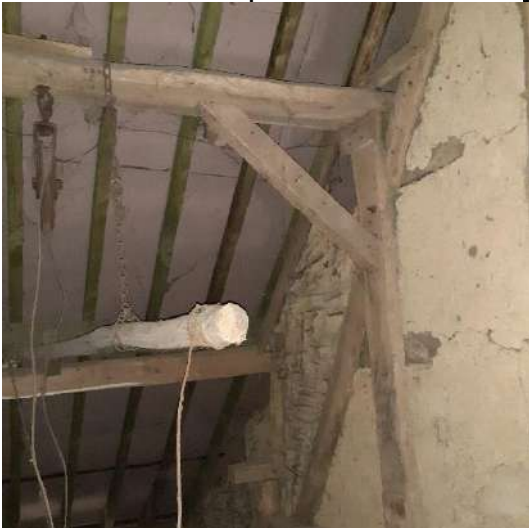
Afb. 116: Bevestiging luiwerkconstructie.
