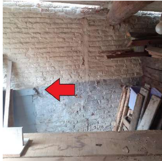
Afb. 21: Opdeling gevel, links woonhuis, rechts molenhuis. Afb. 22: Einde van lijst bovenaan gecementeerde plint. Eigenlijke opdeling tussen woon- en molenhuis verloopt langs de rode lijn.
