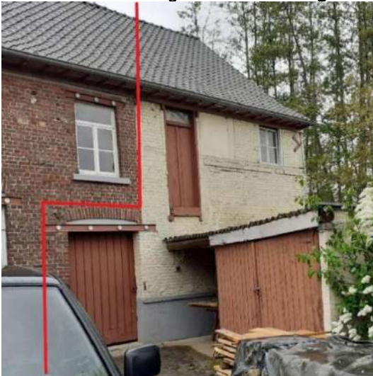
Afb. 21: Opdeling gevel, links woonhuis, rechts molenhuis. Afb. 22: Einde van lijst bovenaan gecementeerde plint. Eigenlijke opdeling tussen woon- en molenhuis verloopt langs de rode lijn.
