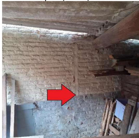
Afb. 26: Dichtgemaakte deuropening.
