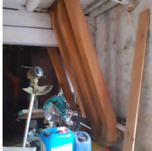
Afb. 134: Meelgoten voor verschillende kwaliteiten gezeefde bloem.
