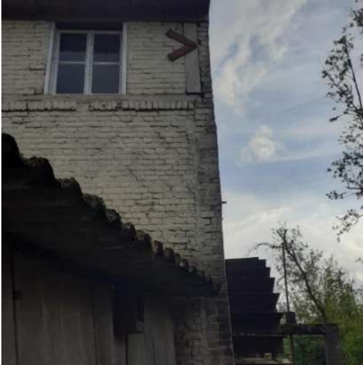
Afb. 27: Bouwnaad tussen voor- en zijgevel molenhuis.
