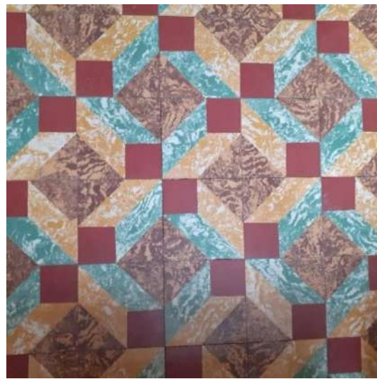
Afb. 51: Vloerafwerking in cementtegels.
