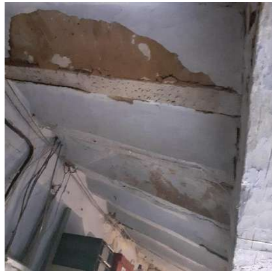
Afb. 95: Plafondafwerking met troggewelven in travee 3.
