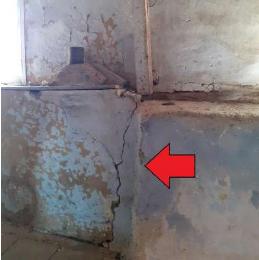
Afb. 108: Bouwnaad tussen travee 4 en 5.
