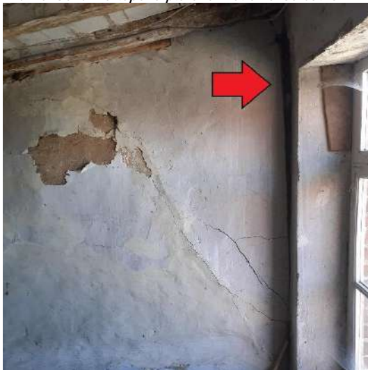
Afb. 75: Spatie tussen binnenwand op as 4 en voorgevel.
