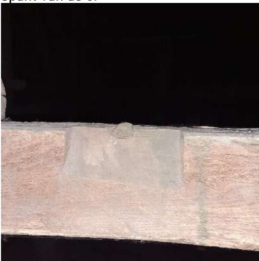
Afb. 92: Uitsparing op oude gording waar oorspronkelijke kepers bevestigd waren.
