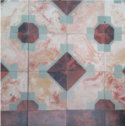
Afb. 46: Vloer in cementtegels.
