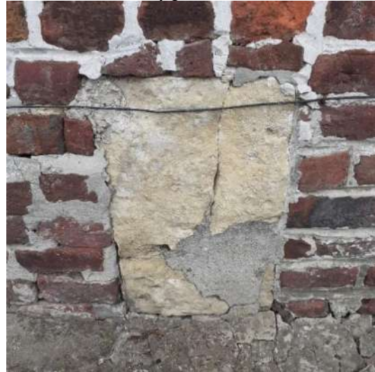
Afb. 35: Ingewerkte zandsteen.
