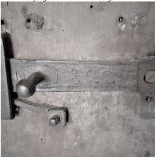
Afb. 98: Deursluiting voordeur met opschrift 1822.
