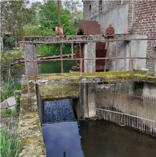
Afb. 124: Sluizencomplex met lossluis (L) en maalsluis (R).
