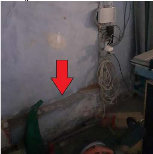
Afb. 94: Vakwerk wand in het midden van travee 3 met bakstenen plint.
