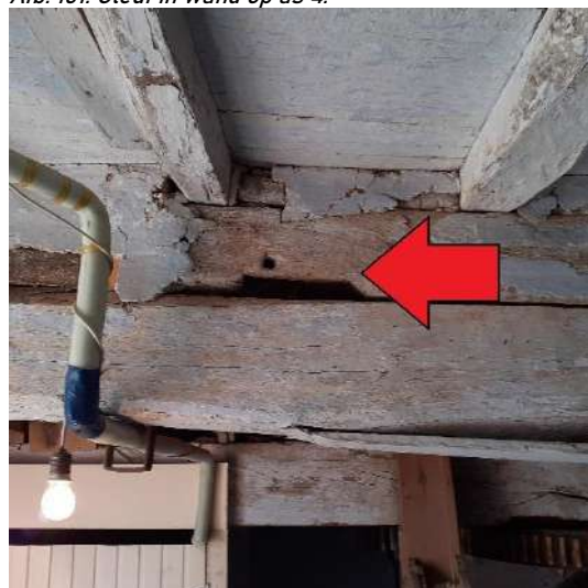
Afb. 103: Gerekupereerde secundaire balk op moerbalk as 5 met aanduiding oud pen -en toognagelgat.
