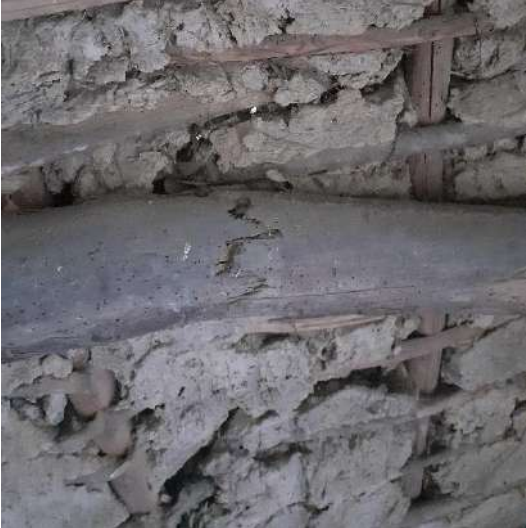
Afb. 79: Gebroken regel op as 4.
