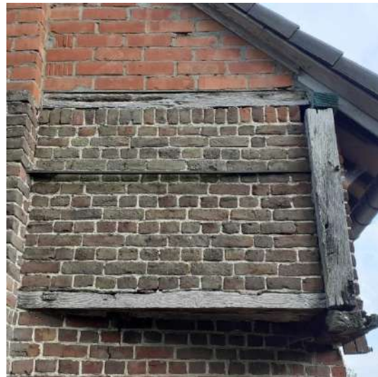
Afb. 42: versteend vakwerk.
