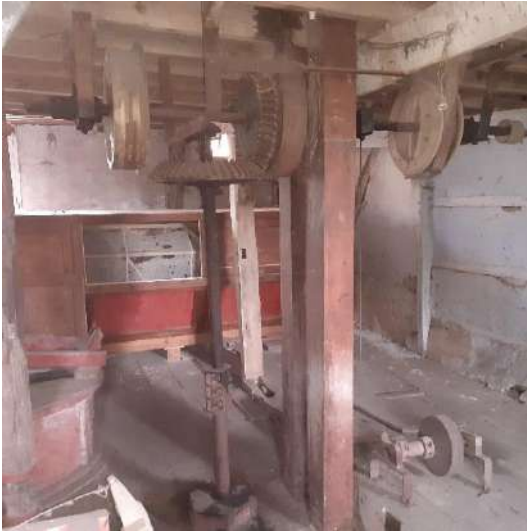
Afb. 140: Lijnas, met verschillende riemschijven, twee houten kokers van de jacobs ladder en onderaan rechts de slijpsteen voor de bilhamer.
