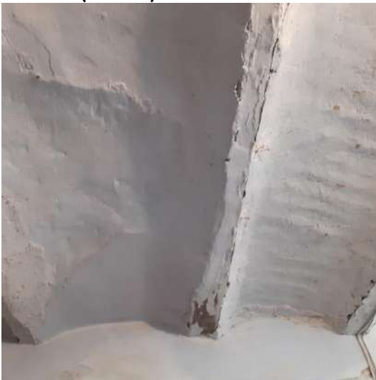
Afb. 56: Plafondafwerking met troggewelven.
