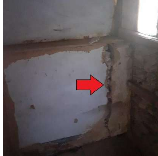
Afb. 80: Barste en bouwnaad in achtergevel.
