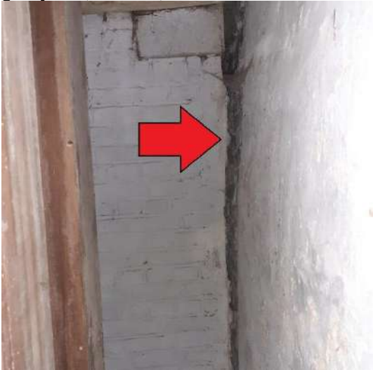
Afb. 127: Detail spatie tussen bakstenen peiler molengebinte en buitengevel.
