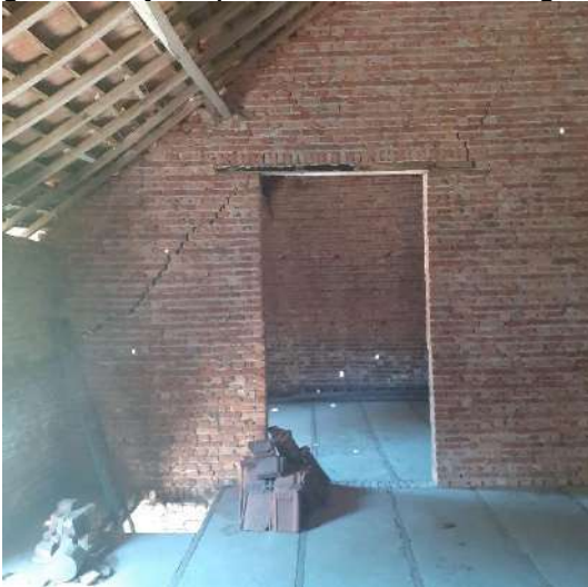
Afb. 158: Deuropening op verdieping.
