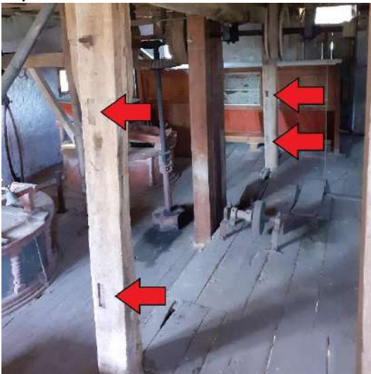
Afb. 110: Stijlen op as 5 met aanduiding afgezaagde regels.
