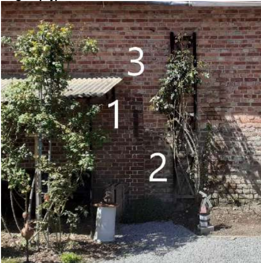
Afb. 151: Verschillende bouwfasen achtergevel.
