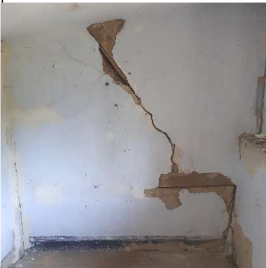
Afb. 81: Barst met schuine schoor in tussenwand op as 3.
