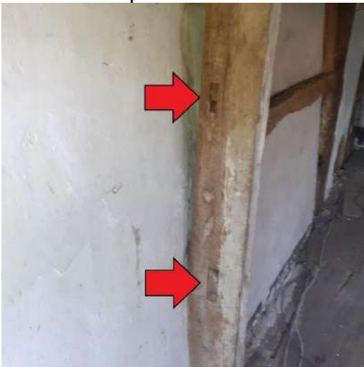
Afb. 71: Afgezaagde regels vakwerkconstructie.
