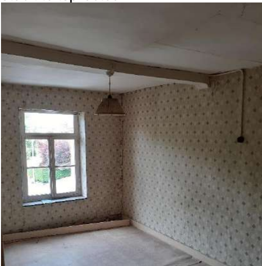
Afb. 67: Kamer met dwarse balk als plafond ondersteuning.
