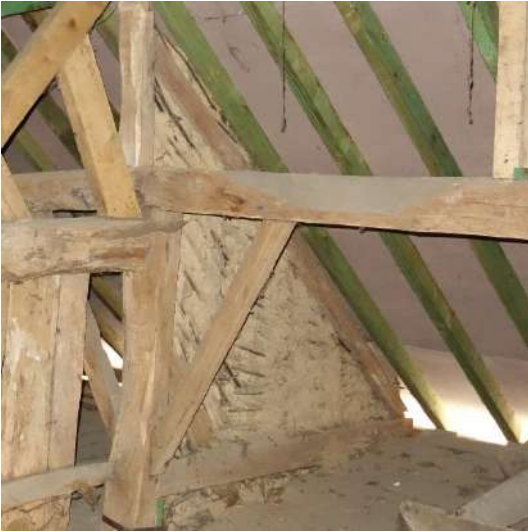
Afb. 86: Dichtgeleemd vak as 3.
