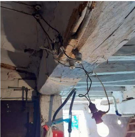
Afb. 100: Originele elektriciteitsinstallatie.
