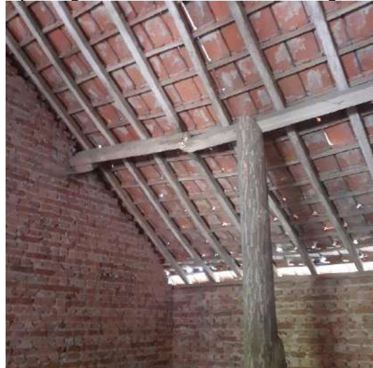
Afb. 159: Gebroken en gestutte gording.
