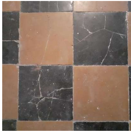
Afb. 55: Vloerafwerking met tegels in blauwe hardsteen en Belgische witsteen.
