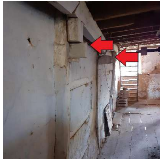
Afb. 111: Tussenwand op as 4 met Ankers van balken die het plafond van travee 3 dragen.
