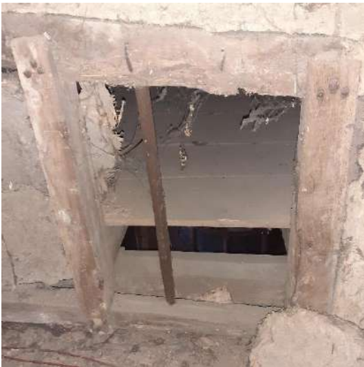
Afb. 91: Oude vensteropening met ijzeren diefijzer as 4.
