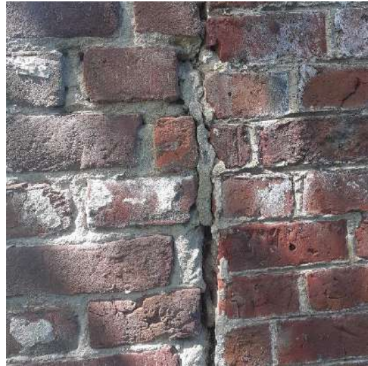
Afb. 152: Bouwnaad aan hoek met rechter gevel.
