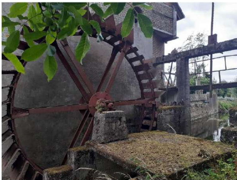
Afb. 10: Externe moleninstallatie met sluizen en damwanden.
