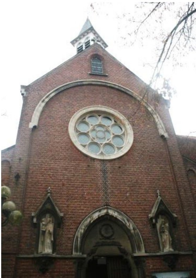
Figuur 37: Detail voorgevel, ARAT 2018
