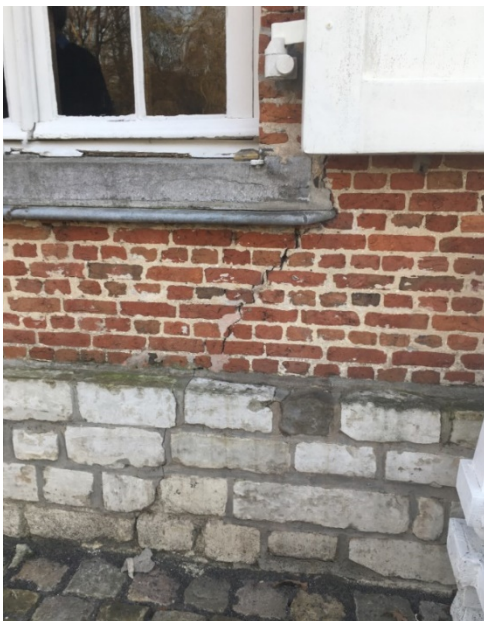
De scheur in de oostelijke zijgevel loopt helemaal van de grond tot de dakgoot.
