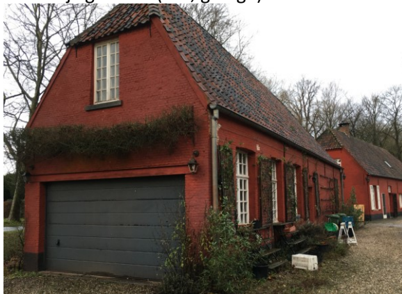
Westelijk gebouw (W3, garage):
