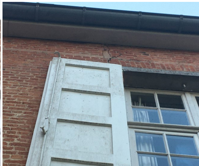
De scheur in de oostelijke zijgevel loopt helemaal van de grond tot de dakgoot.
