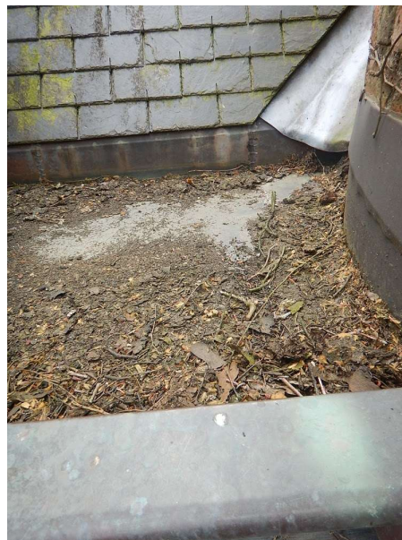
Goot [8]-noordwest: de vervuiling werd door ons weggenomen
