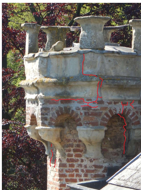
Scheurvorming
