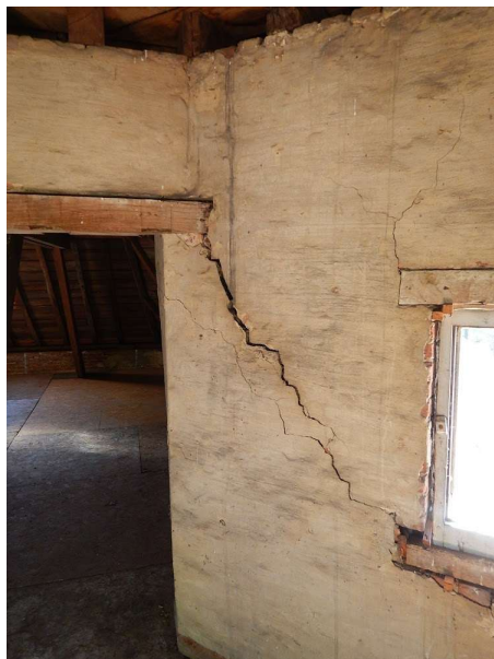
Diagonale scheurvorming
