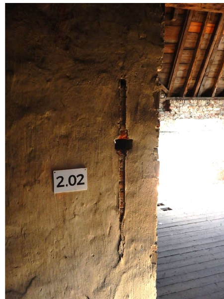
Zolder [2]: bouwspoor (muuranker)
