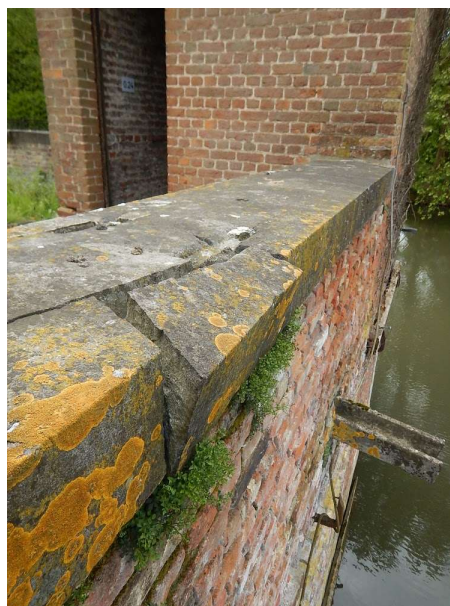
Noordwestzijde: vóór verwijdering loszittend deel deksteen
