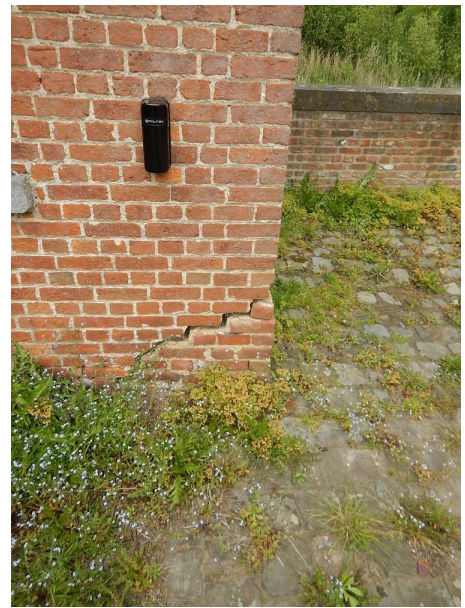
Scheurvorming
