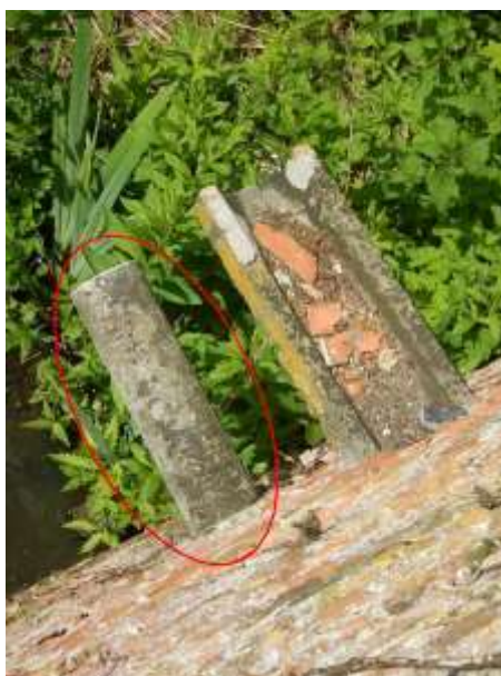
Waterspuwer in de omwalling, ten westen van poortgebouw [8]
