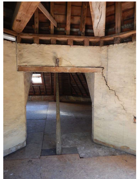
Houten latei boven doorgang tussen zolder [1] en [2]
