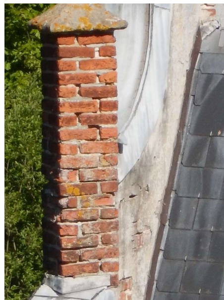
Topgevel [5]-zuidwest - zuidelijk topstuk
