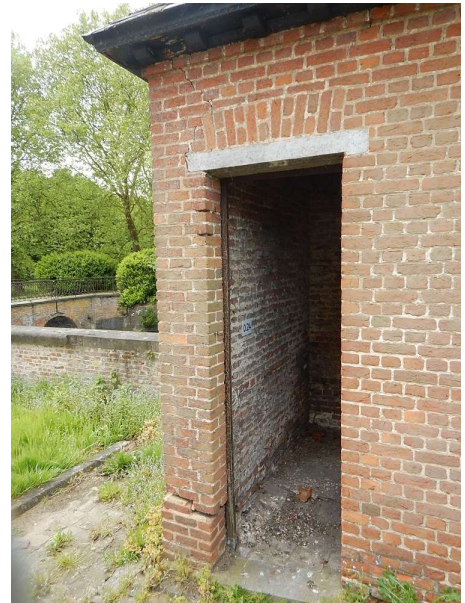
Scheurvorming
