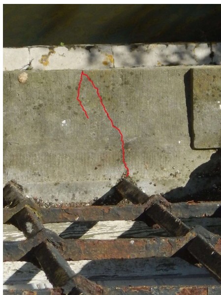
Vleugel [2]-noordoostgevel uitbouw: beschadigde raamdorpel t.g.v. roestige diefijzers
