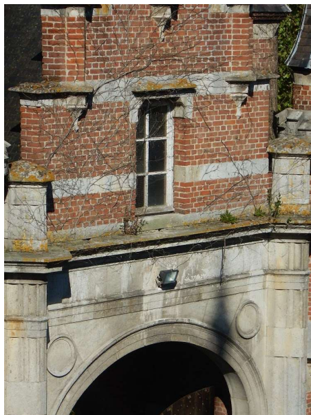
Vleugel [8]-noordoost: plantengroei in uitgespoeld voegwerk kordonlijst
