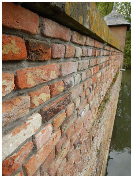
Noordwestzijde: cementrijke legmortel, metswelwerk niet gevoegd
