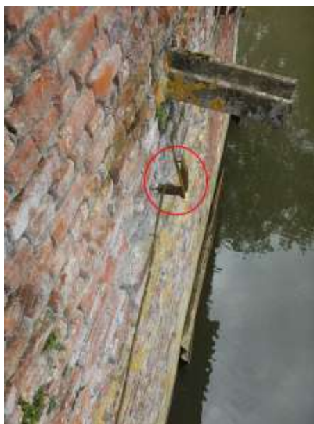
Noordwestzijde: niet-functioneel roestig deel
