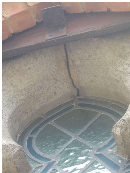
Vleugel [4]-zuidwest: ingescheurd maaswerk glas-in-loodraam
