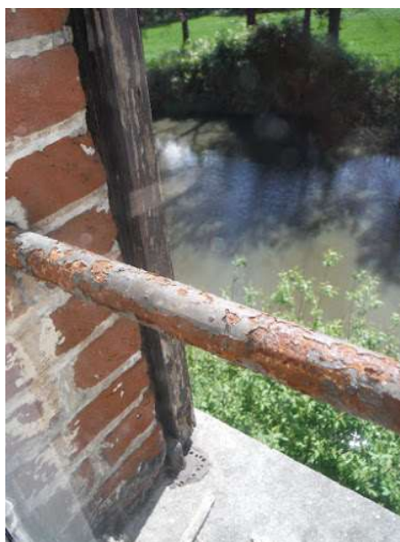
Vleugel [2]-noordoostgevel uitbouw: beschadigde raamdorpel t.g.v. roestige diefijzers
