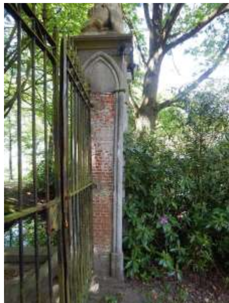
Noordelijke rechthoekige poortpijler helt over naar het noordoosten
