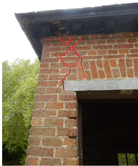
Scheurvorming
