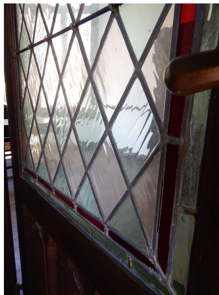
Toren [1]/vleugel [2]: uitgebuikt glas-in-lood
