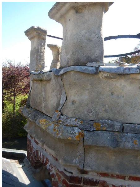
Sterk verweerde witte steen. Cementmortel komt los en valt weg.
