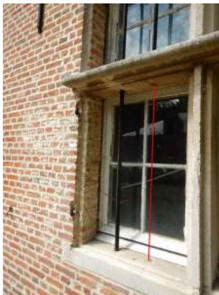
Vleugel [11]: ontbrekend diefijzer
