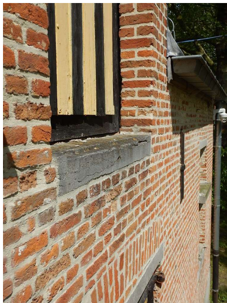
Vleugel [11]-oost: dorpel steekt niet uit voorbij het onderliggend metselwerk
