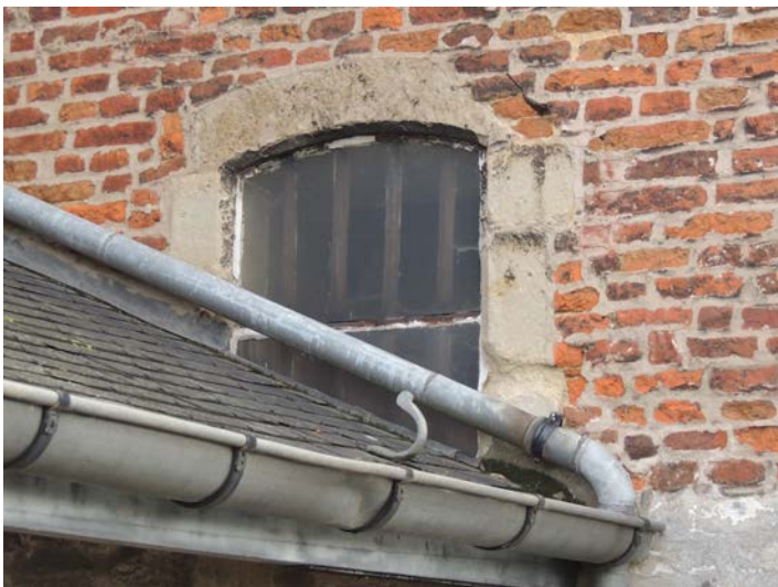
Fig. 138a: Raam in de noordelijke uitbouw van de toren – NIVO 0)
