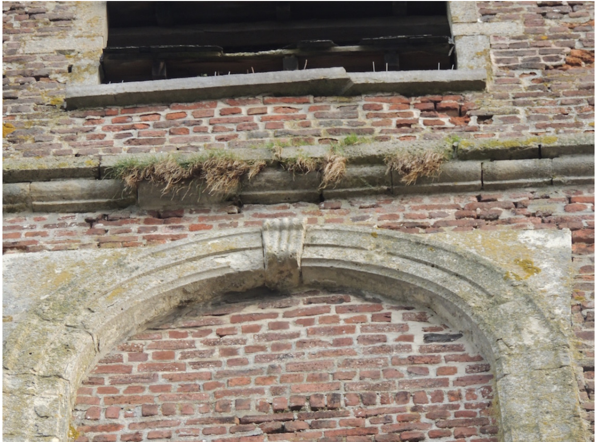
Fig. 136: Detail westgevel toren (GG)
