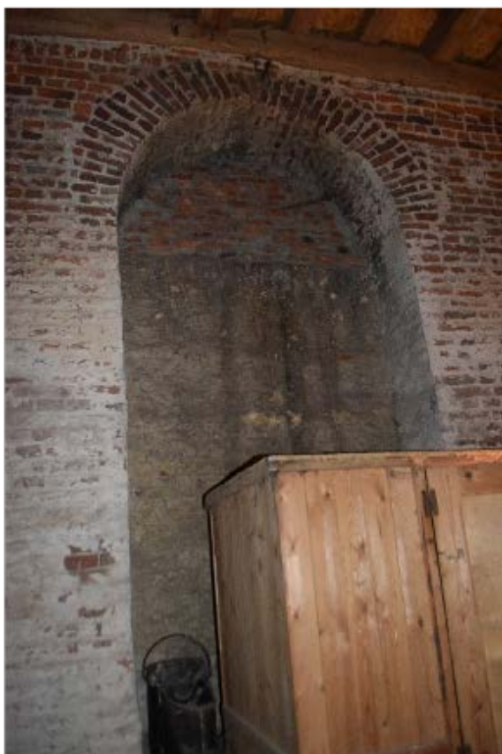
Figuur 23: Interieurzijde van de dichtgemetselde vensteropening in de westelijke torengevel
