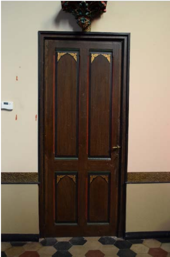
Fig. 164: Houten paneeldeur uit 1874 naar de berging aan de noordzijde van het koor (AC)
