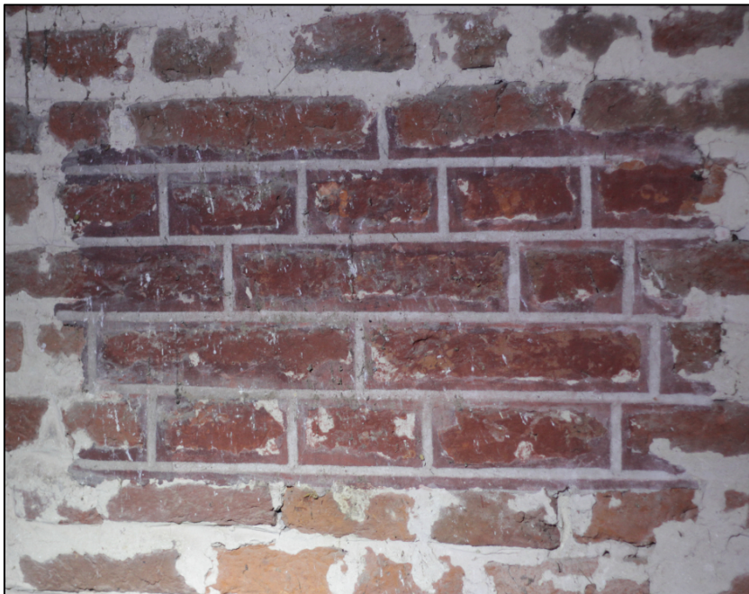
Fig. 137: Het proefvlak zoals te vinden op de zuidwand van de tweede verdieping van de toren. de techniek en kleuren zijn bijna gelijk aan de baksteenimitatie op het schip en koor, maar ze wijkt af omdat hier getrouw de voeg van de steen werd gevolgd, hier in een onregelmatig verband (O)
