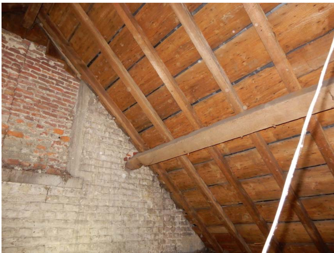
Fig. 27: Aanzet meest recente dak tegen de gekaleide toren, dichtgemetselde raamopening (Tri-Consult)
