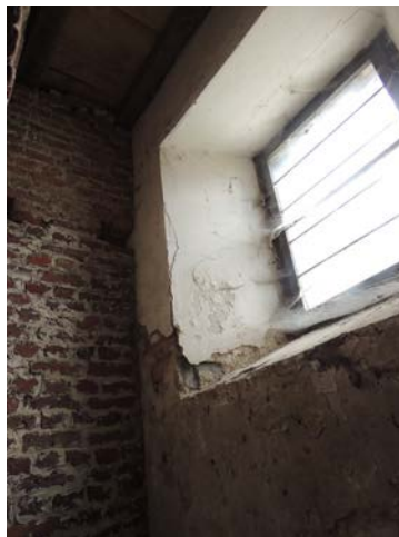
Fig. 57: Zuidelijke vleugel thv de toren. Ondiepe ovaalvormige nis en en 58 en 58bis pleisterwerk doorlopend achter het invulmetselwerk. (Fig. 58bis: L. de Theux)
