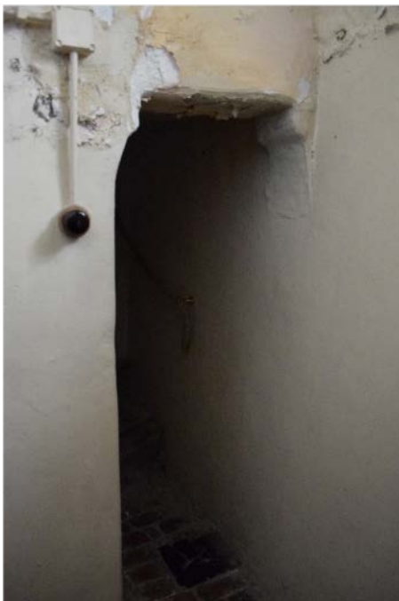
Fig. 8: Deuropening naar de torentrap (A.C.)
