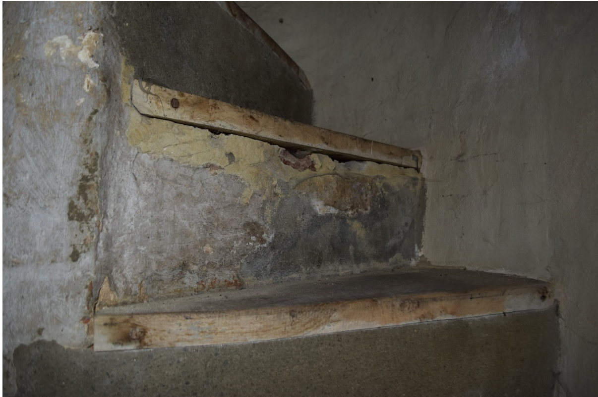
Fig. 10: Gemetselde splitrapp naar het doksaal met natuurstenen treden en 20 ste eeuwse aanpassingen (A.C.)
