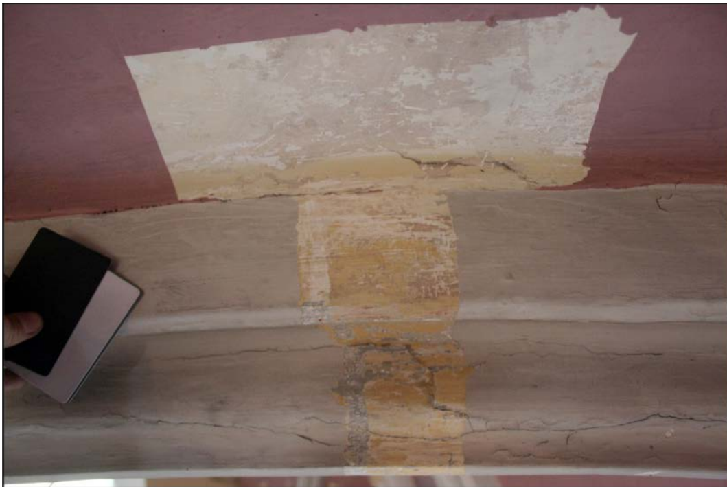
Fig. 100: Vrijlegging van de Art Deco fase van een rib in de noordbeuk. Ook het grijs, rood en wit van de voorgaande fase schemeren door
