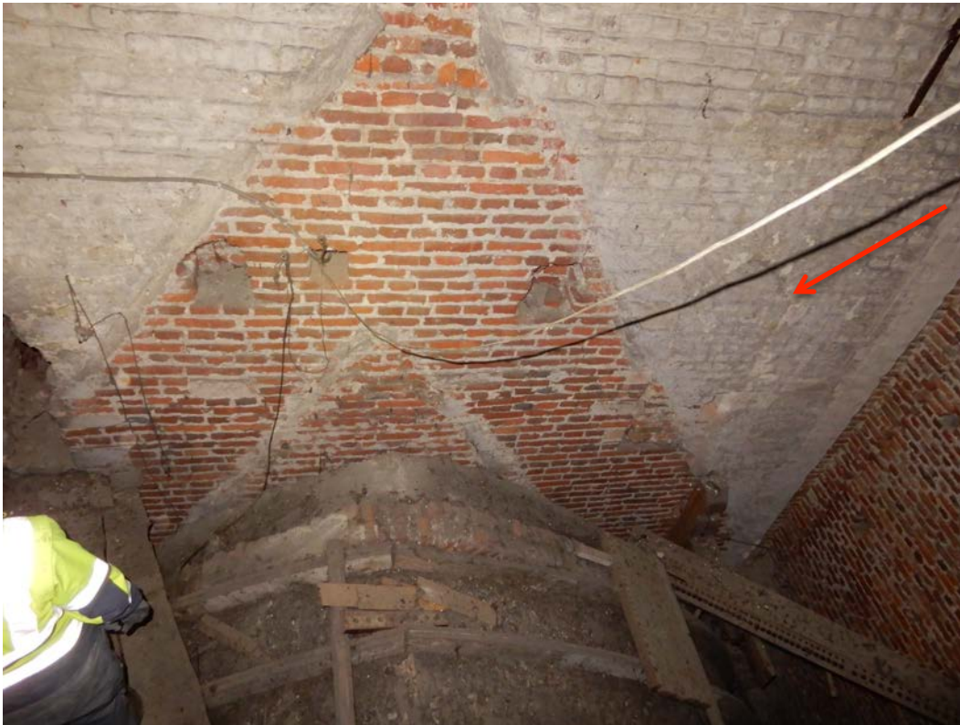
Figuur 24: Sporen van de twee fasen van de vroegere dakaanzet en rechts daarvan de sporen van de dichtgemetselde gotische vensteropening (Tri-Consult).
