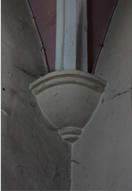
Fig. 13: Detail van het kruisribgewelf van het doksaal (A.C.)
