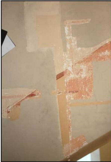
Fig. 99: Vrijlegging van twee fasen op de band boven de gordelbogen. De band in Art Deco fase volgt getrouw die uit voorgaande fase (O)
