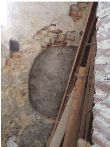
Fig. 57: Zuidelijke vleugel thv de toren. Ondiepe ovaalvormige nis en en 58 en 58bis pleisterwerk doorlopend achter het invulmetselwerk. (Fig. 58bis: L. de Theux)
