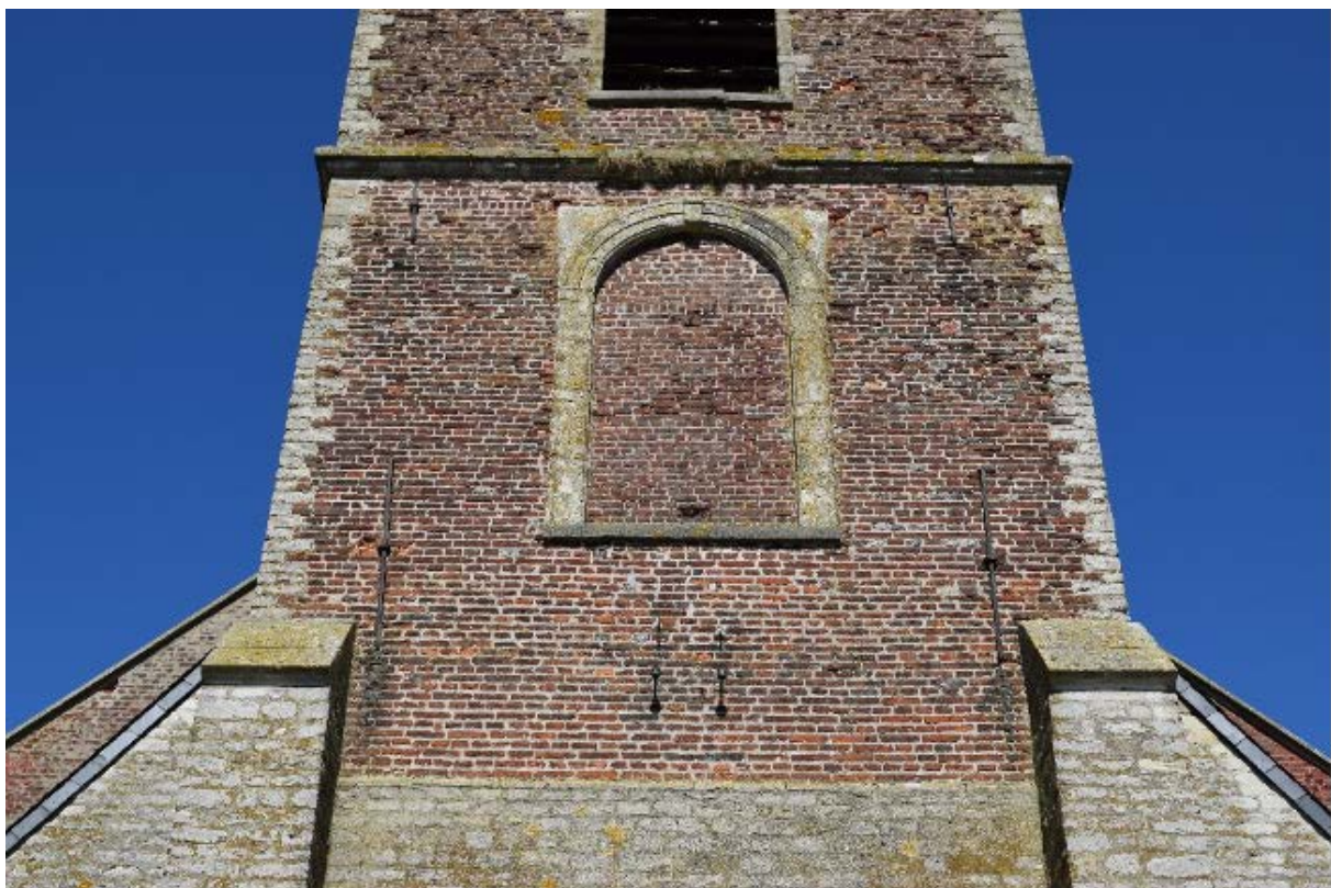
Fig. 22: Westgevel van de kerk met centraal een in twee fasen dichtgemetselde vensteropening met 18 de -eeuwse geprofileerde, witstenen omlijsting met sluitsteen
