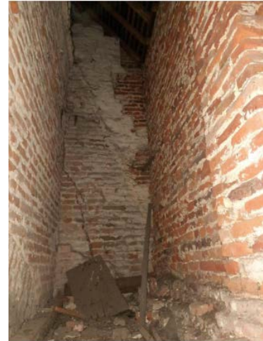
Fig. 57: Zuidelijke vleugel thv de toren. Ondiepe ovaalvormige nis en en 58 en 58bis pleisterwerk doorlopend achter het invulmetselwerk. (Fig. 58bis: L. de Theux)
