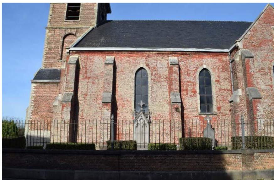
Fig. 51: Zicht op de zuidelijke gevel van het schip uit 1874
