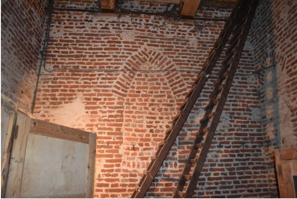
Fig. 15: Spitsboogvenster in de noordelijke torenwand met sporen van een vroegere balkenlaag.
