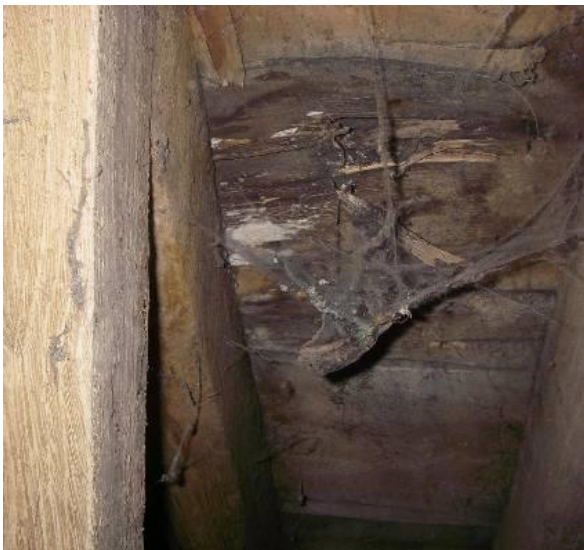
Fig. 124 en 125: doorgerotte en met schimmels aangetaste beebording (MW)
