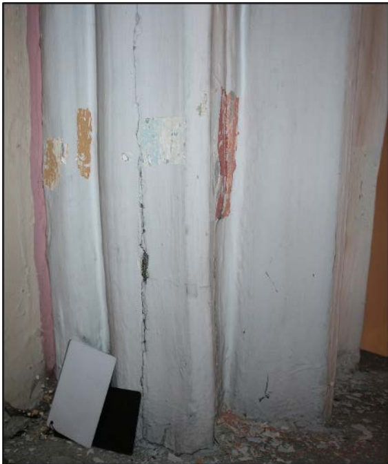
Fig. 96: Opname van de bundelpijler van noordwand van middenbeuk tussen de eerste en tweede travee (O)
