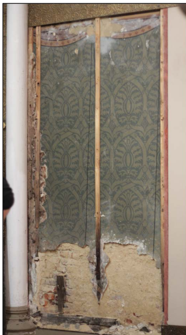
Fig. 93: Het vrijgemaakte deel van de zuidwand in het koor
