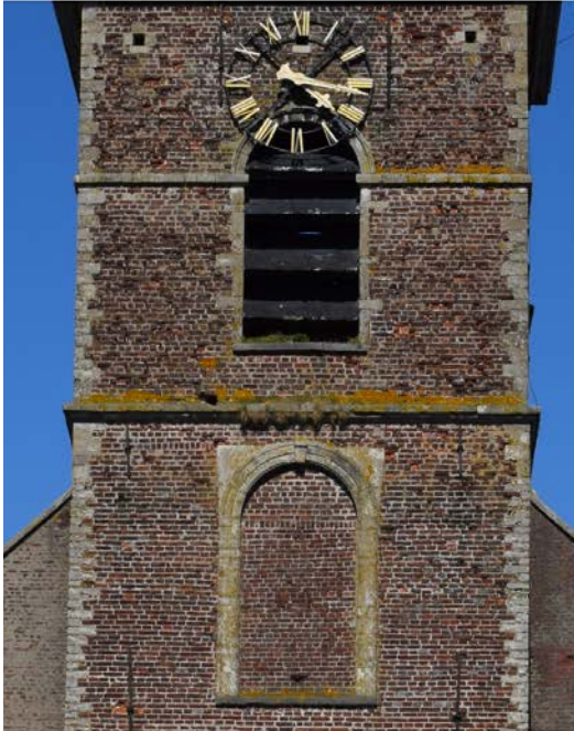
Fig. 67: Torenuurwerk, de galmborden en dichtgemetselde vensteropening (W)
