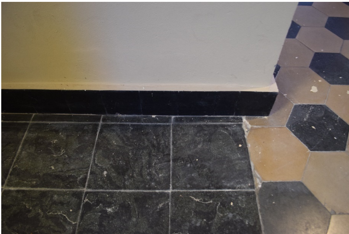
Fig. 79: Nieuwe tegelvloer in de zuidelijke zijkapel
