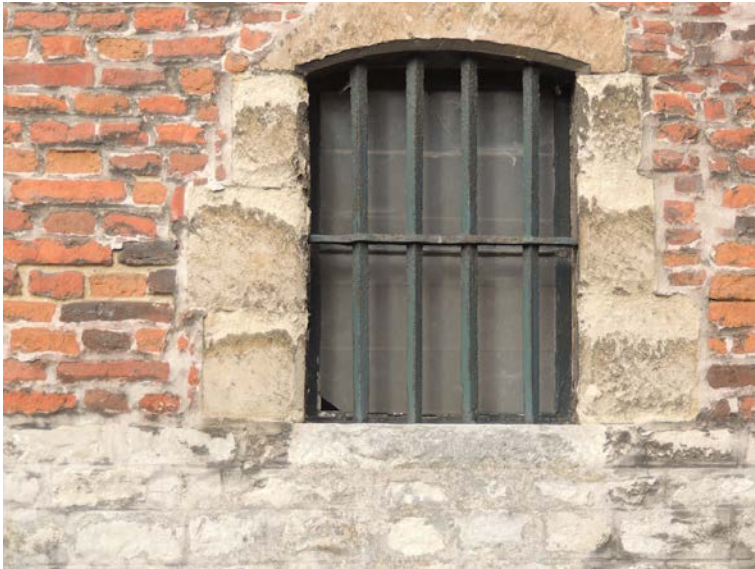
Fig. 138b: Raam in de zuidelijke uitbouw van de toren – NIVO 0)
