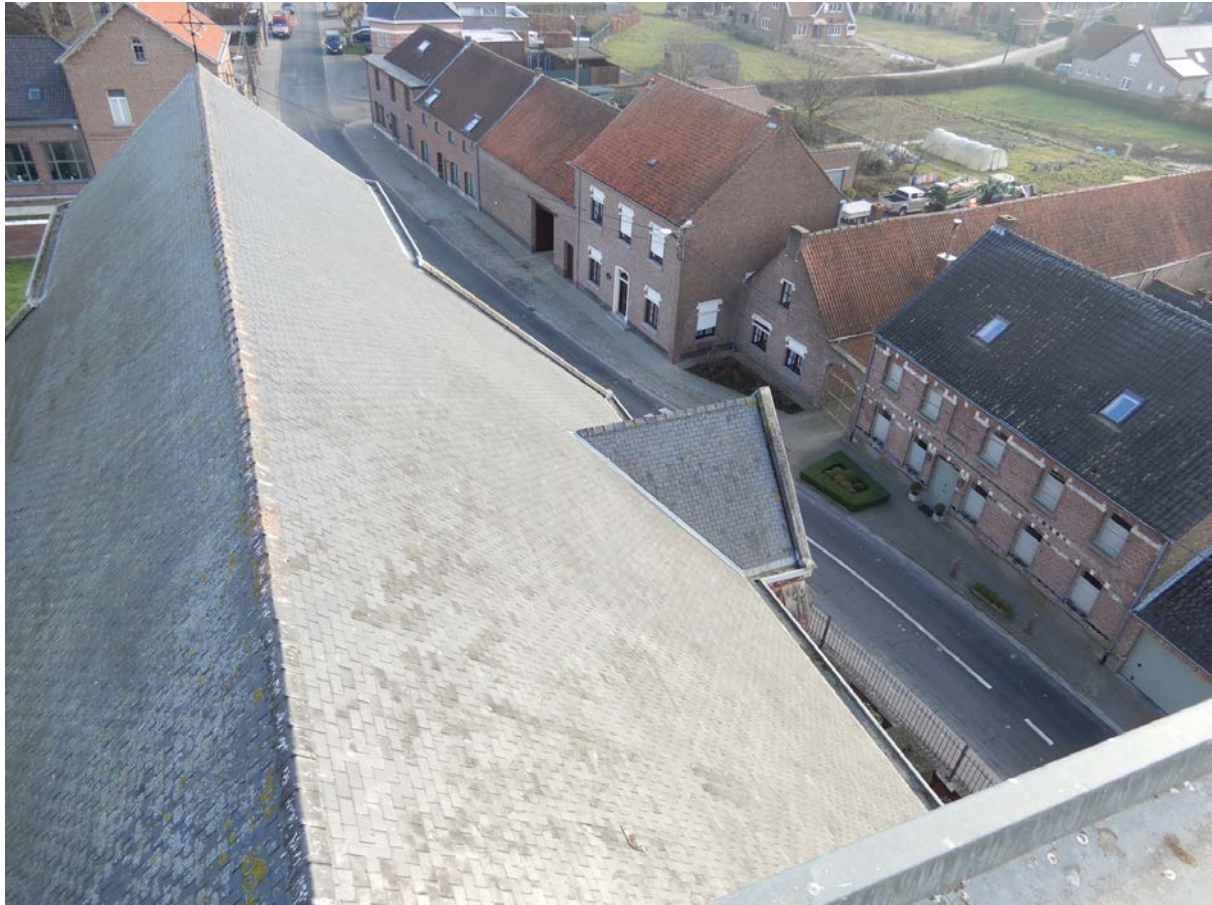
Figuur 120: De geglazuurde gebakken aarden nokpannen van het hoofddak zijn oppervlakkig licht verweerd (Triconsult)
