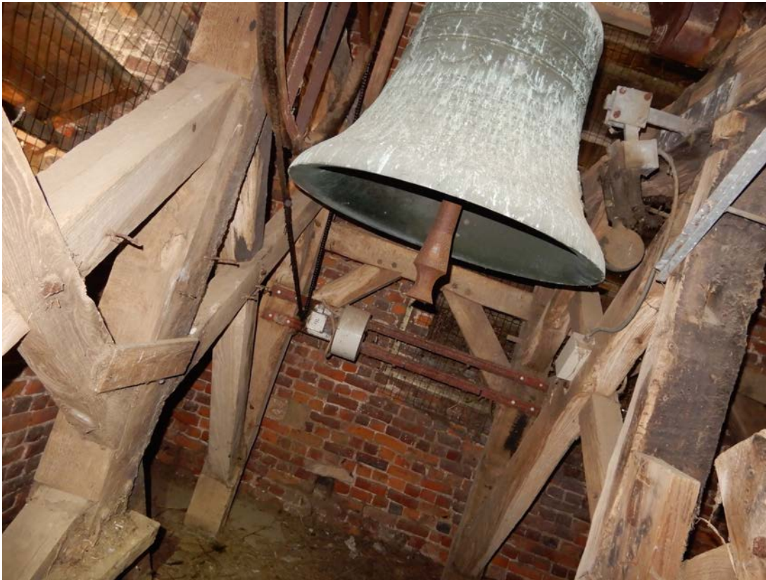
Fig. 183: Klokkenstoel in eik, klok en roestig vliegwiel en luibalk (TriConsult)
