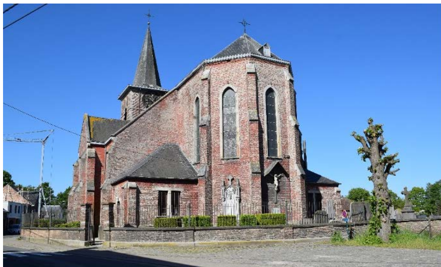
Fig. 49: Zicht op het koor, sacristie en schip uit 1874
