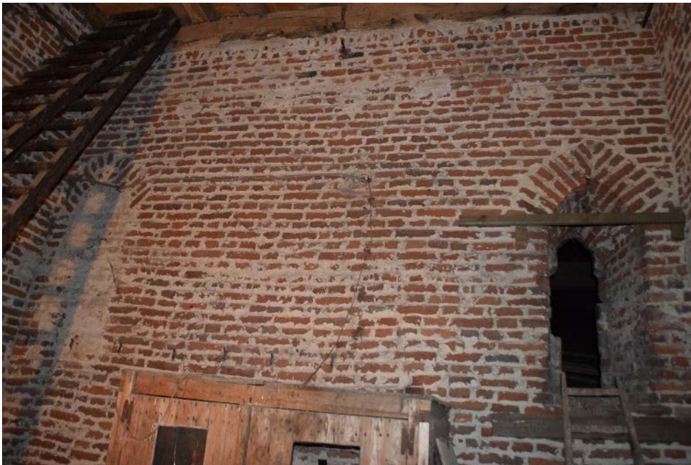
Fig. 16: Twee kleinere spitsboogvensters in de oostelijke torenwand met rechts bewaarde negblokken aan de oorspronkelijke buitenzijde, met sporen van een vroegere balkenlaag.
