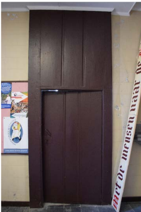
Fig. 6: Opgeklampte deur opgehangen met duimhengsels naar de torentrap tot het doksaal
