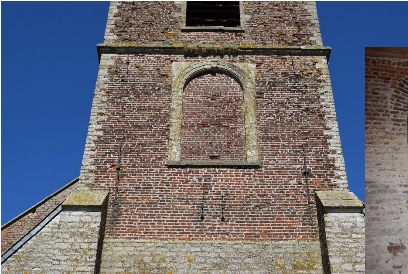
Afb. 23 Westgevel van de kerk met centraal een dichtgemetselde vensteropening met 18 de -eeuwse geprofileerde, witstenen omlijsting met sluitsteen
