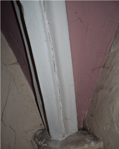
Afb. 11 Detail van het kruisribgewelf van het doksaal
