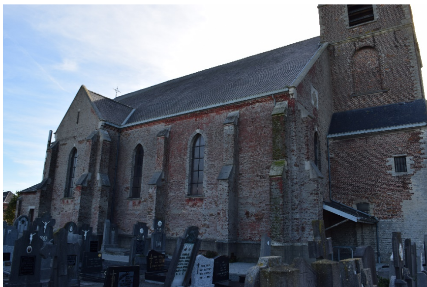
Afb. 40 Zicht op de noordelijke gevel van het schip uit 1874
