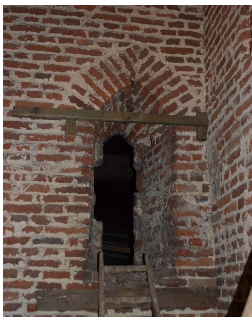
Afb. 17 Spitsboogvormige vensteropening met bewaarde negblokken
