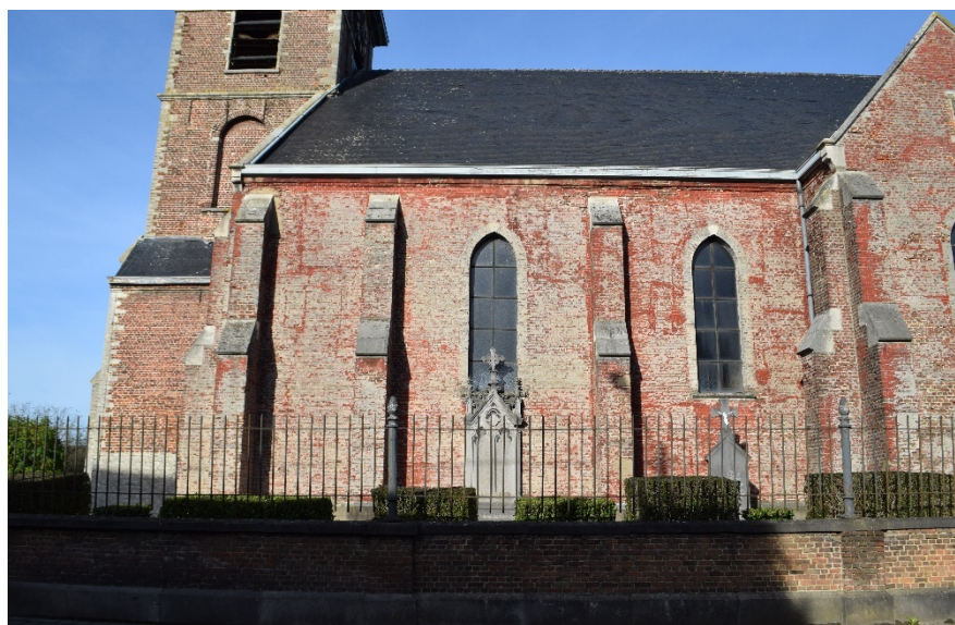
Afb. 44 Zicht op de zuidelijke gevel van het schip uit 1874
