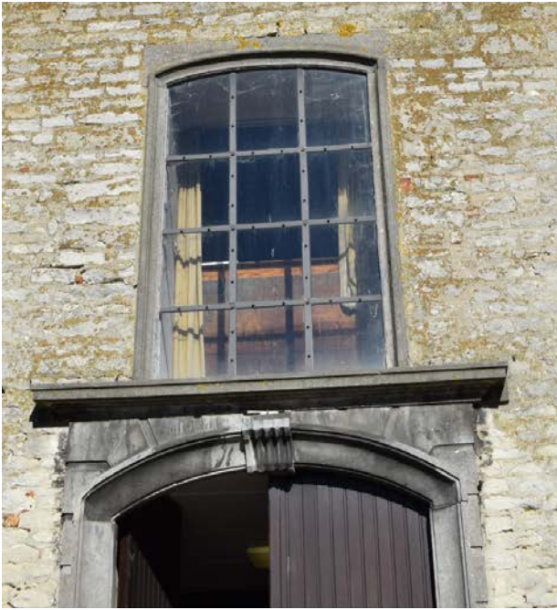
Afb. 64 Detail van de poortomlijsting en vensteropening van het doksaal
