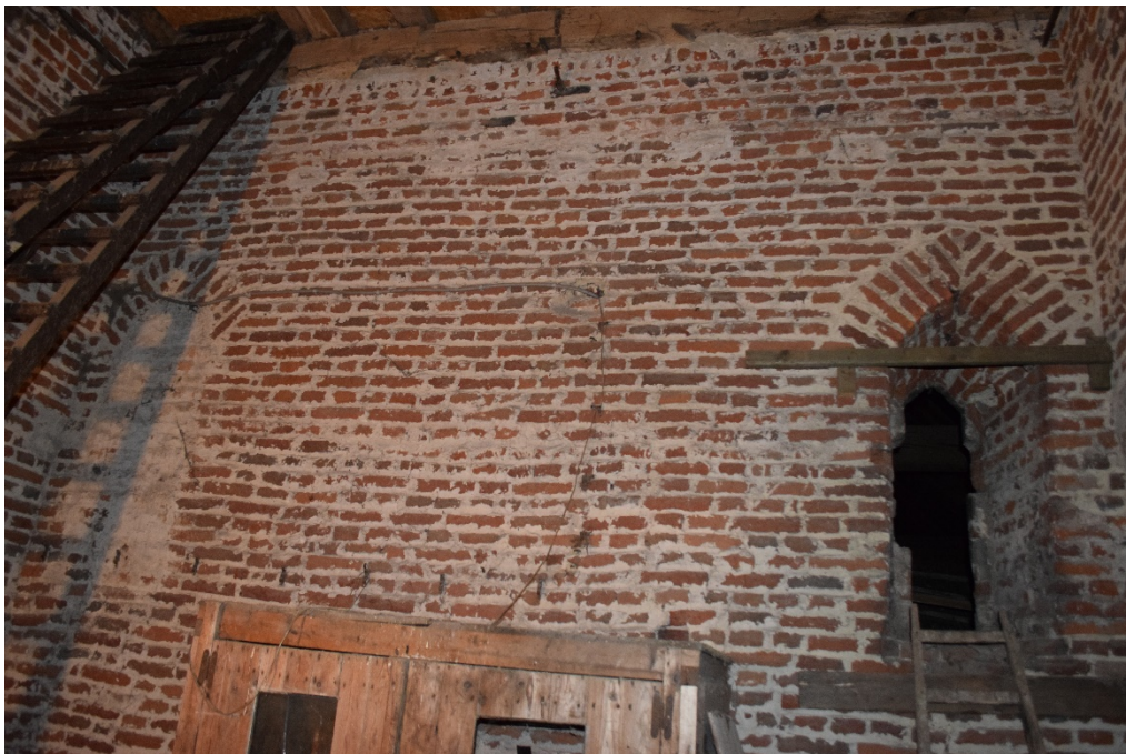
Afb. 15 Twee kleinere spitsboogvensters in de oostelijke torenwand met rechts bewaarde negblokken aan de oorspronkelijke buitenzijde
