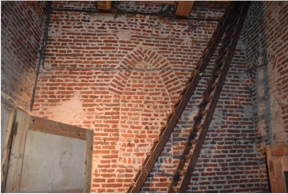
Afb. 14 Spitsboogvenster in de zuidelijke torenwand
