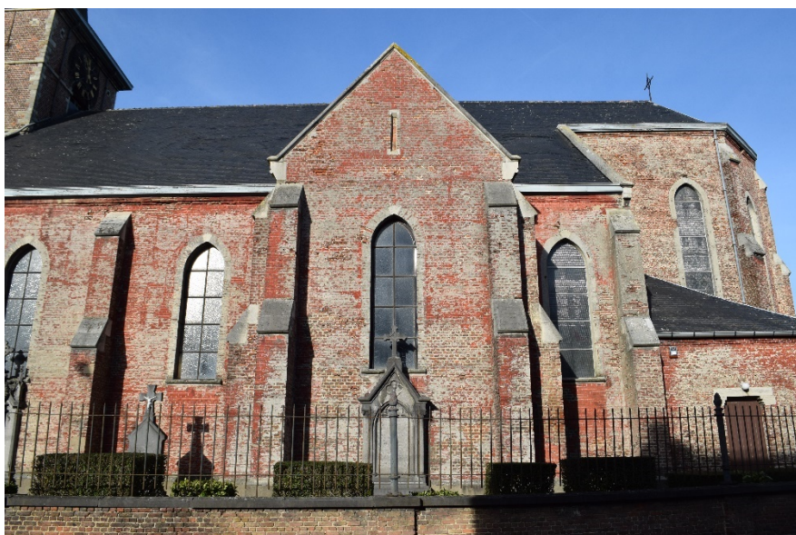
Afb. 43 Zicht op de zuidelijke gevel van het schip uit 1874
