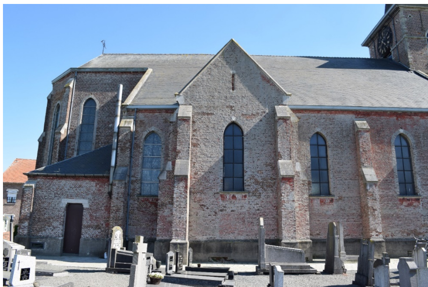
Afb. 41 Zicht op de noordelijke gevel van het schip uit 1874
