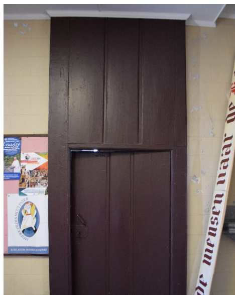
Afb. 5 Opgeklampte deur opgehangen met duimhengsels naar de torentrap tot het doksaal
