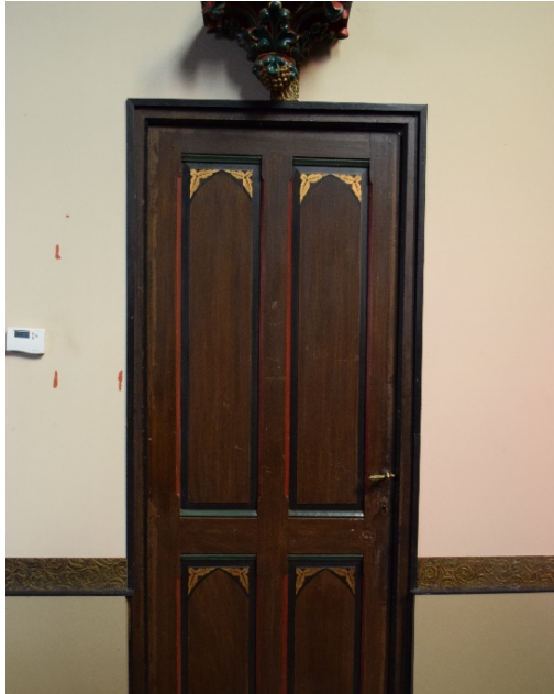
Afb. 48 Houten paneeldeur uit 1874 naar de berging aan de noordzijde van het koor
