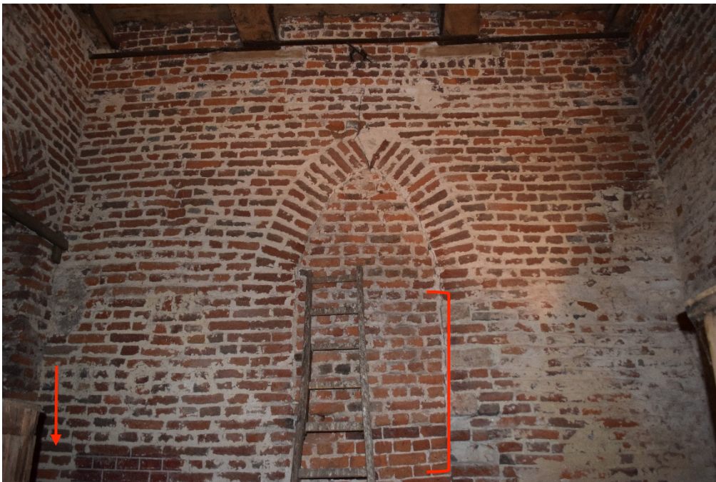
Afb. 13 Spitsboogvenster in de zuidelijke torenwand met vier bewaarde, witstenen negblokken; links ervan het testvlak baksteenimitatieschildering
