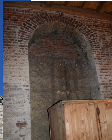
Afb. 24 Interieurzijde van de dichtgemetselde vensteropening
