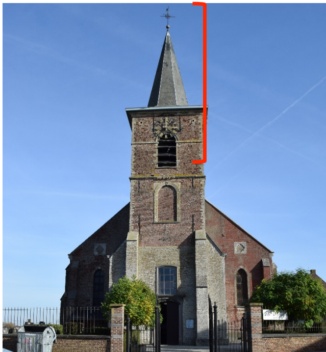
Afb. 31 Zicht op de westertoren van de kerk met situering van de 19 de -eeuwse ophoging van de kerktoren
