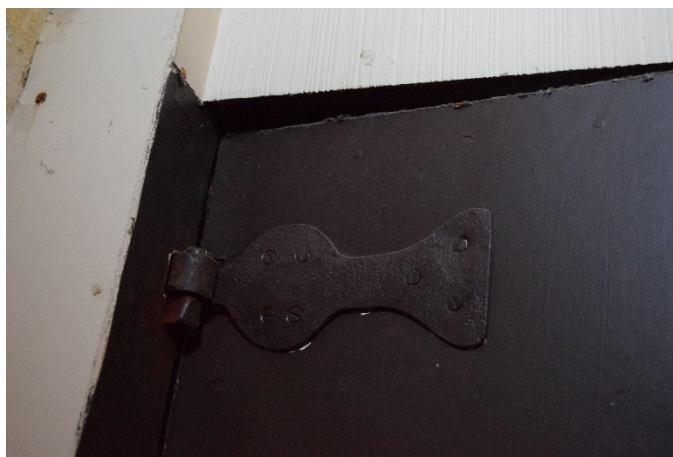
Afb. 6 Detail van het duimhengsels van de opgeklampte deur
