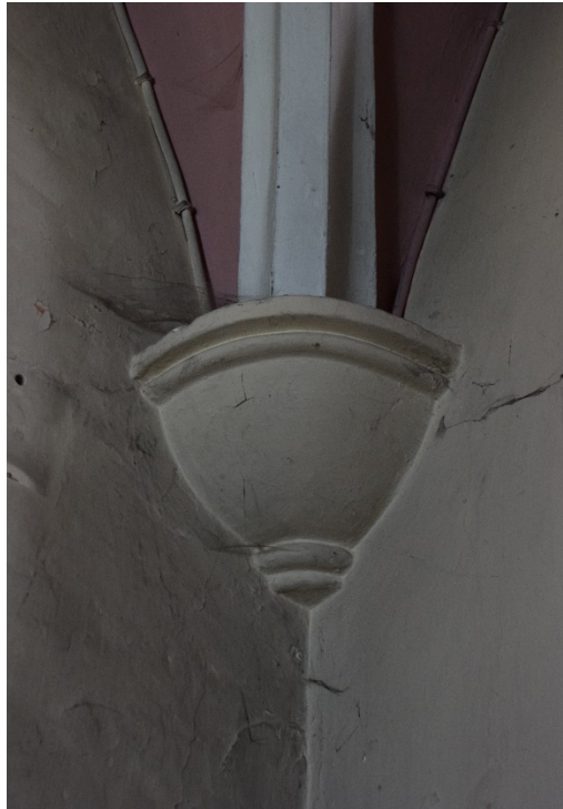
Afb. 12 Detail van het kruisribgewelf van het doksaal
