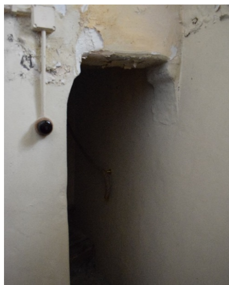
Afb. 7 Deuopening naar de torentrap
