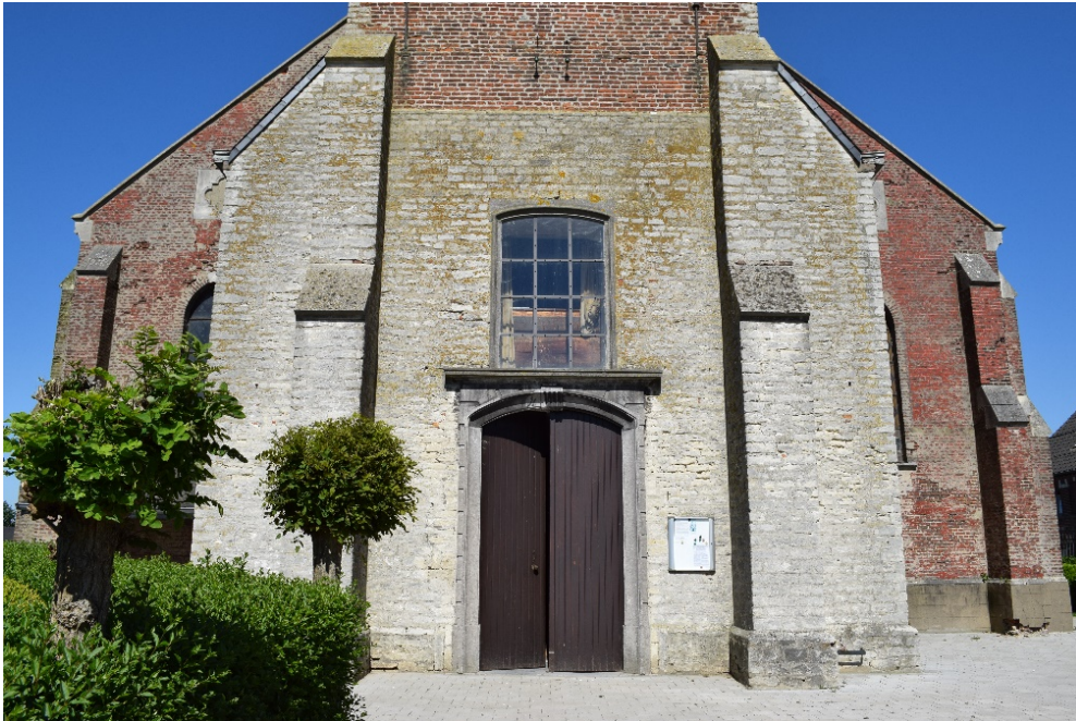
Afb. 2 Westertoren: zicht op de onderbouw met witstenen parement
