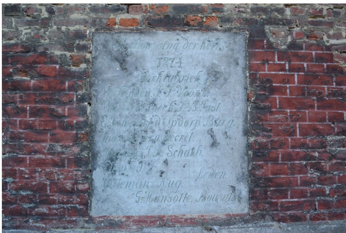
Afb. 39 Detail van de koorgevel met gedenksteen
