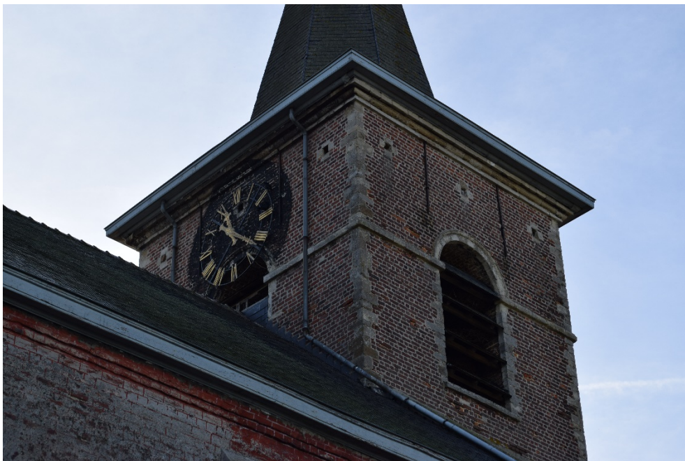
Afb. 66 Zicht op de zij- en achtergevel van de toren met torenuurwerk met schaduwschildering
