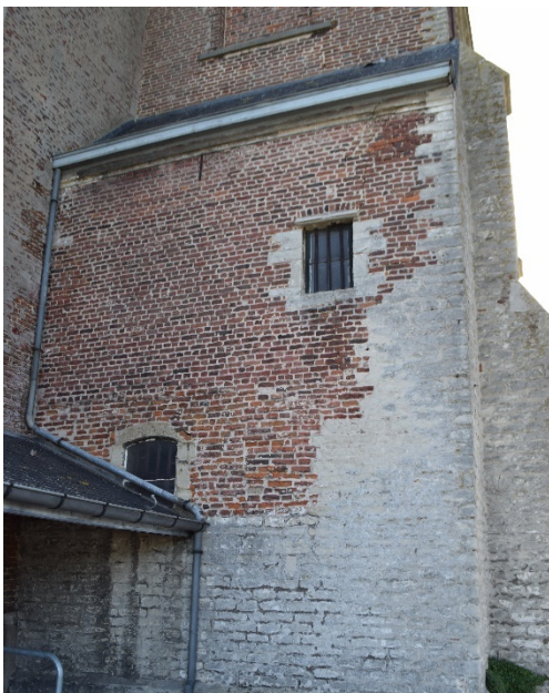
Afb. 3 Zijgevel van de toren aan de noordzijde
