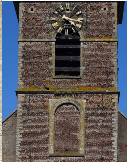
Afb. 65 Detail van de galmborden en vensteropening daaronder, alsook het torenuurwerk
