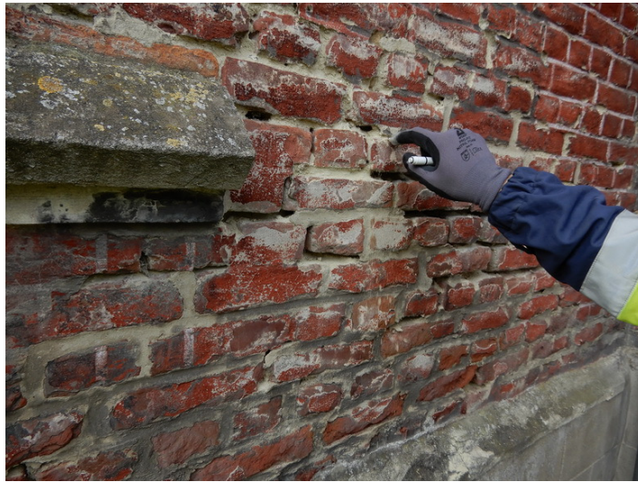
Fig. 15 Voeg- en legmortel sterk uitgelopen en verzand (verlies sterkte)
