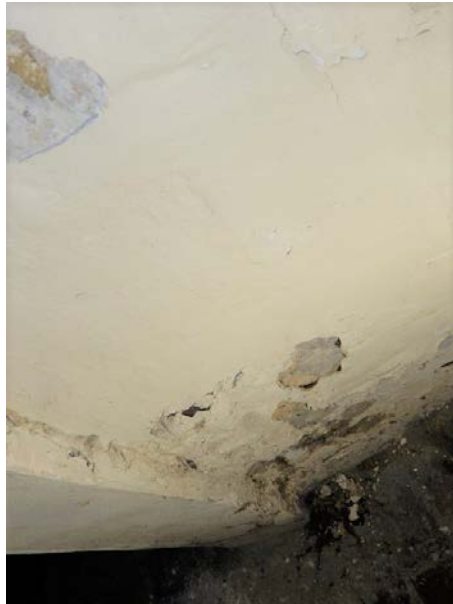
Fig. 7 Afbladderen van verf t.g.v. opstijgend vocht
