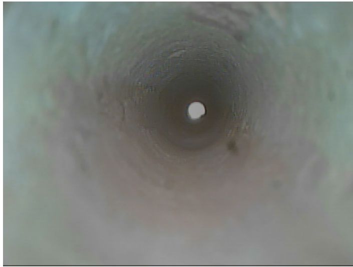
Fig. 21 Endoscopie E4_35 cm - homogeen, goed samenhangend baksteenmetselwerk
