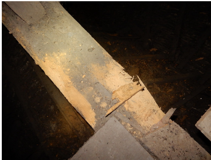
Fig. 9 Aanzienlijke houtaantasting t.g.v. houtborende insecten, graad van aantasting vast te stellen en op korte termijn een gepaste houtbehandeling uit te voeren
