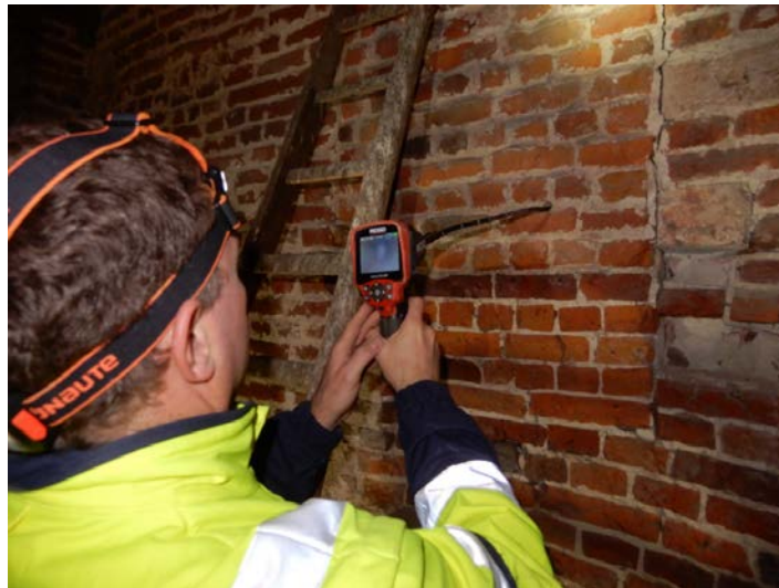
Fig. 17 Uitvoering endoscopie-opname E2 in zuidgevel toren t.h.v. blindraam
