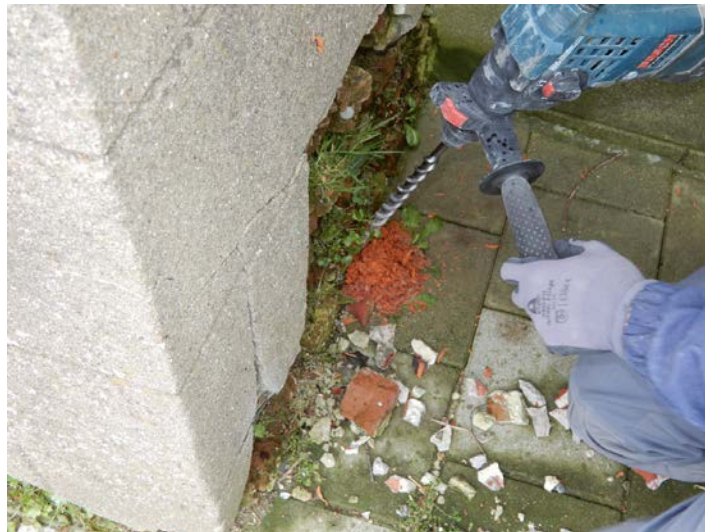
Fig. 23 Uitvoering puntboring P2 t.h.v. steunbeer noordelijke zijbeuk
