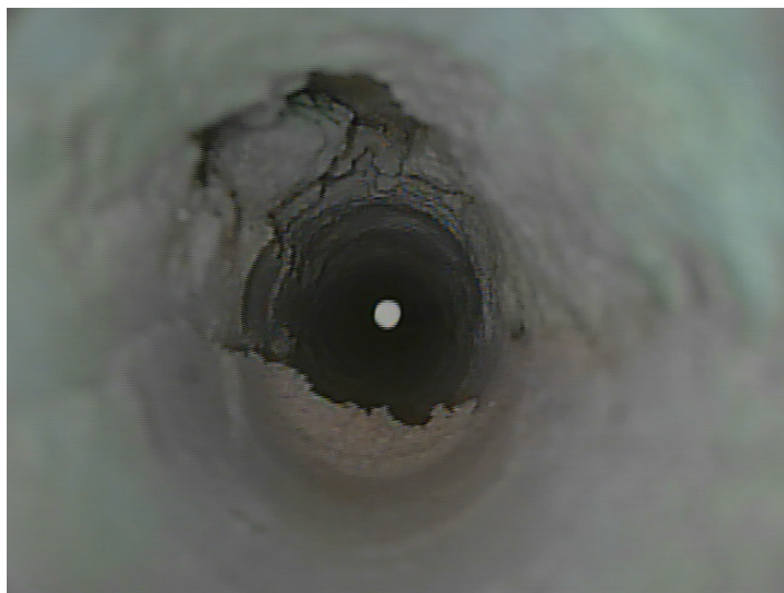
Fig. 22 Endoscopie E6_20 cm - uitgevallen voeg
