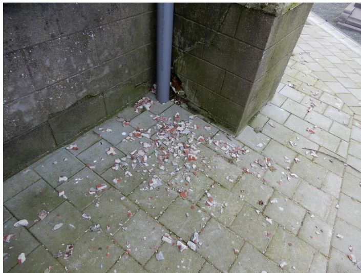
Fig. 14 Recent gevallen gevelbepleistering
