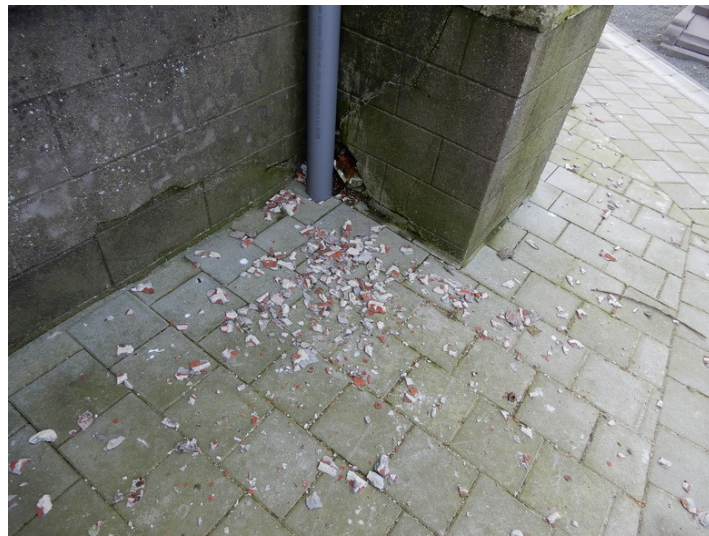
Fig. 14 Recent gevallen gevelbepleistering
