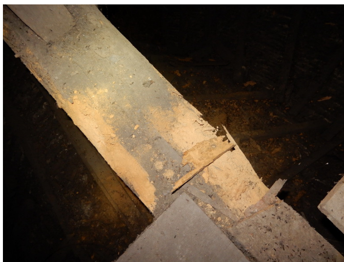
Fig. 9 Aanzienlijke houtaantasting t.g.v. houtborende insecten, graad van aantasting vast te stellen en op korte termijn een gepaste houtbehandeling uit te voeren
