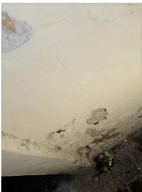
Fig. 7 Afbladderen van verf t.g.v. opstijgend vocht
