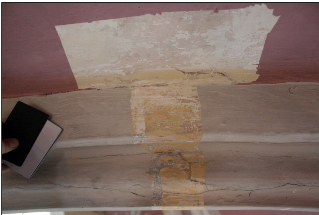
Figuur 14: vrijlegging van de Art Deco fase van een rib in de noordbeuk. Ook het grijs, rood en wit van de voorgaande fase schemeren door
