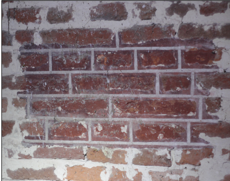
Figuur 2: Het proefvlak zoals te vinden op de zuidwand van de tweede verdieping van de toren. de techniek en kleuren zijn bijna gelijk aan de baksteenimitatie op het schip en koor, maar ze wijkt af omdat hier getrouw de voeg van de steen werd gevolgd, hier in een onregelmatig verband.
