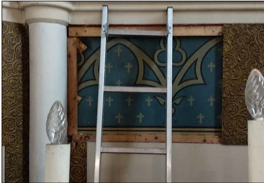
Figuur 5: het vrijgemaakte deel van de oostwand achter het hoofdaltaar.
