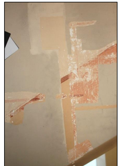
Figuur 13: vrijlegging van twee fasen op de band boven de gordelbogen. De band in Art Deco fase volgt getrouw die uit voorgaande fase.
