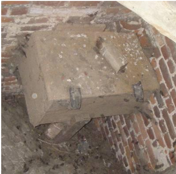
Fig. 7: Opening tussen uilennestbak en stellinggat (MW)
