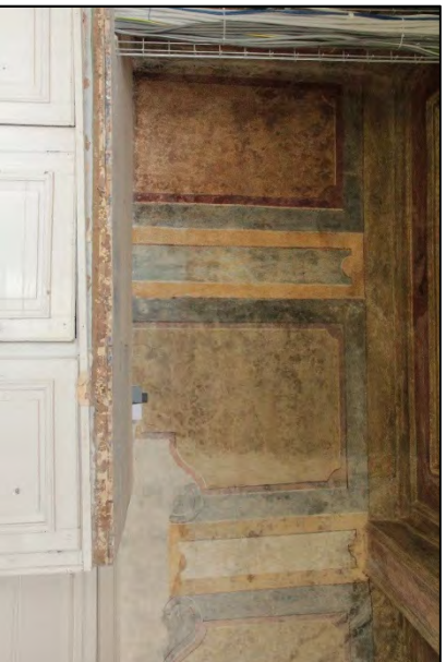
FIGUUR 92: DE ZONE VAN DE ZUIDOOSTELIJKE WAND BOVEN DE KAST, NA INVULLING EN RETOUCHE.
