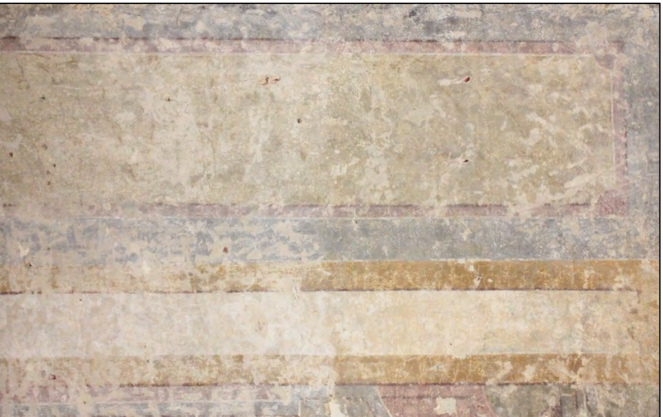
FIGUUR 75: RECHTER BOVENHOEK VAN DE NOORDOOSTELIJKE WAND VÓÓR RETOUCHE. DE PICTURALE LAAG IS STERK GEHAVEND.
