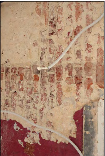
FIGUUR 60: BOUWSPOR VAN DE NU VERWIJDERDE WAND.
