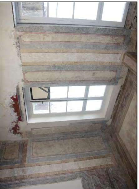
FIGUUR 69: ZICHT OP DE NOORDWESTWAND NA RESTAURATIE.
