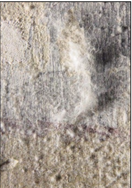
FIGUUR 109: GROENE SCHIMMEL. KOMT ZOWEL IN GROEP VOOR ALS IN PUNTEN VERSPREID OVER HET OPPERVLAK.
