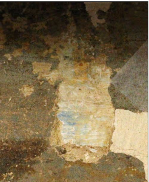
FIGUUR 57: VRUILEGGING NAAR DE SCHILDERING TER HOOGE VAN DE VERWIDDERDE HOEKSCHOUW.
