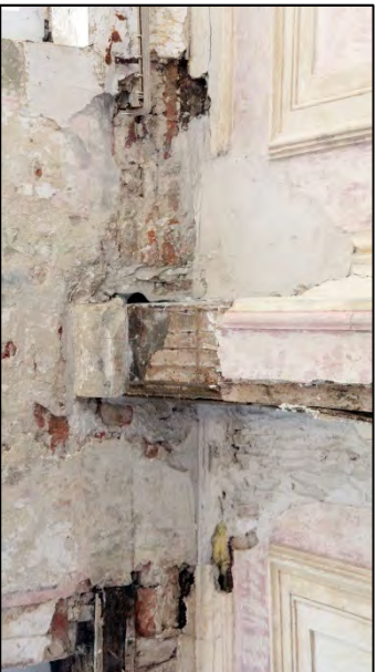
FIGUUR 124: ZONE ROND DE BALKOPHESTELLING NA SANERING VAN GEDEGRADEERD PLEISTERWERK.
