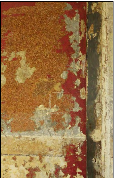
FIGUUR 83: DE OVERSCHILDERINGEN IN OUIVEER VAN DE PLINTZONE BEMOEILIJKEN DE VRIJLEGGING
