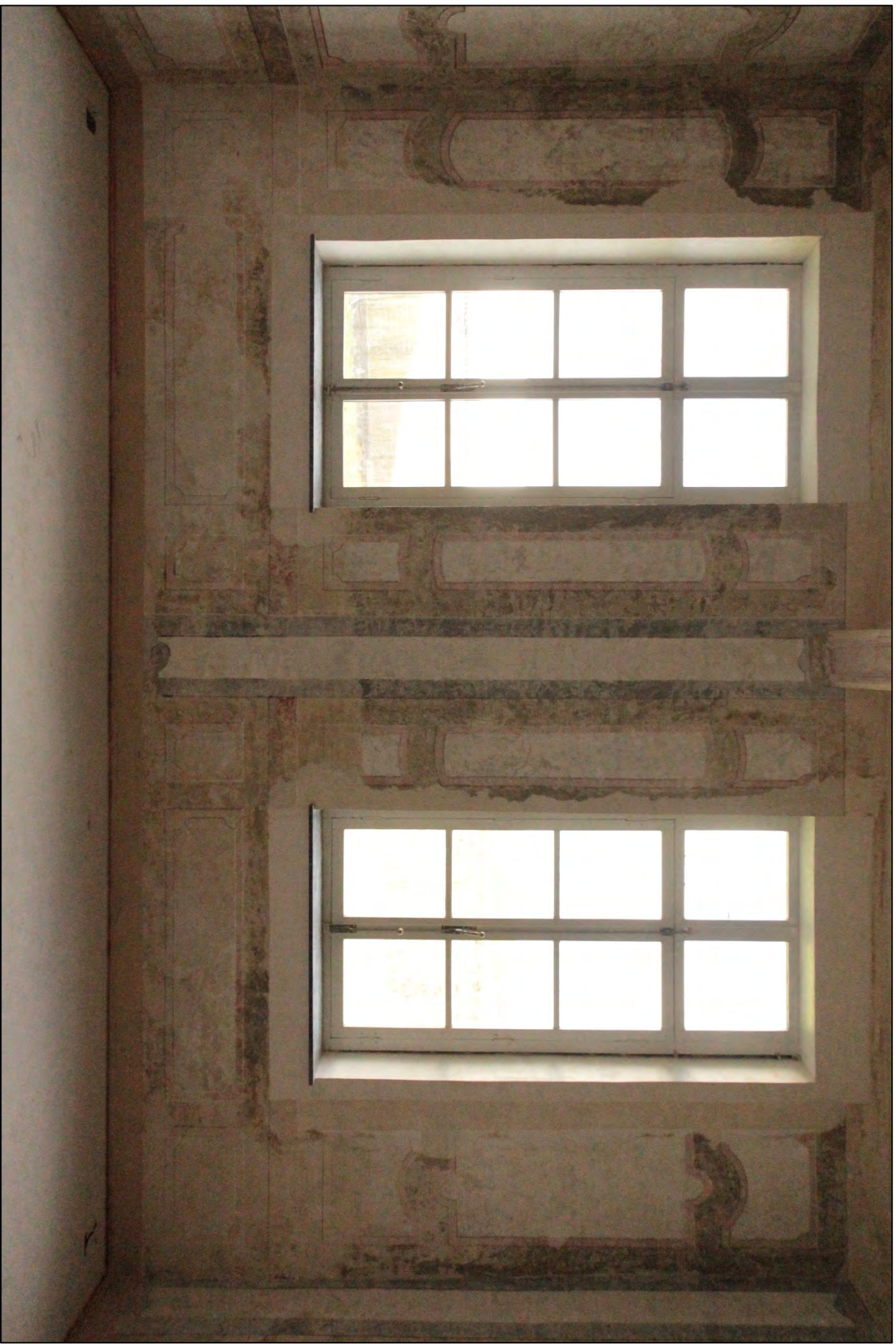
Overzichtsfoto eindresultaat van de zuidwestelijke wand.
