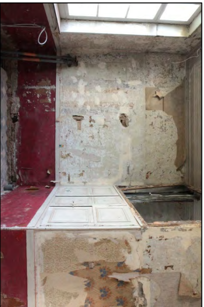
FIGUR 65: RUIMTE VOOR AANVANG VAN RESTAURATIE.
