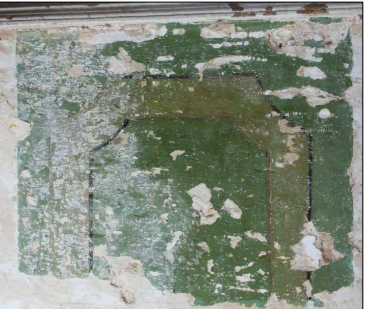
FIGUUR 53: GROENE PLINT TIJDENS HET VRIJLEGGEN EN REINIGEN.
