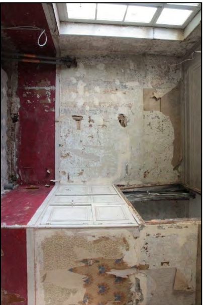
FIGUUR 56: ZICHT OP DE NOORDOOSTELIJKE WAND VOÓR AANWANG VAN DE WERKEN.
