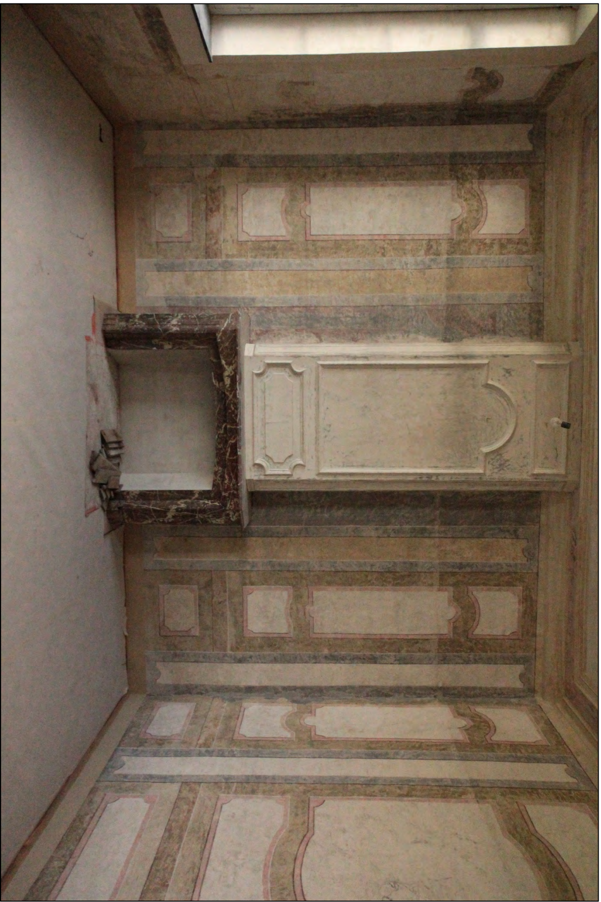
Overzichtsfoto eindresultaat van de noordwestelijke wand.
