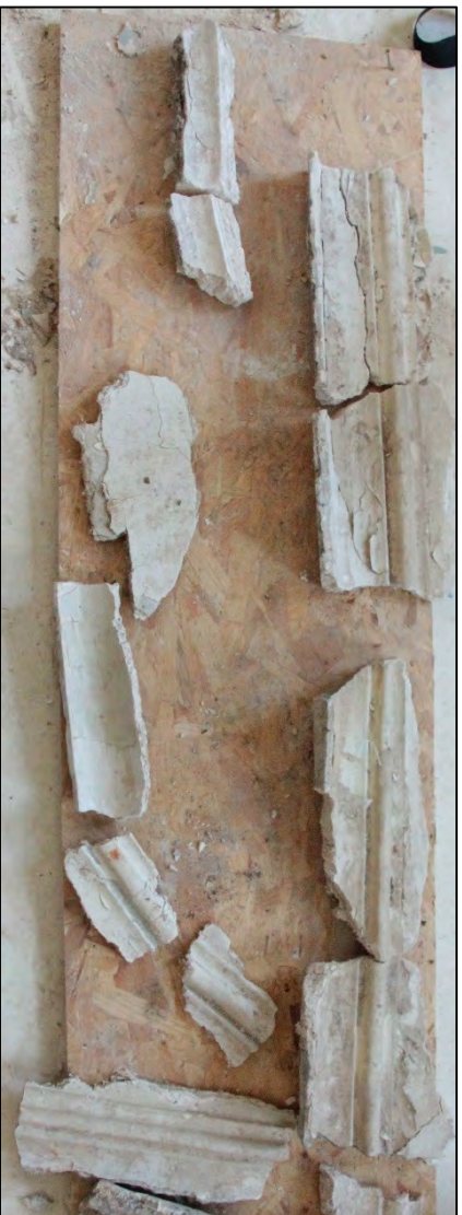
FIGUUR 34: RESTANTEN VAN HET LUSTWERK VAN HET PLAFOND EN DE KOEFELUST RONDOM DE SCHOUWBOEZEM.
