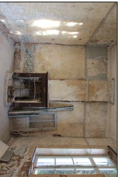
FIGUUR 128: NOORDOOSTELIJK AANZICHT VAN DE RUIMTE VOOR RESTAURATIE.
