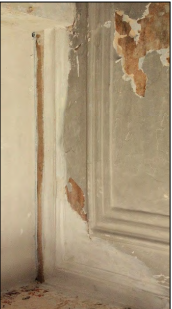
FIGUUR 87: TOESTAND TIJDENS VRIJLEGGING. DE KOOFFIJST WAS EEN RECONSTRUCTIE DOOR REMOTEC DIE LATER OPNIEUW DIENDE TE GEBEUREN.
