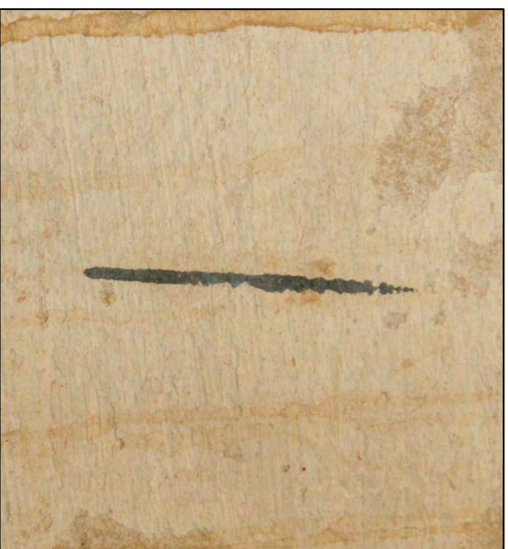
FIGUR 133: VERFRUPPER OP DE WAND LINKS NAAST DE SCHOUW BOVEN DE PLINTZONE.
