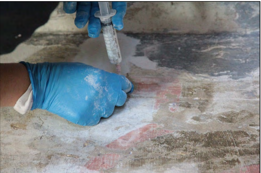
FIGUUR 117: INJECTIE MET KALKCASEÏNAAT.
