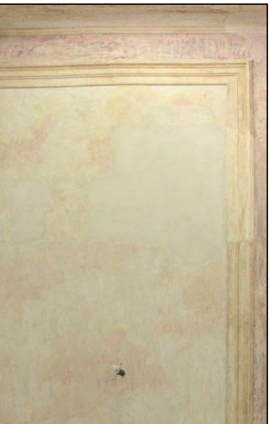
FIGUUR 126: DE GROTE LACUNE integreert goed in de schakeringen van het plafond.
