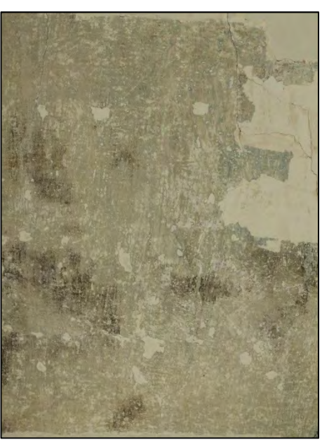
FIGUUR 52: DETAIL VAN DE BRUINGRIJZE RETOUCHES/OVERSCHILDERINGEN AANWEZIG OP HET OPERVAK.
