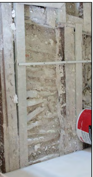
FIGUR 11: CONSTRUCTIE ROOSTERING VERWIJDERDE SCHOUWKANAAL RUIMTE 0.4.
