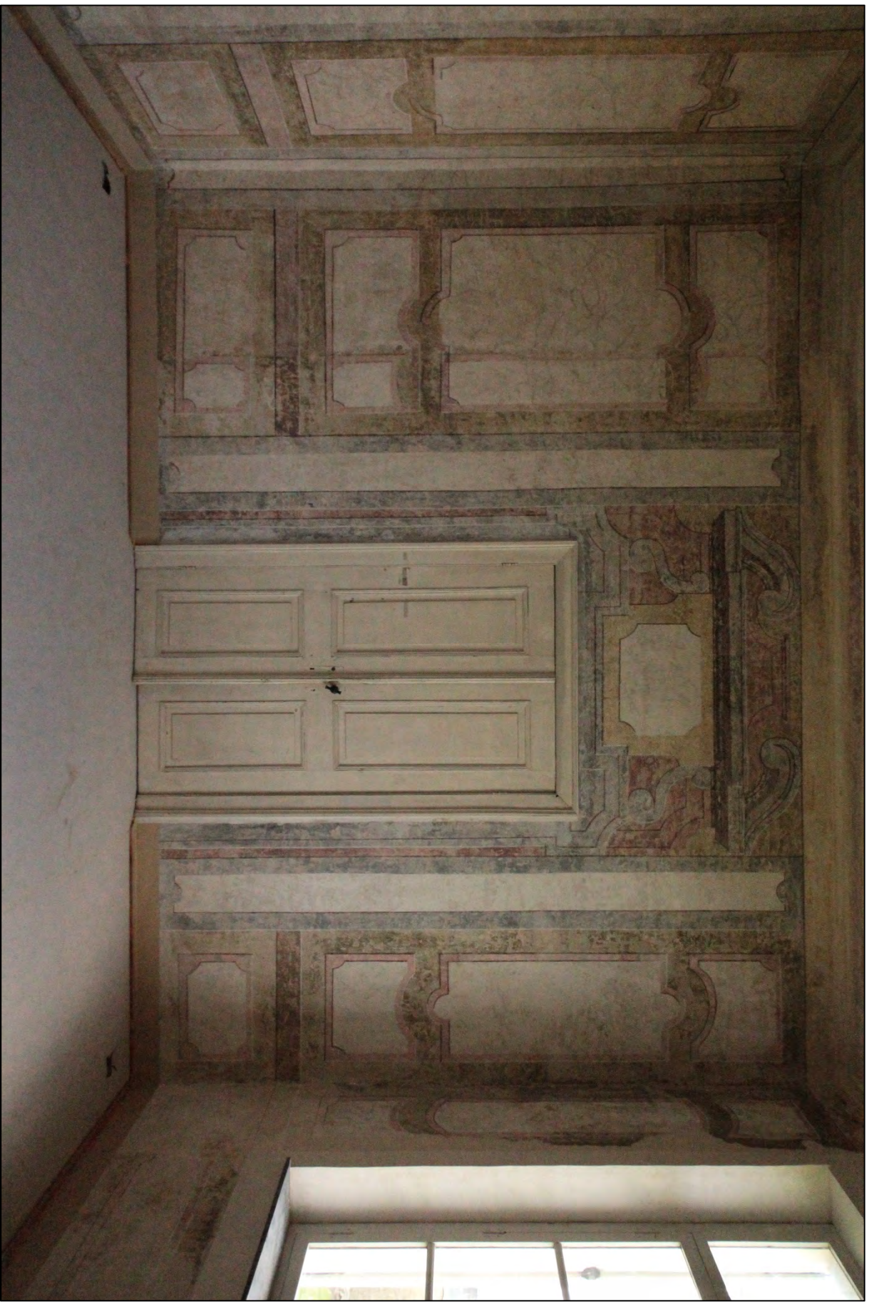
Overzichtsfoto eindresultaat van de zuidoostelijke wand.
