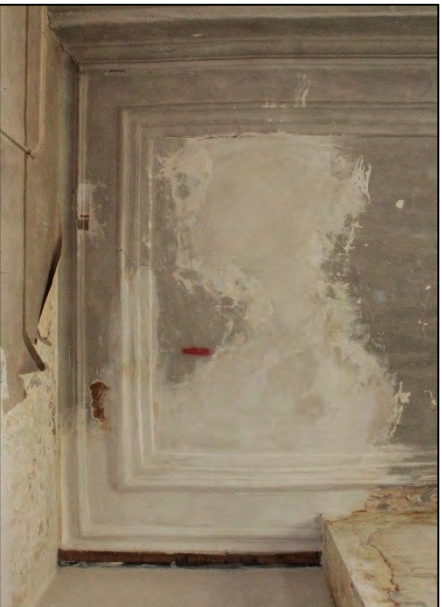
FIGUUR 90: DE REEDS UITGEVOERDE RECONSTRUCTIE VAN LIJSTWERK EN DE CENTRALE INVULLING, ZOALS UITGEVOERD DOOR RENOTEC VOOR AANVANG VAN ONZE WERKEN.
