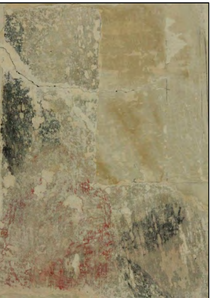
FIGUUR 49: GEDEELTELIJK VRIJGELEGDE ROOS, IN DE LINKER BOVENHOEK DE STAPPEN VAN VRIJLEGGING, MET ONDERAAN LIJMVERVERFEN, DAARBOVEN KALKVERFEN; DE DISPERSIEVERFEN ZIJN REEDS VERWIDDERD.
