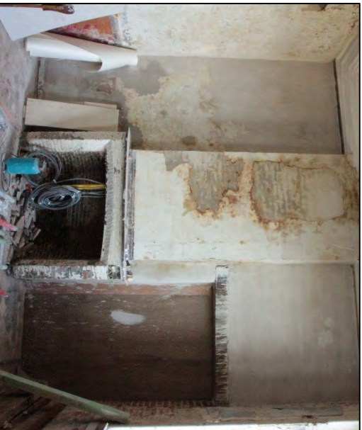
FIGUUR 59: TEN WESTEN VAN DE SCHOUW IS EEN DEUROPENING GEWAAKT.
