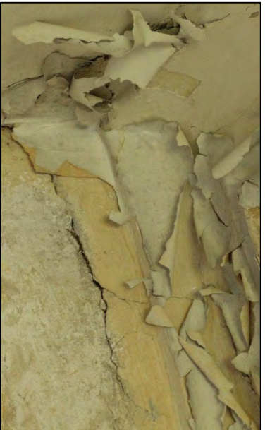
FIGUUR 121: AANSLUITING VAN KOOFIJSTEN MET WAND. DE LAATSTE SYNTHETISCHE VERFLAG MOET ZOWEL OP PLAFONDS ALS OVERHEEN BESTAAND BEHANGPAPIER OP DE WANDEN ZIJN AANGEBRACHT.
