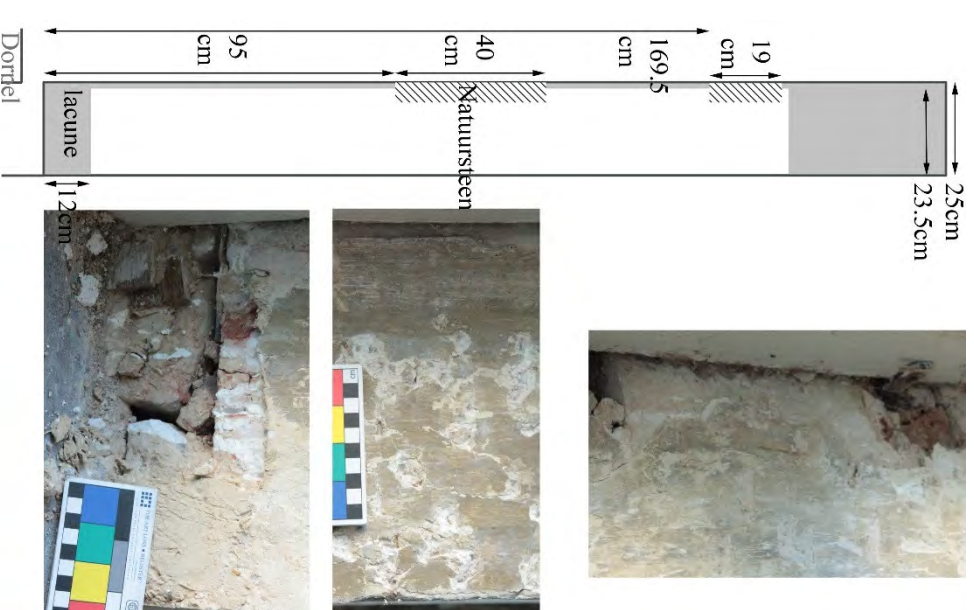
FIGUUR 100: SCHEMATISCHE WEERGAVE VAN BEVINDINGEN OMTRENT DE RECHTER DAGKANTEN VAN HET MEEST ZUIDELIJKE VENSTER. ER WERD GETRACHT SPOREN TE VINDEN VAN EEN VERWIJDERD KALF VAN DE OUDERE KRUISMONIEN. DE NATUURSTEEN OP DE LINKER DAGKANT ZIT ECHTER OP ANDERE HOOGTEN (1STE STEEN VAN 38CM HOOG OP 67CM, TWEEDE STEEN SLECHTS 7CM EN OP 138 HOOGTE. DE NATUURSTEEN IS GEDELTIELIJK OVERSCHILDERD.
