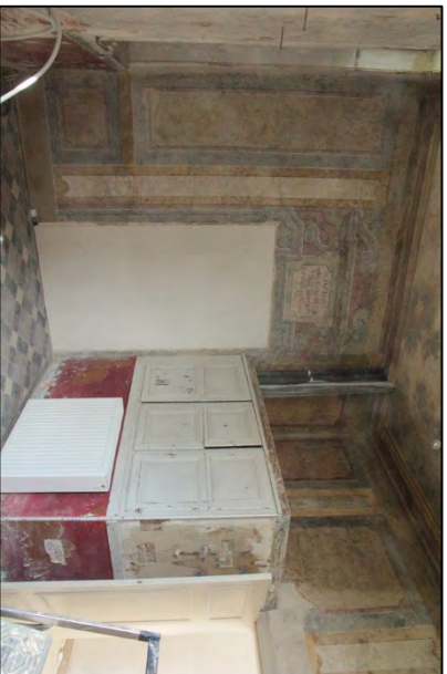
FIGUR 65: RUIMTE NA RESTAURATIE VAN DE NOORDOOST EN ZUIDOOST WAND.
