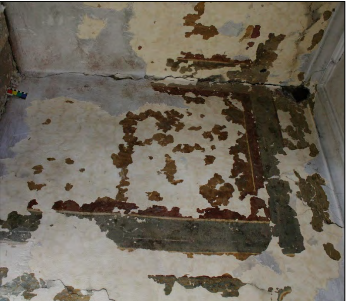
FIGUUR 8.1: VRIJLEGGEN VAN DE MUURSCHILDERING
