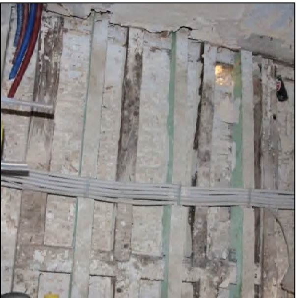
FIGUR 12: CONSTRUCTIE ROOSTERING VERWIJDERDE SCHOUWKANAAL RUIMTE
