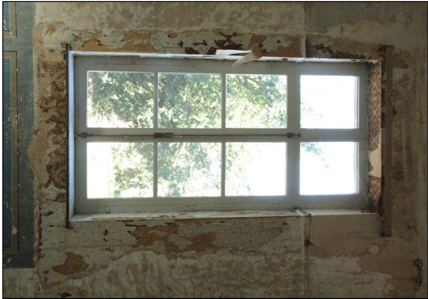
FIGUUR 129: RONDOM DE VENSTEROPENINGEN IS DUIDELIJK ZICHTBAAR DAT ER AANPASSINGEN HEBBEN PLAATSGEVONDEN. HIER HET ZUIDELIJKE VENSTER.
