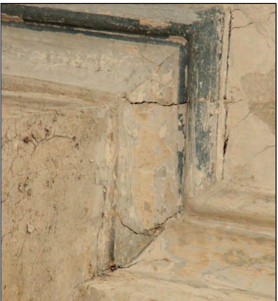
FIGUR 134: DE POLYCHROME EINDIGT TER HOOGTE VAN DE AANSLUITING MET DE WAND.
