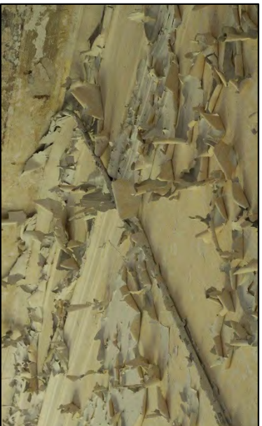
FIGUUR 121: VERREGAANDE AFWERPING VAN DE BOVENSTE VERFLAGEN TEN GEVOLGE HET GEBRUIK VAN NIET COMPATIBELE VERSYSTEMEN.
