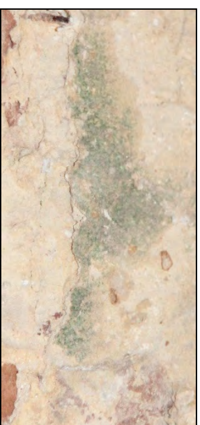
FIGUUR 109: GROENE SCHIMMEL. KOMT ZOWEL IN GROEP VOOR ALS IN PUNTEN VERSPREID OVER HET OPPERVLAK.
