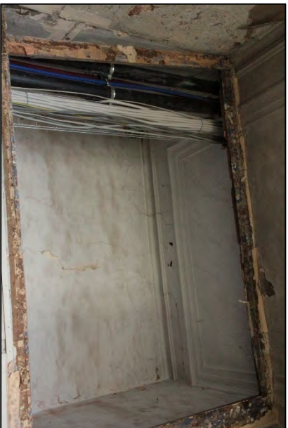
FIGUUR 77: DE TOESTAND VAN DE WAND EN PLAFOND IN DE KAST IS OPMERKELIJK BETTER DAN ELDERS DOORDAT VERF NOOIT AFGESTOKEN IS GEWEEST IN DIT VERBODGEN COMPARTIMENT.
