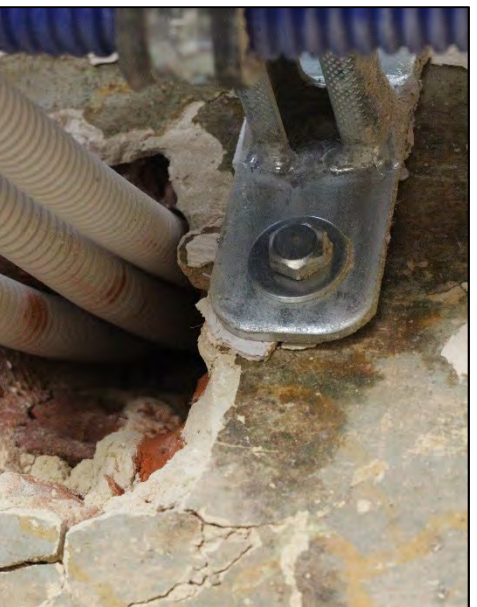
FIGUUR 55: ELEKTRICITEITSLIEDINGEN ZIJN DOOR DE WAND GETROKKEN.
