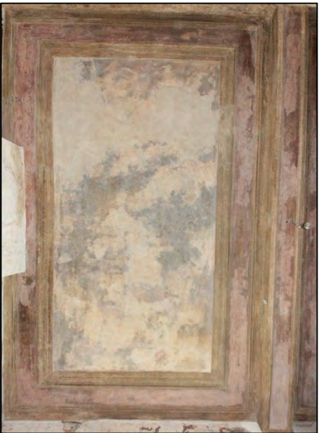
FIGUR 71: ZUIDWESTELIJKE PLAFONDVELD NA RESTAURATIE.
