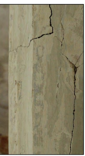
FIGUUR 51: BIJ HET SCHILDERKLAAR MAKEN VAN HET PLAFOND DOOR RENOTEC KOMT PLAATSELIJK DE PLAFONDSCHILDERING ZICHTBAAR EN BESCHADIGD. DE ORIGINELEKLEURSTELLING KAN OP DEZE WIJZE WEL AFGELEZEN WORDEN.
