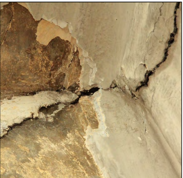
FIGUUR 83: DE OVERSCHILDERINGEN IN OUIVEER VAN DE PLINTZONE BEMOEILIJKEN DE VRIJLEGGING
