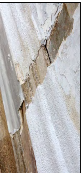
FIGUUR 91: DETAIL TIJDENS VRIJLEGGING VAN DE LIJST WAAR DE RECONSTRUCTIE VAN RENOTEC OVERHEEN WAS GESMEERD. DE RECONSTRUCTIE LAG SOMS BIJNA EEN CM BOVEN HET WERKELIJKE NIVEAU.
