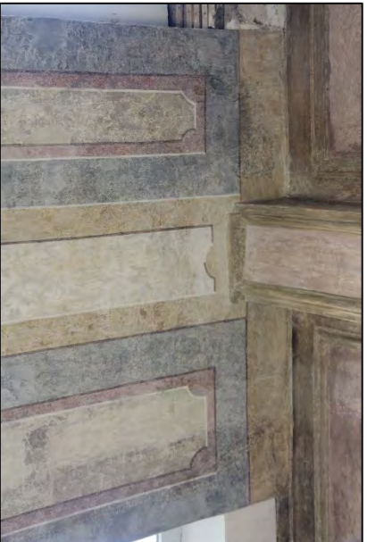
FIGUUR 86: DETAIL VAN DE NOORDWESTWAND NA RETOUCHE. DE LACUNES ZIJN LICHT ONDER TOON GERETOUCHERD.
