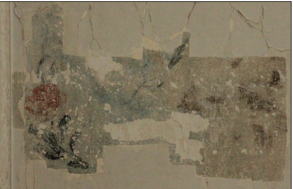
FIGUUR 47: GROTERE VRIJLEGGING OP HET PLAFOND, UITGEVOERD DOOR DE AANNEMER VAN LOT 1. DE LICHTBLAUWE FASE MET GESCHILDERDE ROOS IS DE OUDSTE FASE, DE BEIGE BRUINE ACCENTEN BOVENAAN ZIJN EEN LATERE FASE/RETOUCHE.
