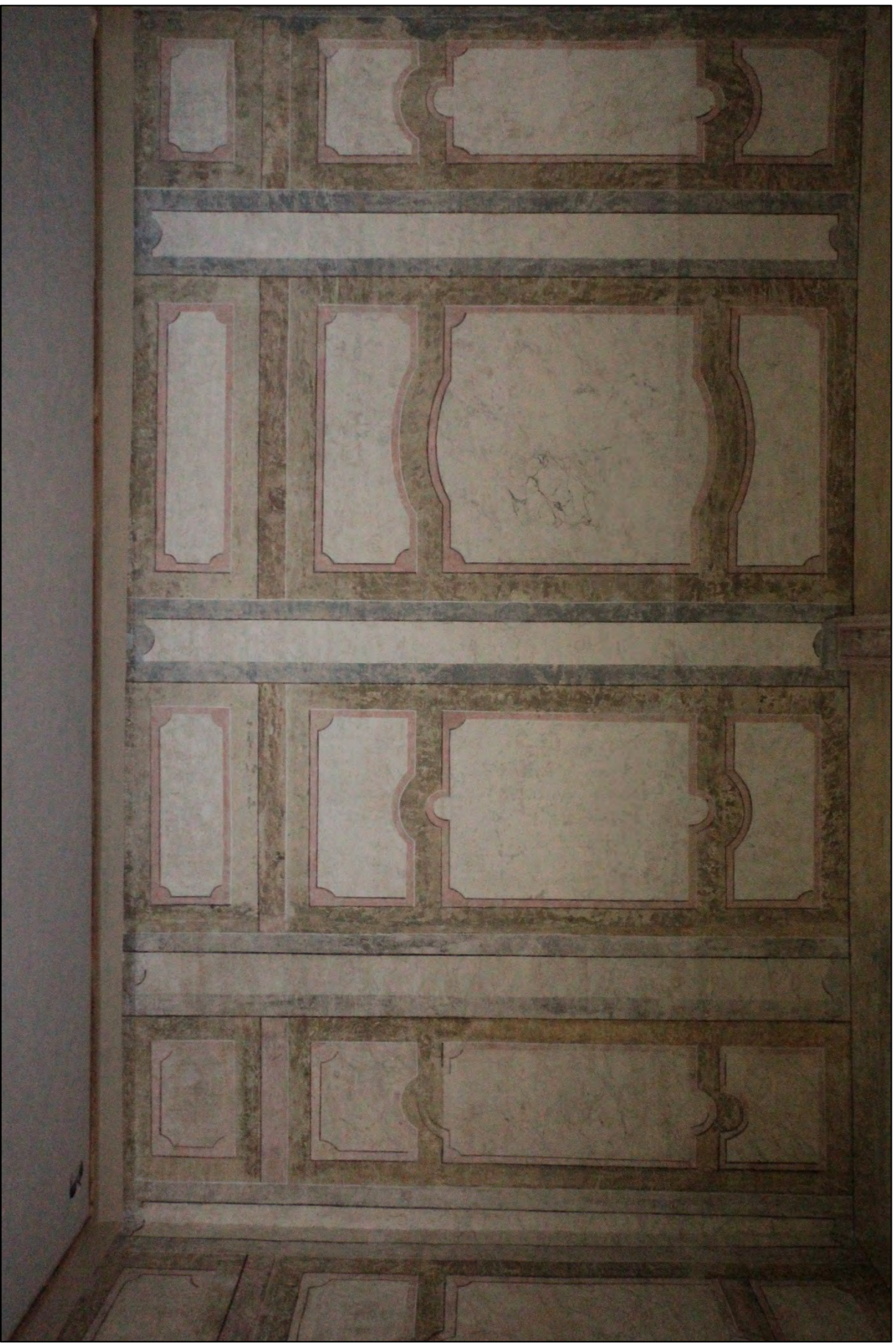
Overzichtsfoto eindresultaat van de noordoostelijke wand
