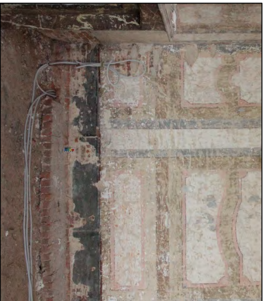
FIGUR 94: DETAIL BIJ AANVANG DER WERKEN. DE VLOER WAS VERWIJDERD TOT OP DE BAKSTEEN KELDERGEWELVEN EN ELECTRICITEITSLIDINGEN WAREN IN DE VLOER GELEGD.
