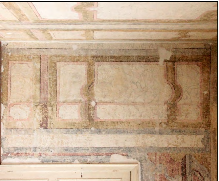
FIGUUR 105: DE HOEK WAAR DE SCHOUW VERWIJDERD WAS TOONT DUIDELIJK, MET ALLE ONVOLKOMENHEDEN, HOE DE BESTAANDE PANEELSCHILDERING DOORGETROKKEN WERD. DIT MAG GEZIEN BLIJVEN.
