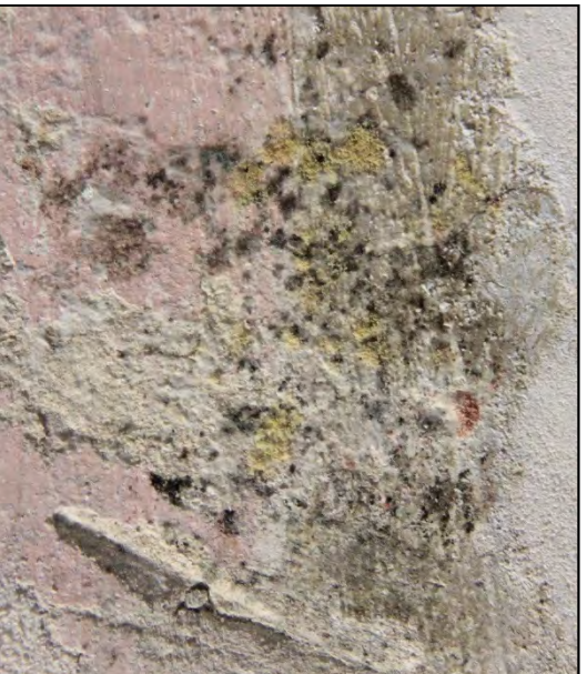
FIGUUR 107: ZWARTE EN GELE SCHIMMEL IN RUIMTE 0.3.
