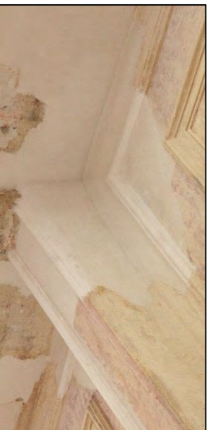
FIGUUR 124: ZELFDE ZONE NA AANBRENGEN VAN NIEUW DRAGER MET WILGENTAKKEN EN KOPERDRAAD.
