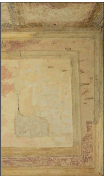
FIGUUR 95: HET AANGEVULDE LIJSTWERK VAN HET PLAFOND WAAR DE HOESCHOUW VERWIDDERD WERD. HET LIJSTWERK IS UIT DE HAAK, NIET RECHT EN DE KLEUREN NIET PASSEND.
