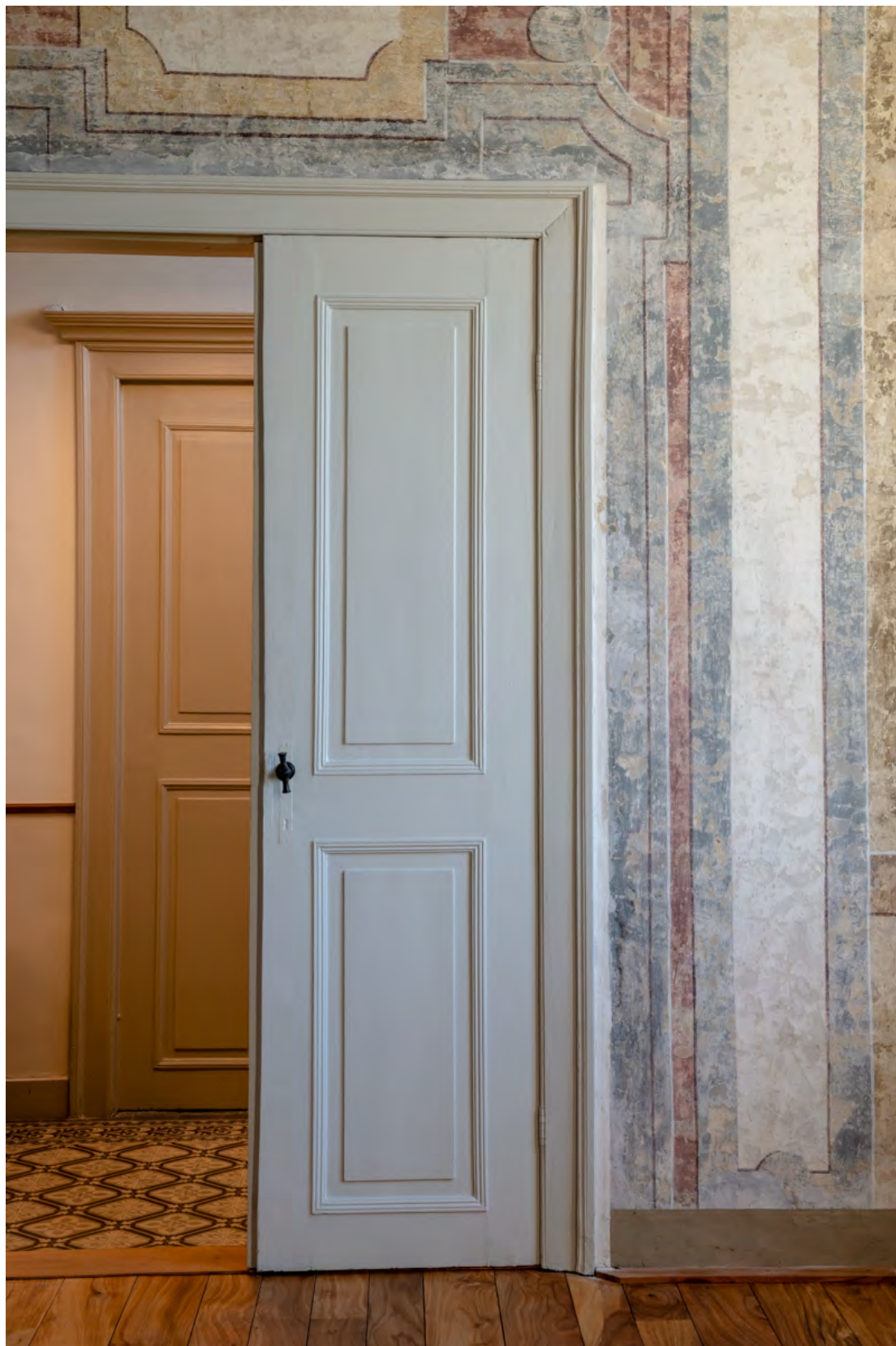
Figuur 48: Dubbele paneeldeur in kamer 03 (DVC).
