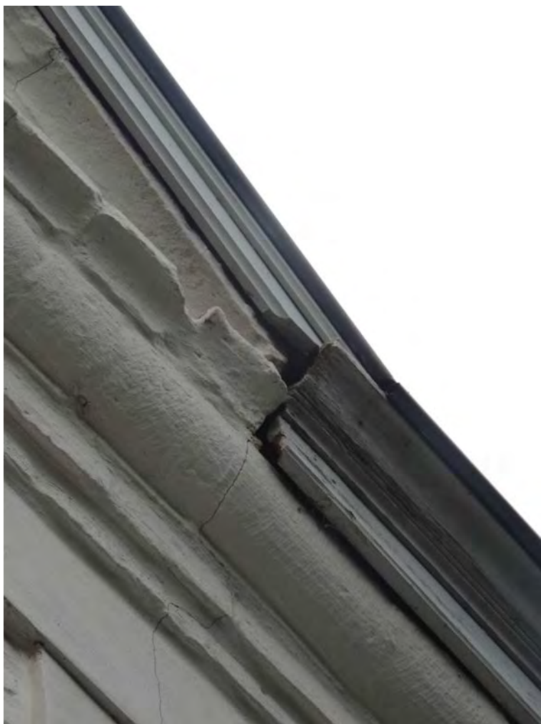
Figuur 38: ZO-gevel: aansluiting tussen lijst in natuursteen en kroonlijst (GG)
