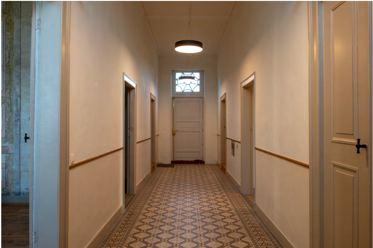
Figuur 44: De inkomhal met een vloer in cementtegeltjes. (gekeken van NW naar ZO) (DVC)
