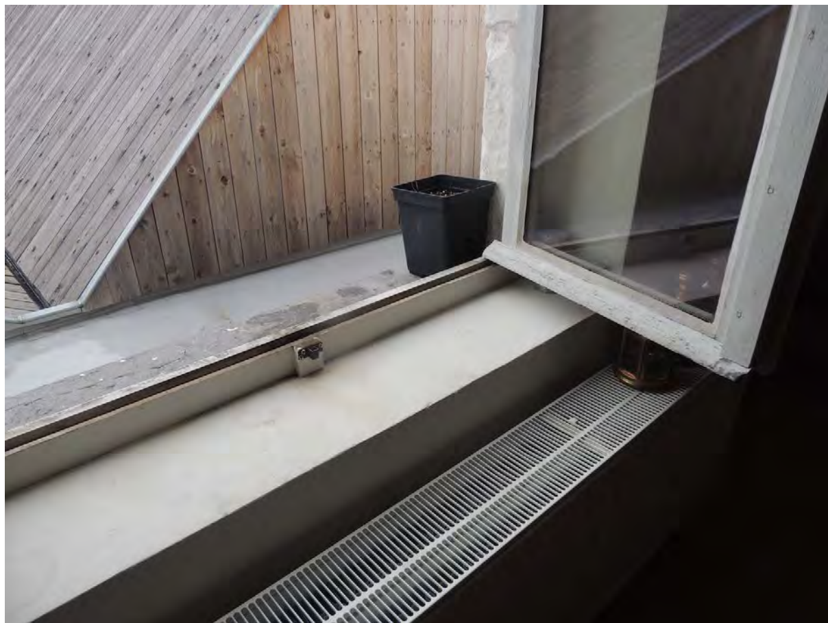
Figuur 43: Het schrijnwerk is schraal geworden en dient geschilderd (GG).
