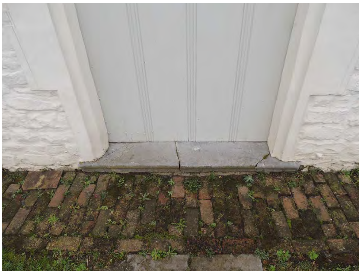
Figuur 39: Deurdorpel in de NW-gevel is gebarsten. Het pad in keramische steentjes rond de pastorie dient regelmatig onderhouden te worden (GG).
