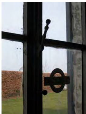
Afbeelding 45h: pompspanjolet met langwerpige uiteinde in messing en bolvormige trekker in messing.
