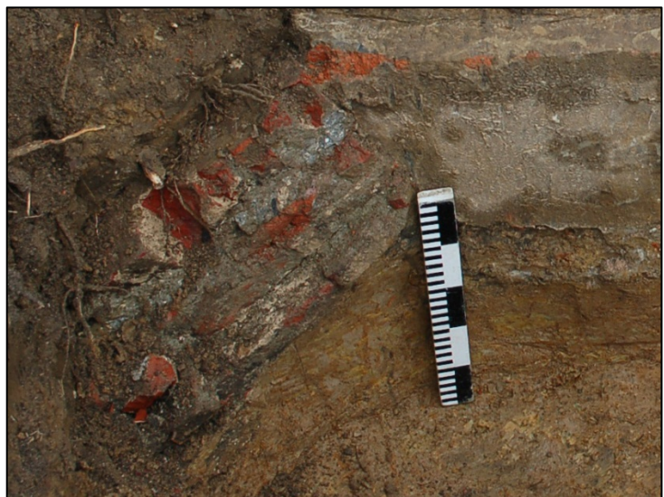
Fig. 18: bijkomende bakstenen fundering.
