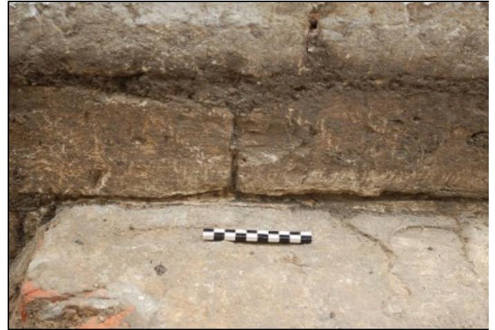
Fig. 20: bouwnaad tussen de oostelijke opgaande muur en de bijkomende fundering.
