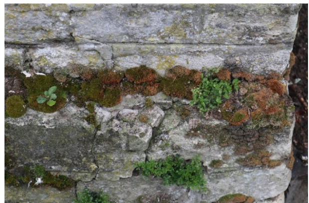
Figuur 24: Detail van schade en mos begroeiing op plint, 2020
