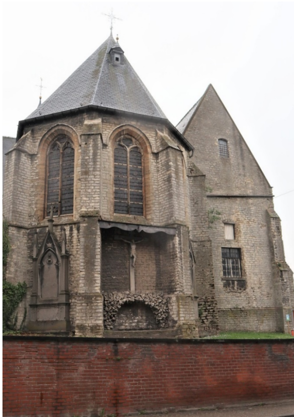
Figuur 12: Zicht op het koor en sacristie, 2020
