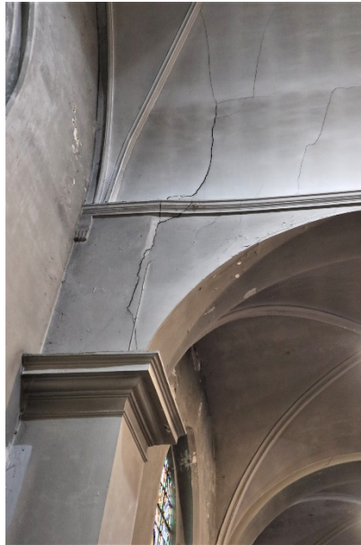
Figuur 59: detail van de structurele scheur in zuidelijke transept naar zijbeuk, 2020
