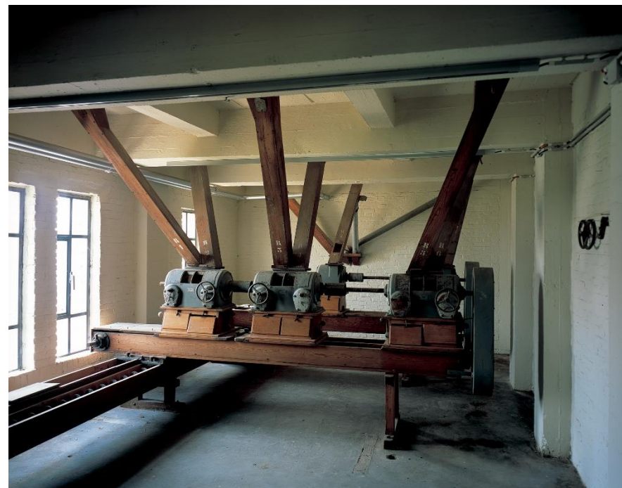
LMS-menginstallatie op de vijfde verdieping.
