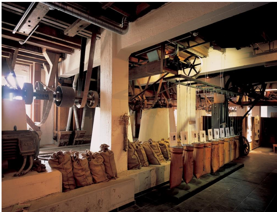
Het transmissiesysteem op de gelijkvloerse verdieping.
