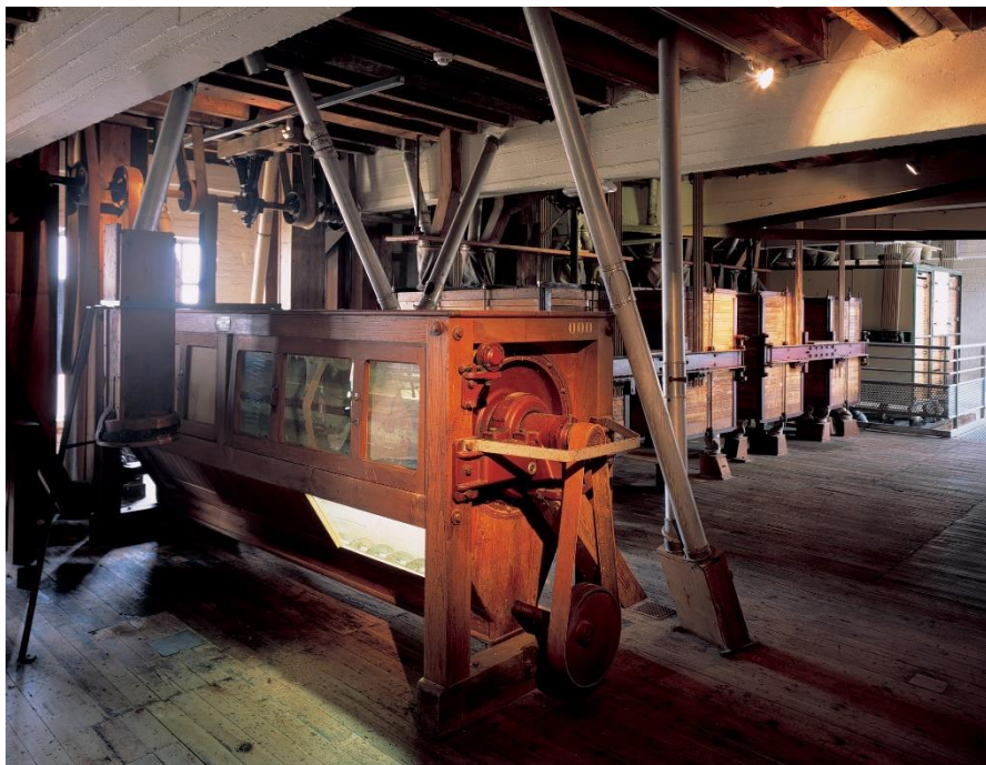
Vierde verdieping met veiligheidsbuil en plansichters.
