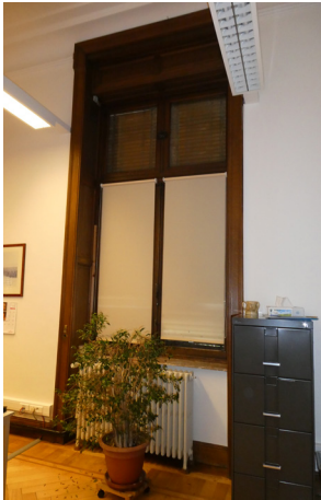
afb. 131: Raamopening met rolluiken en verduisteringsgordijn
