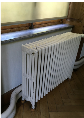
afb. 97: Gietijzeren verwarming
