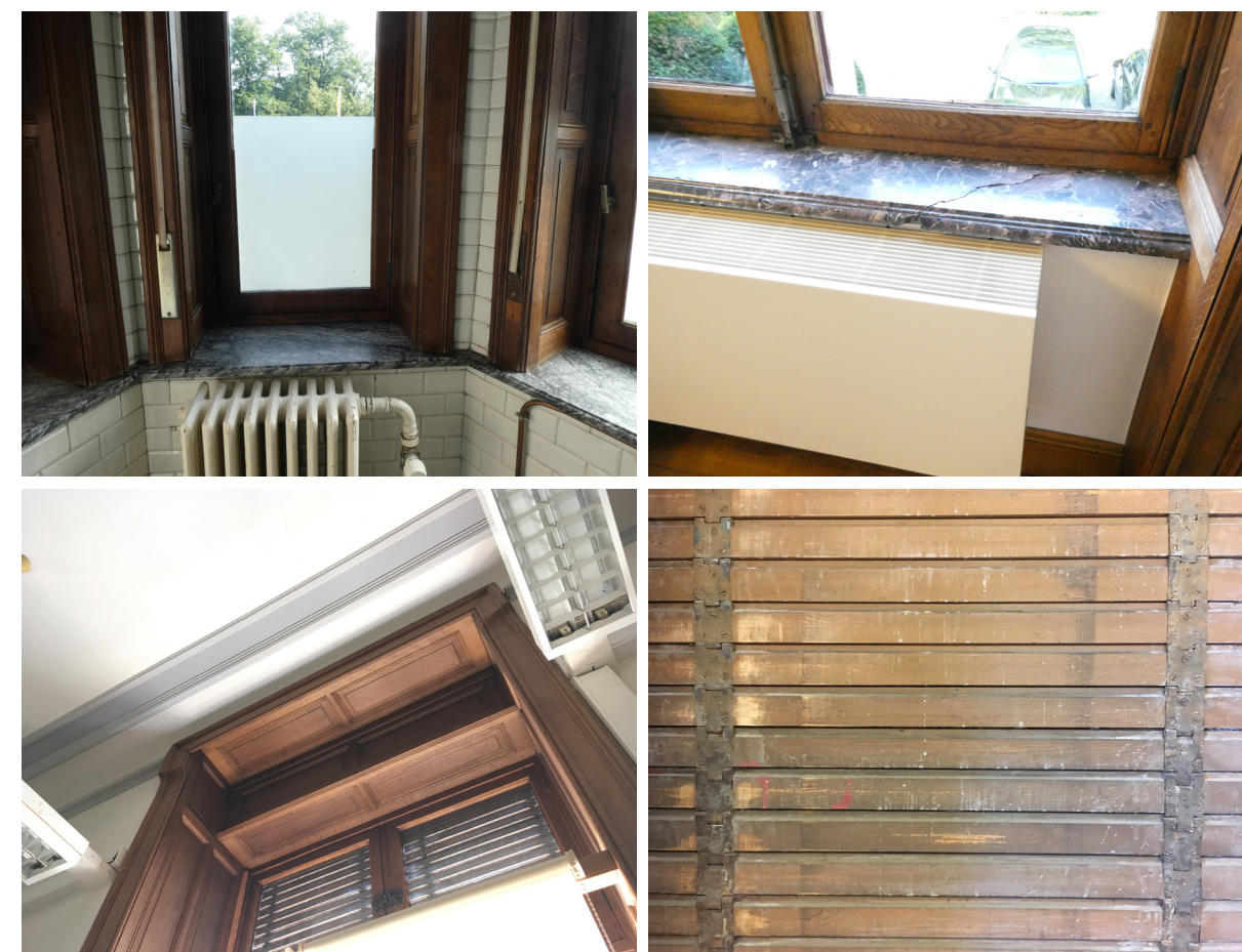
afb. 46: Details van de binnenzijde van het raamschrijnwerk, v.l.n.r.: ramen in de toiletruimte aan de inkomhal op het gelijkvloers, een marmeren vensterbank van een raampartij in de kantoren op het gelijkvloers, typische vormgeving van de dagkanten in het hele kasteel en detail van de oorspronkelijke houten rolluiken.
