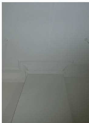
afb. 100: De geprofileerde moulures van het plafond
