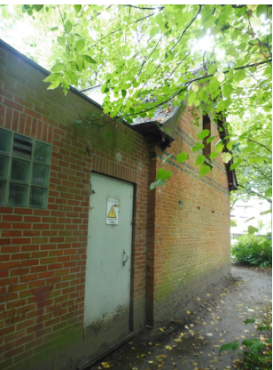
afb. 202: Zicht op de zijgevel
