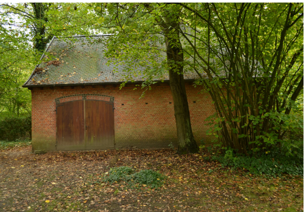
afb. 201: Zicht op de zijgevel
