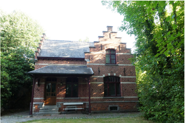
afb. 242: De voorgevel van de conciërgewoning
