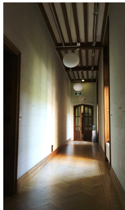
afb. 87: Segmentboogvormige omijsting naar de inkomhal toe en visgraatparket met blokrand als vloerbedekking in de gang
