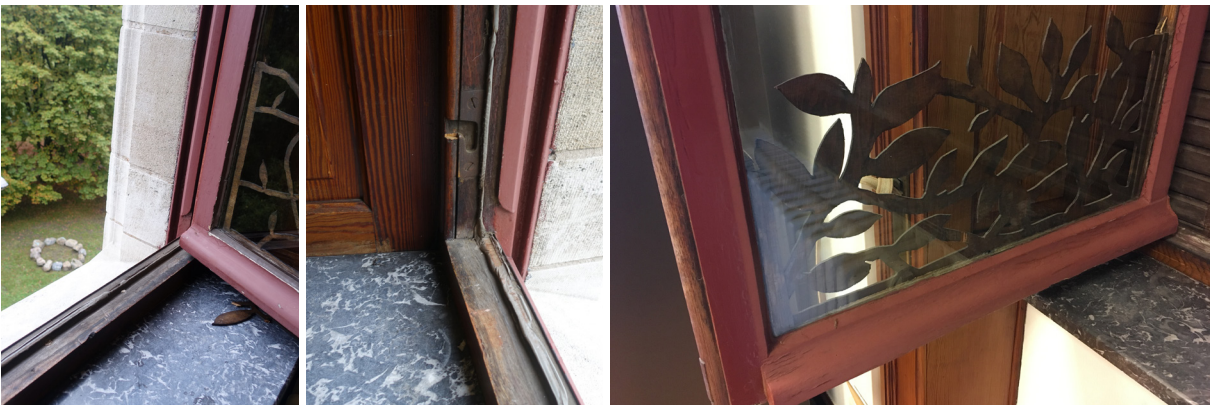
afb. 239: Details van het raam schrijnwerk
