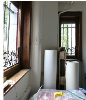
afb. 119: Oorspronkelijk raamschrijnwerk
