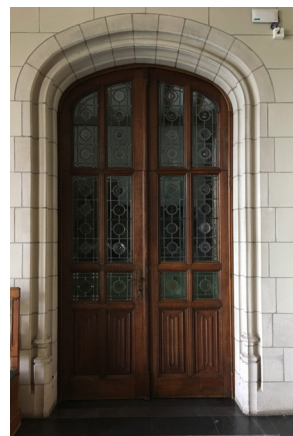
afb. 50: Oude doorgang naar bijruimte kapel, vandaag barzone
