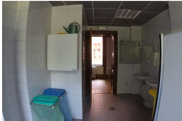
afb. 92: Zicht op de sanitaire ruimtes
