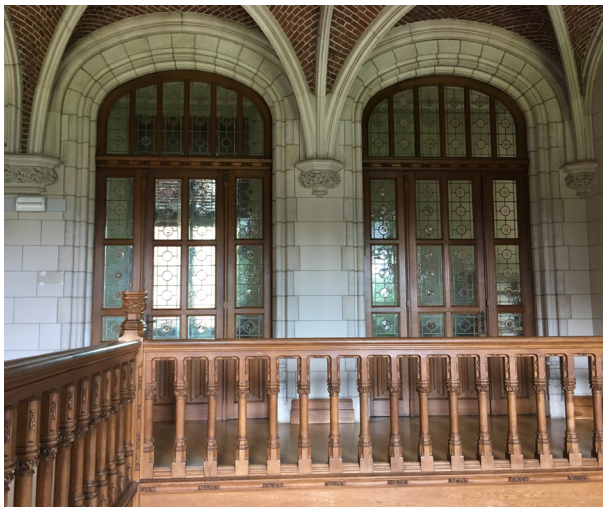
afb. 75: De balustrade van de steektrap op de eerste verdieping
