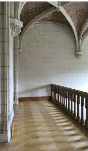
afb. 74: Bakstenen gewelfschelpen in het natuurstenen kruisribgewelf
