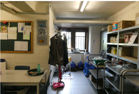
afb. 238: Nieuwe binnenmuren van snelbouwsteen in de kelder
