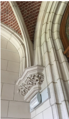
afb. 74: Bakstenen gewelfschelpen in het natuurstenen kruisribgewelf
