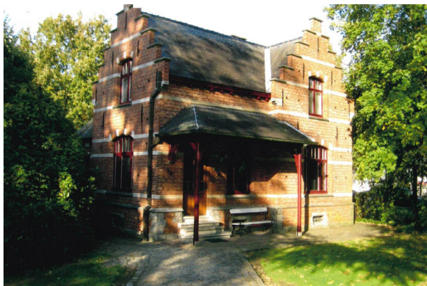
afb. 38: Het portiershuis werd samen met het kasteel opgetrokken © 100 jaar Kasteel Gravin Jeanne de Merode, p. 65
