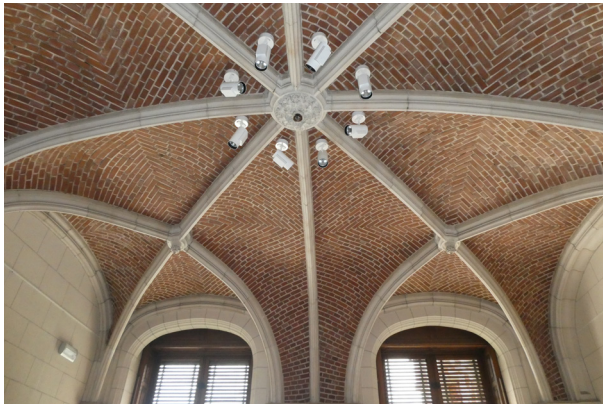
afb. 73: Bakstenen gewelfschelpen in het natuurstenen kruisribgewelf
