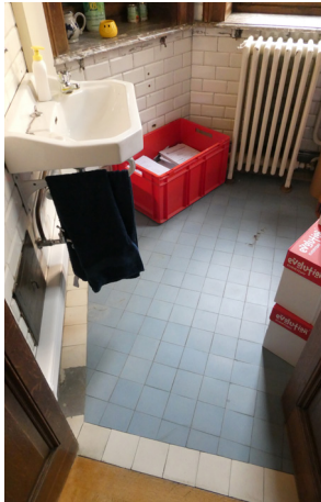
afb. 129: Oorspronkelijke tegelbekleding in de torenkamer
