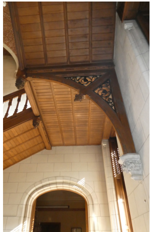
afb. 71: Houten console met smeedwerk
