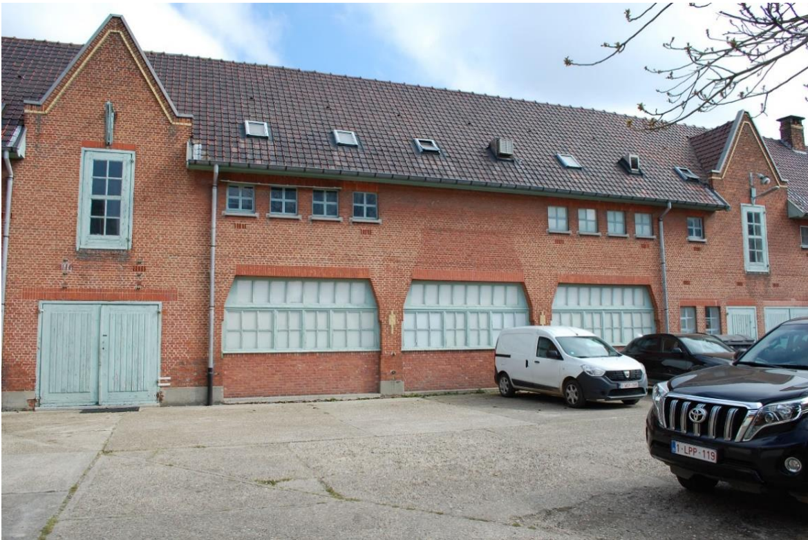
66 – Rechtervleugel van het hoofdgebouw van TRANSfarm te Lovenjoel met stallingen die later gedeeltelijk dichtgemetseld en voorzien van ramen zijn. Foto KU Leuven, Technische Diensten.
