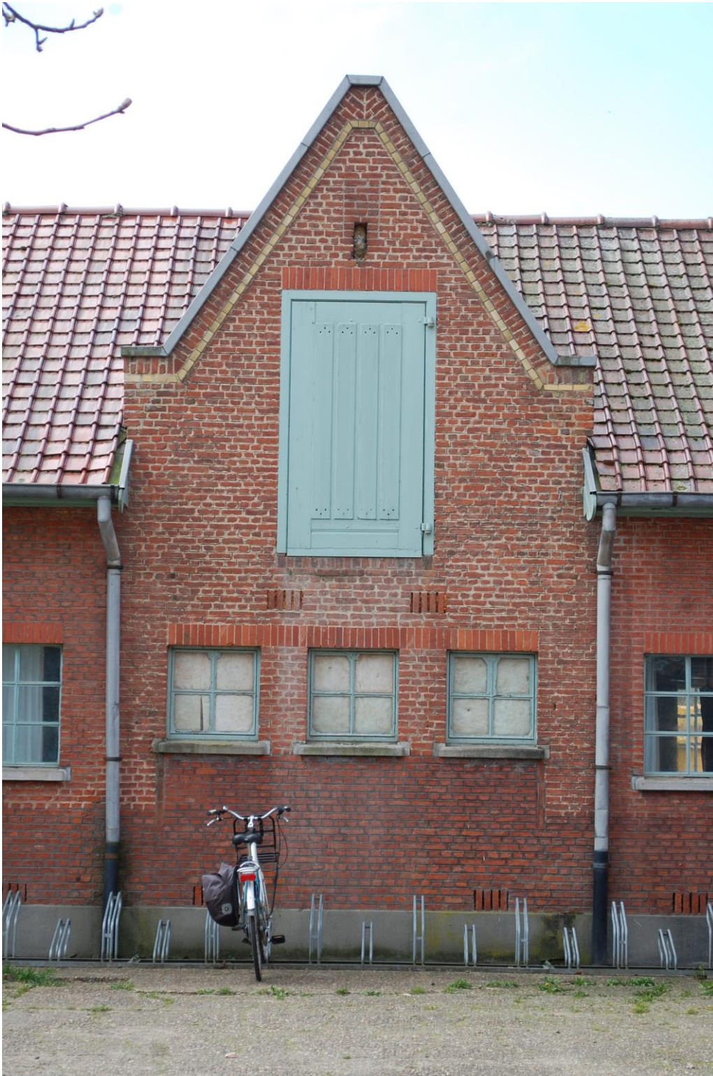
55 – Uitstekende puntgevel met van decoratief toegepaste in gele baksteen uitgevoerde fries, ijzeren raamkaders en originele beplankte toegangsdeur met spijkermotief in de linkervleugel van het hoofdgebouw van TRANSfarm te Lovenjoel. Foto KU Leuven, Technische Diensten.
