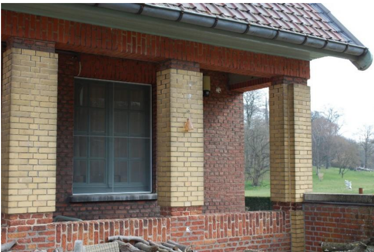
61 – De decoratief toegepaste gele bakstenen op de pijlers in de portierswoning van het hoofgebouw van TRANSfarm te Lovenjoel. Foto KU Leuven, Technische Diensten.
