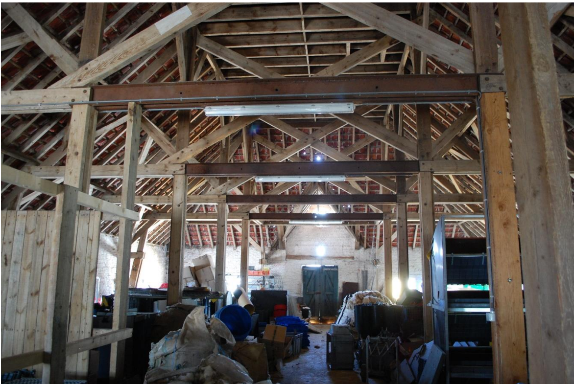
87 – Het dakgebinte van de zolder, lokaal 01.25, boven de koeienstal op de eerste verdieping van het hoofdgebouw van TRANSfarm te Lovenjoel. Foto KU Leuven, Technische Diensten.
