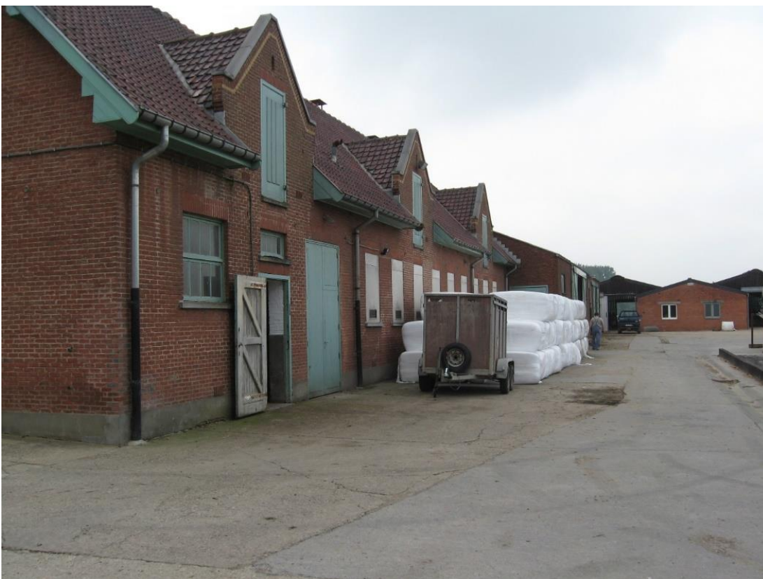
44 – Foto van de oudste (thans verdwenen) stalling, de zogenaamde varkensstal (noordgevel). Foto KU Leuven, Technische Diensten.
