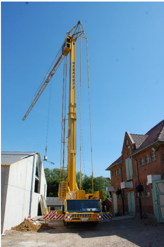
89 – De in opbouw zijnde hallen van TRANSfarm met rechts de achterzijde van het hoofdgebouw van TRANSfarm te Lovenjoel. Foto KU Leuven, Technische Diensten.
