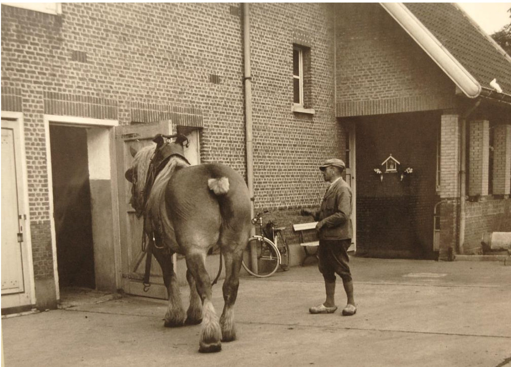
36 – Foto van het Zoötechnisch Centrum te Lovenjoel gemaakt vermoedelijk in de jaren '70. Op deze foto is op de achtergrond de portierswoning (met de bakstenen pijlers en met een grote plank afgewerkte dakrand) zichtbaar. De op de foto geopende staldeur is thans vervangen door een bredere poort. De gesloten deur op de voorgrond van de foto is herkenbaar als een originele deur vanwege het spijkermotief en toont een rechthoekige geschilderde sierband. Foto KU Leuven, Universiteitsarchief.
