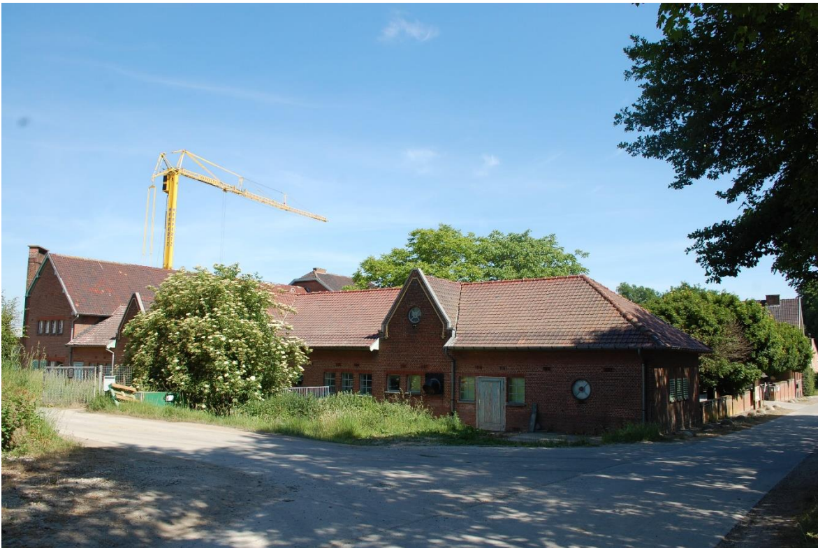
96 – Het hoofgebouw van TRANSfarm vanuit het zuiden (Foto KU Leuven, Technische Diensten)
