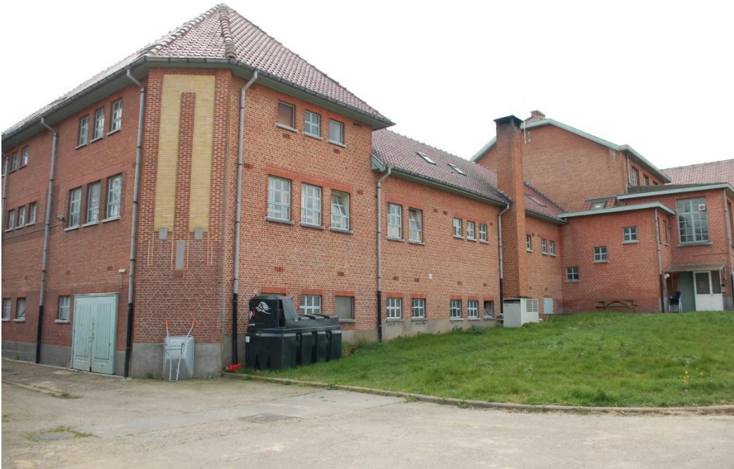
62 – Noordoostelijke hoek van het hoofdgebouw van TRANSfarm te Lovenjoel met rechthoekige ramen met roedeverdeling, beplankte toegangspoort en decoratief toegepaste gele bakstenen op de afgeknotte muurhoek. Foto KU Leuven, Technische Diensten.
