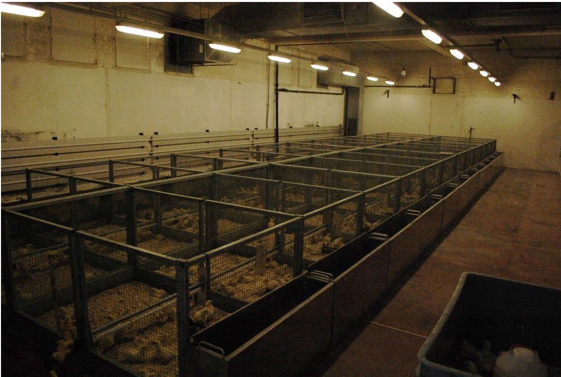
86 – Het hoofdgebouw van TRANSfarm oftewel de voormalige modelhoeve, lokaal 00.60. Foto Technische Diensten KU Leuven.
