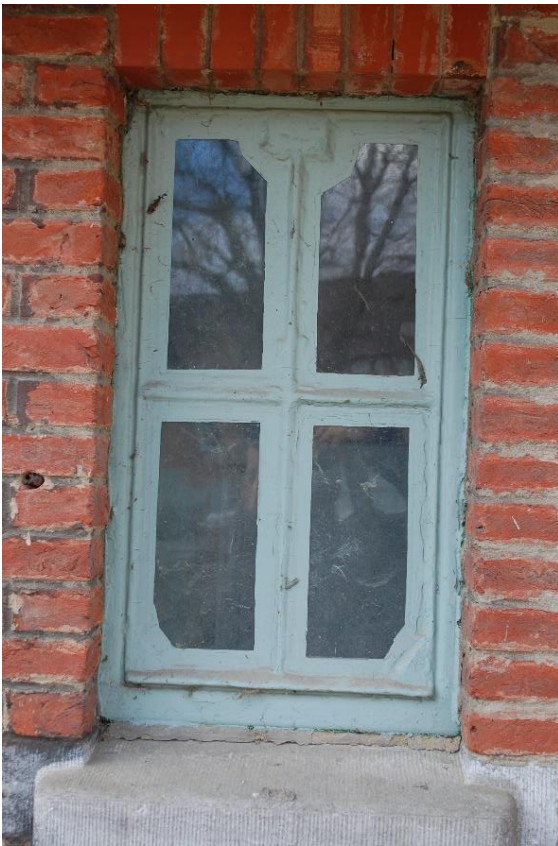
56 – Ijzeren raam (met vervaagd profiel vanwege de vele schilderlagen) in de linkervleugel van het hoofdgebouw van TRANSfarm te Lovenjoel. Foto KU Leuven, Technische Diensten.
