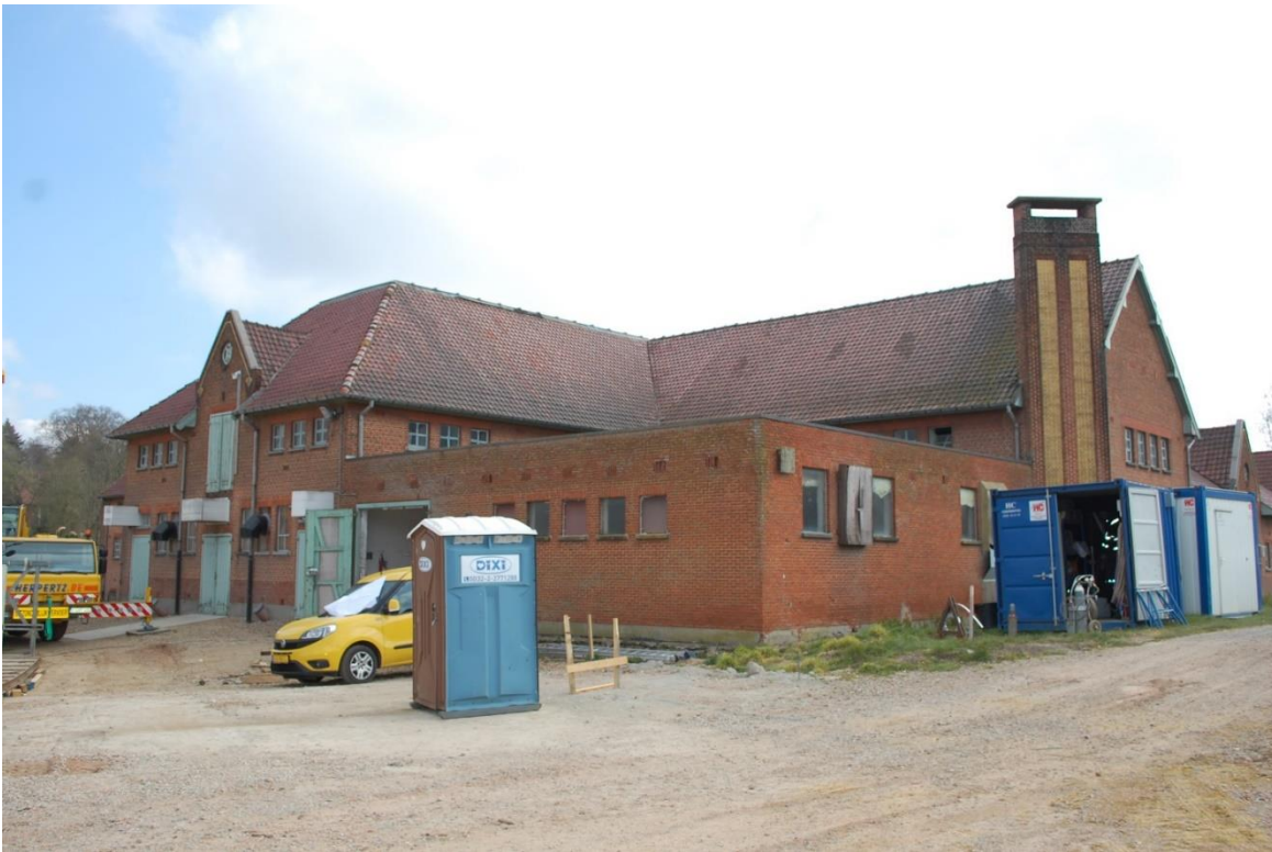
68 – Eenlaagse aanbouw in de zuidwestelijke hoek (vermoedelijk omstreeks 1977 kort na de overname door de universiteit). Foto KU Leuven, Technische Diensten.
