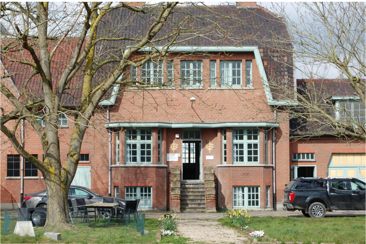
52 – Centraal volume van het hoofgebouw van TRANSfarm te Lovenjoel. Foto KU Leuven, Technische Diensten.
