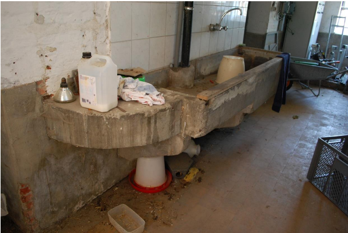
84 – Oorspronkelijke (?) waterbak bewaard in de zuidvleugel van het hoofgebouw van TRANSfarm te Lovenjoel. Op de voorgrond is de (vermoedelijk), originele muurbekleding zichtbaar bestaande uit een hoge cemenen plint en witgeschilde muren Foto KU Leuven, Technische Diensten.
