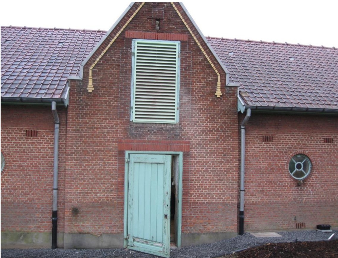
72 – Recent aangebrachte rooster ter vervanging van een deur in één van de puntgevels aan de zuidvleugel van het hoofgebouw van TRANSfarm te Lovenjoel. Foto KU Leuven, Technische Diensten.
