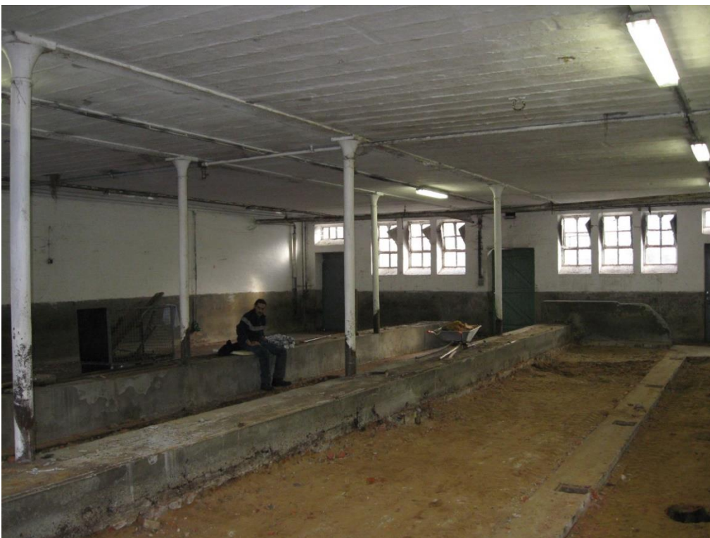
38 – Foto van de grote stal (oorspronkelijk bestemd voor 30 melkkoeien) naast het hoofdgebouw van het Zoötechnisch Centrum te Lovenjoel. Deze foto werd genomen in 2011 vlak voordat deze ruimte werd heringericht. Foto Technische Diensten KU Leuven.
