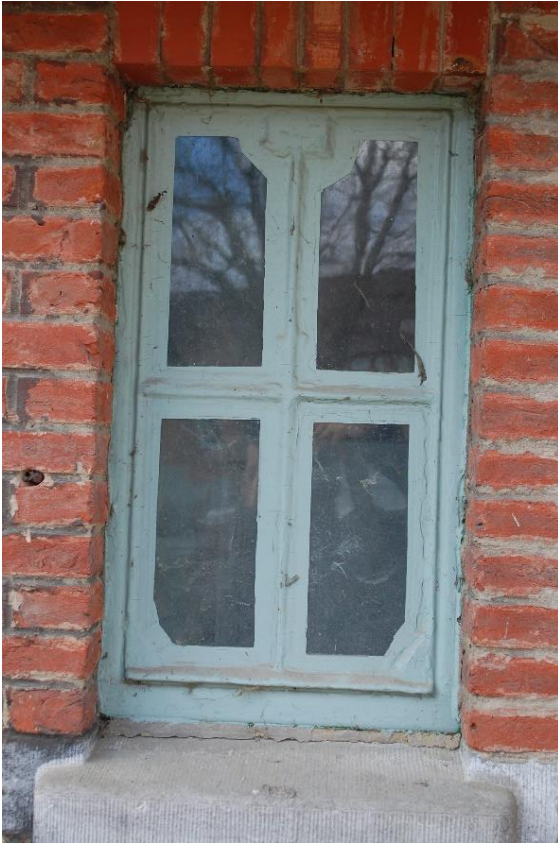
53 – Ijzeren raam (met vervaagd profiel vanwege de vele schilderlagen) in de linkervleugel van het hoofdgebouw van TRANSfarm te Lovenjoel. Foto KU Leuven, Technische Diensten.
