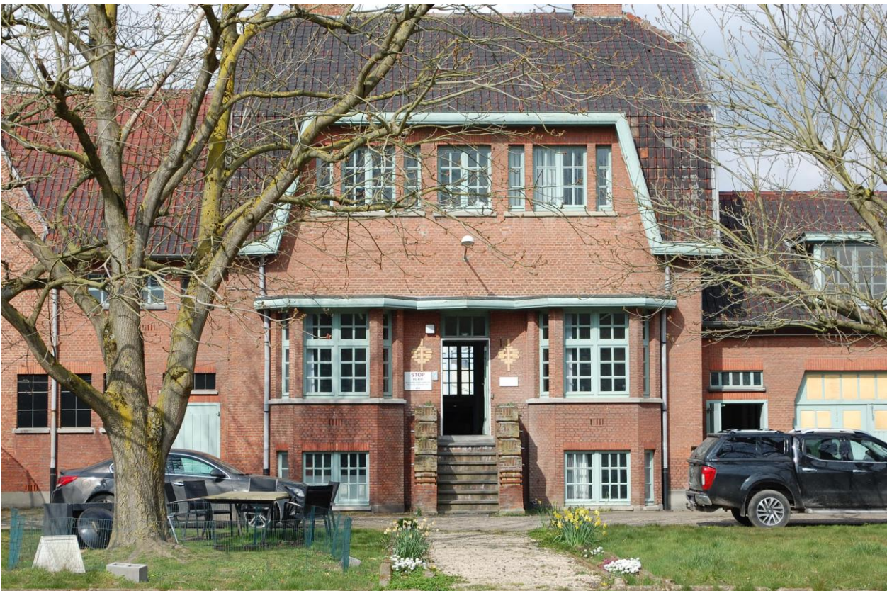
49 – Centraal volume van het hoofdgebouw van TRANSfarm te Lovenjoel. Foto KU Leuven, Technische Diensten.
