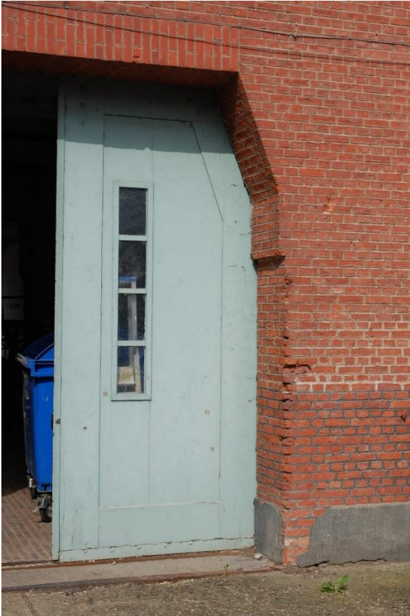
61 – Afgeschuinde bovenhoek van de toegang tot de stallen van het hoofdgebouw van TRANSfarm te Lovenjoel. De beplanke deur met rechthoekige ramen is niet origineel. Foto KU Leuven, Technische Diensten.
