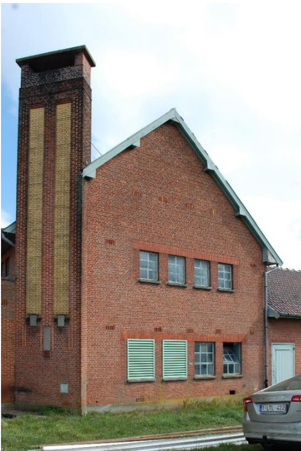
60 – Zuidoostelijke hoek van het hoofdgebouw van TRANSfarm te Lovenjoel met decoratief toegepaste gele bakstenen op de afgeknotte muurhoek/ schoorsteen. Foto KU Leuven, Technische Diensten.
