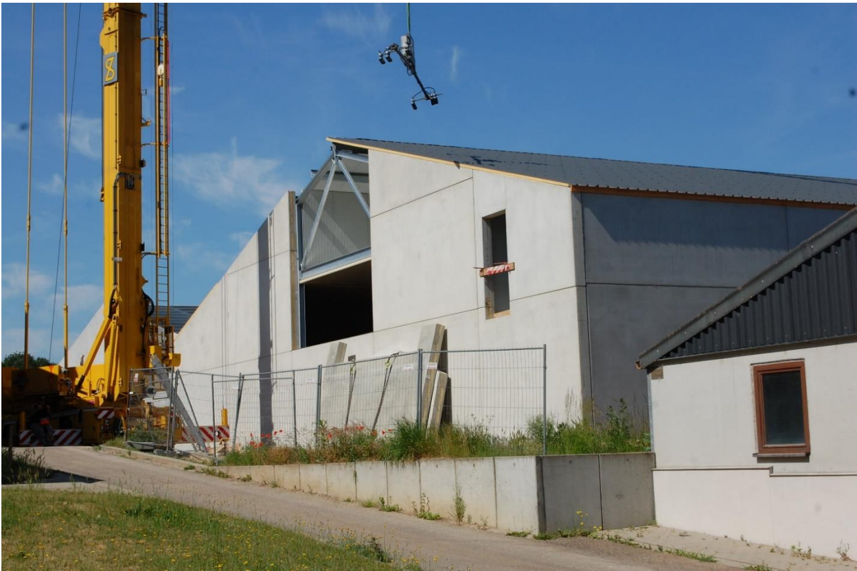
75 – De bouw van de nieuwe loodsen van TRANSfarm, 2019-2020. Foto Technische Diensten KU Leuven.
