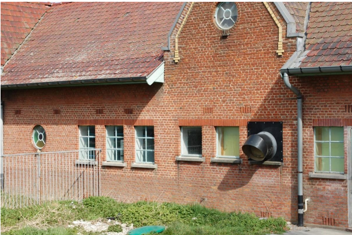
70 – Recent toegevoegde verluchttingsmond aan de zuidvleugel van het hoofdgebouw van TRANSfarm te Lovenjoel. Foto KU Leuven, Technische Diensten.
