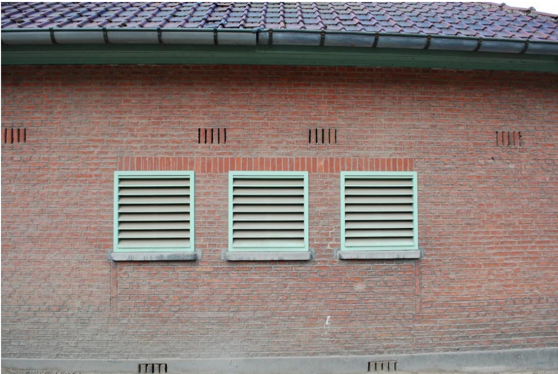
71 – Recent aangebrachte roosters aan de zuidvleugel van het hoofgebouw van TRANSfarm te Lovenjoel. Foto KU Leuven, Technische Diensten.
