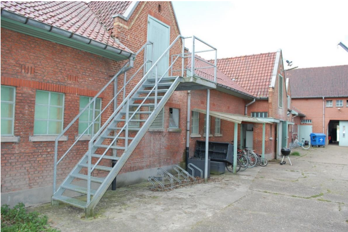
69 – Recent toegevoegde metalen trap en afdak op het binnenplein aan de zuidvleugel van het hoofdgebouw van TRANSfarm te Lovenjoel. Foto KU Leuven, Technische Diensten.
