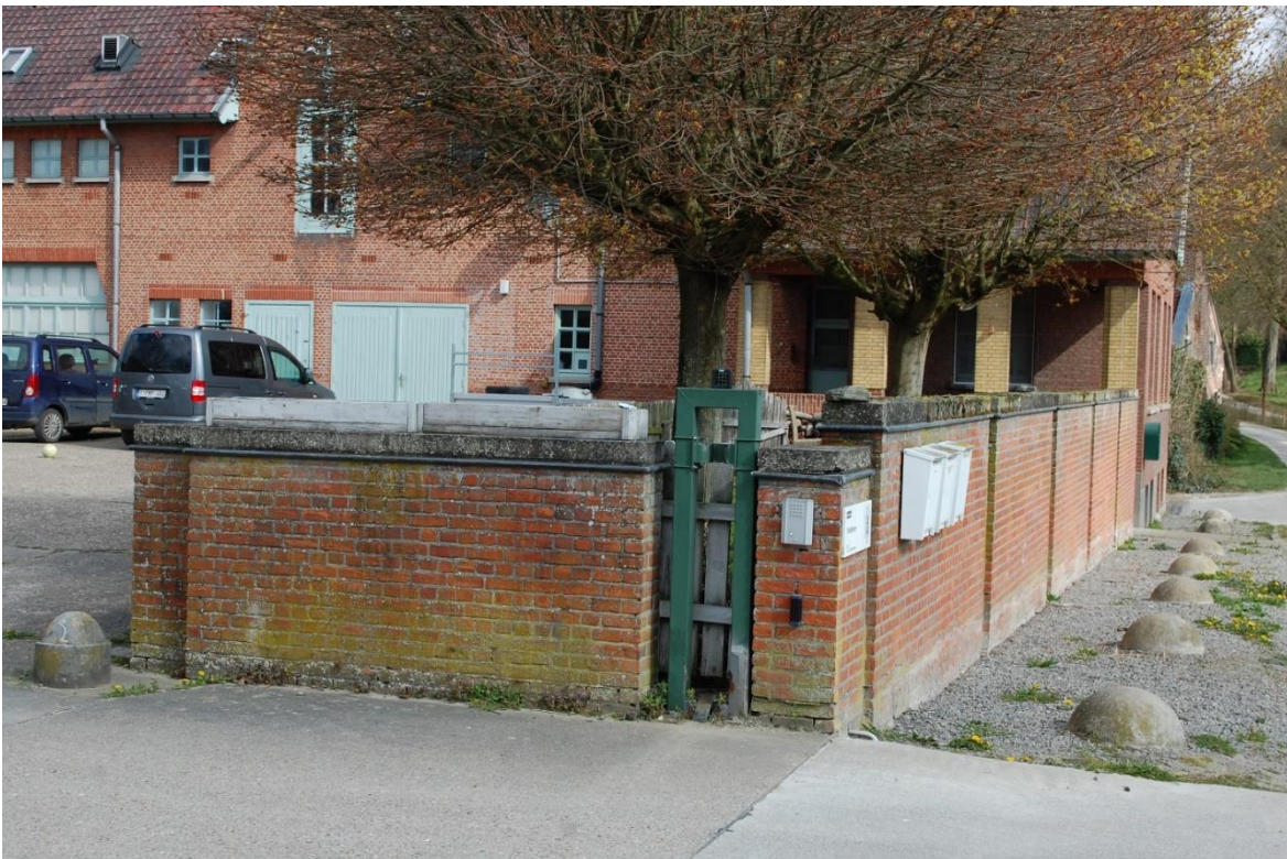
66 – Volledig vernieuwde afscheidingsmuur met rolhek aan de straatkant. Foto KU Leuven, Technische Diensten.
