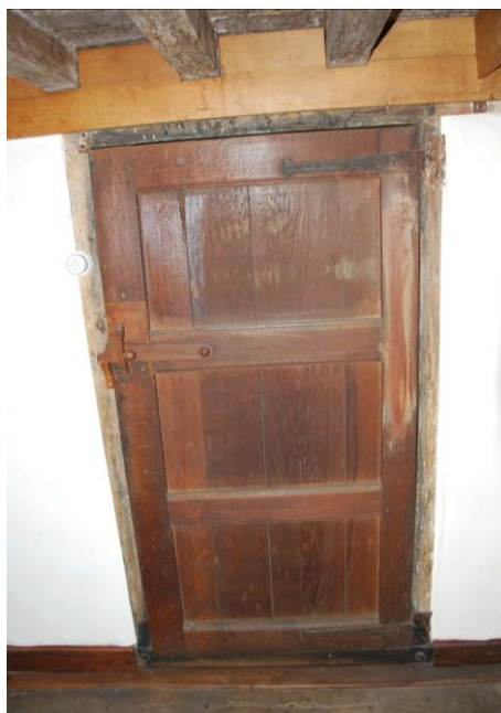
Interieur | Nivo 1,5 | Ruimte 1.9 | Deur naar gang.
