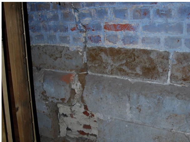
Interieur | Ruimte 0.12 | Plint uit ijzerzandsteen (bovenste deel).
