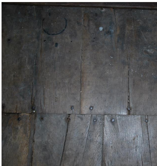
Interieur | Nivo 1,5 | Ruimte 1.9 | Houten plankenvloer.
