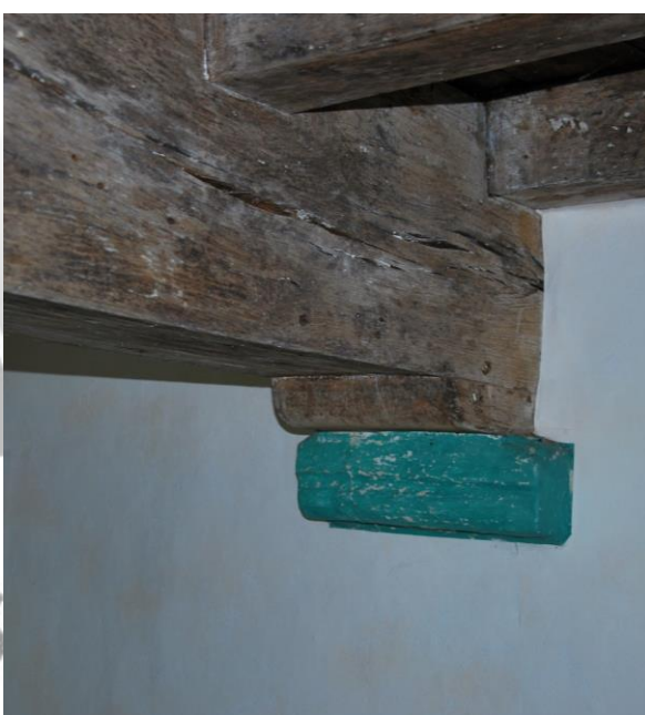
Interieur | Nivo 1,5 | Ruimte 1.9 | Moerbalk met sleutelstuk.
