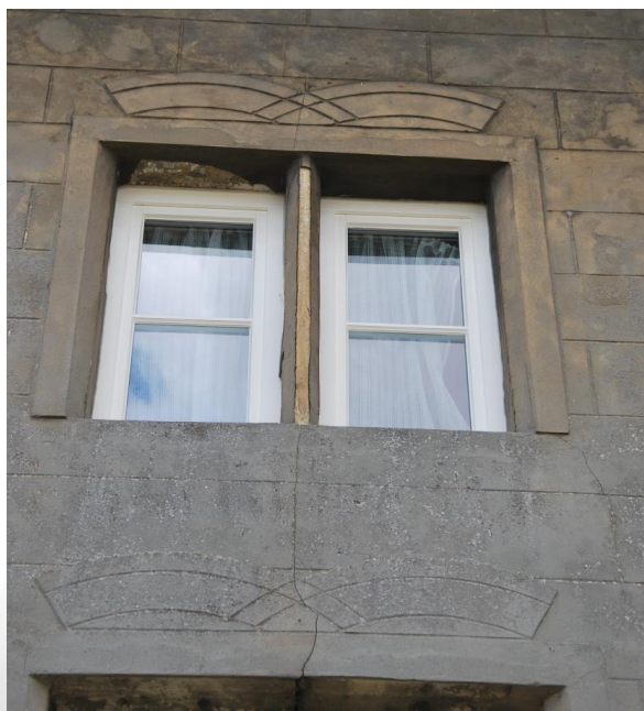
Achtergevel | Bolkozijn met natuurstenen middenstijl.
