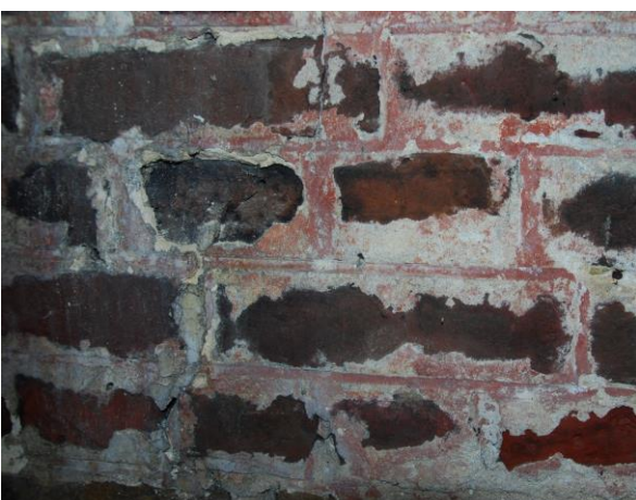
Interieur | Ruimte 0.14 | Restanten van kleur laag | Dagstreep en knipvoeg.
