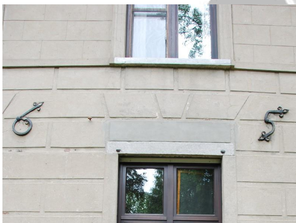
Voorgevel | Muurankers anno 1655.
