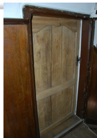
Interieur I Nivo 0,5 | Deur naar opkamer 0.5.
