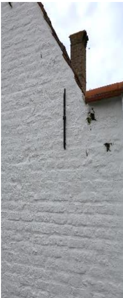
Figuur 38 Detail muuranker (11.02.2020)
