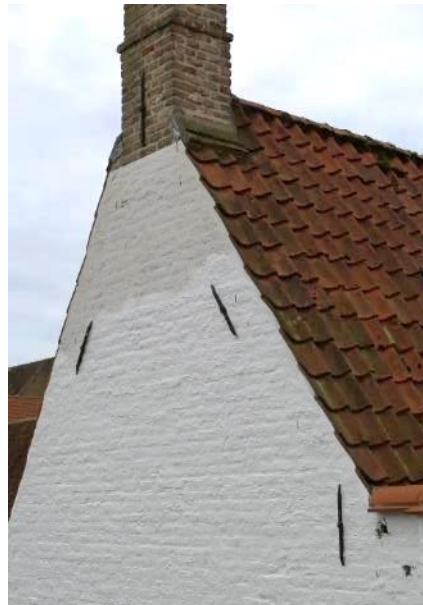
Figuur 39 Muurankers in de topgevel, zijde Koning Albert I-laan (11.02.2020)
