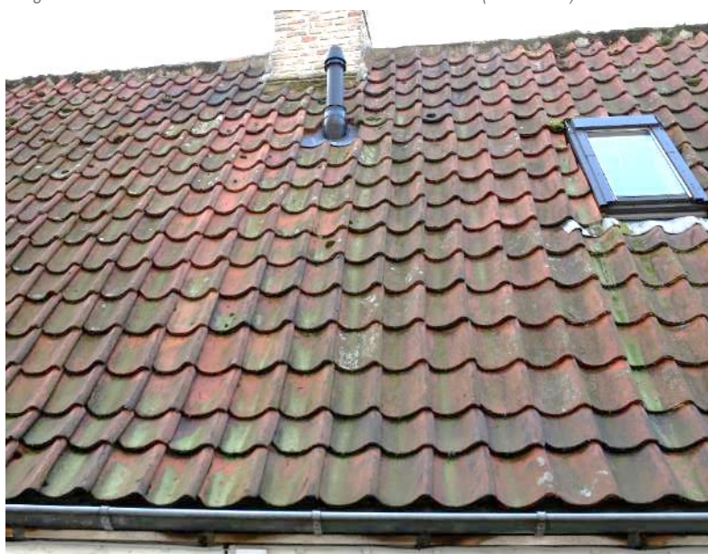
Figuur 25 Vervuiling/patina op het dakvlak aan de binnentuin (11.02.2020)
