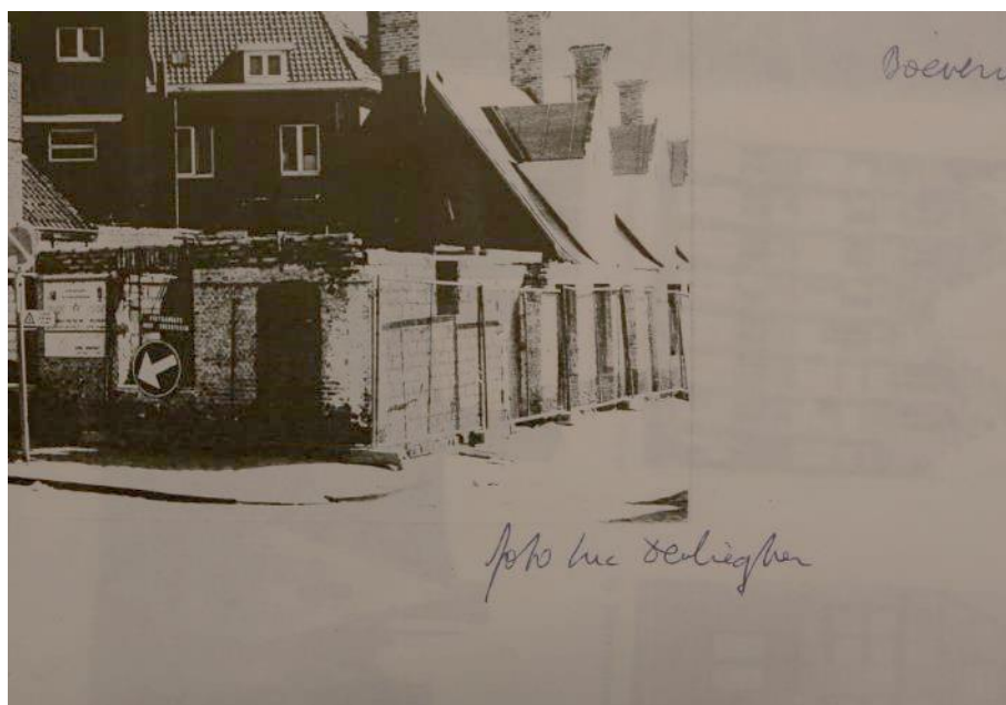
Figuur 11 Werken aan het godshuis in 1989, foto Luc Devliegher (bron: OCMW-archief Brugge, geraadpleegd op 12.02.2020)
