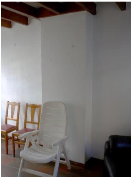
Figuur 47 Gepleisterd en geschilderd schouwkanaal (11.02.2020)
