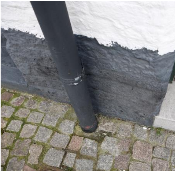
Figuur 19 Craqueleren verf plint (11.02.2020)
