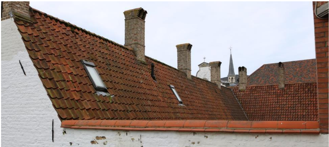
Figuur 23 Dakvlakken binnentuin (11.02.2020)
