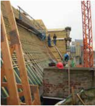
Heropbouw van het dak met een nieuwe constructie.
