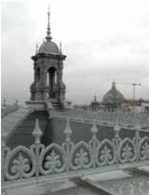
De nieuwe zinken ornamenten op het dak.
