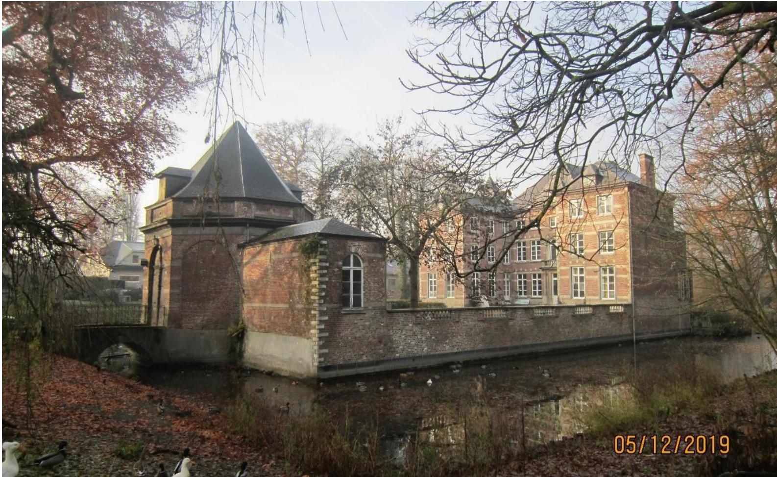
Foto 2: Algemeen zicht op voorgevel met binnenkoer met poortgebouw en slotgracht
