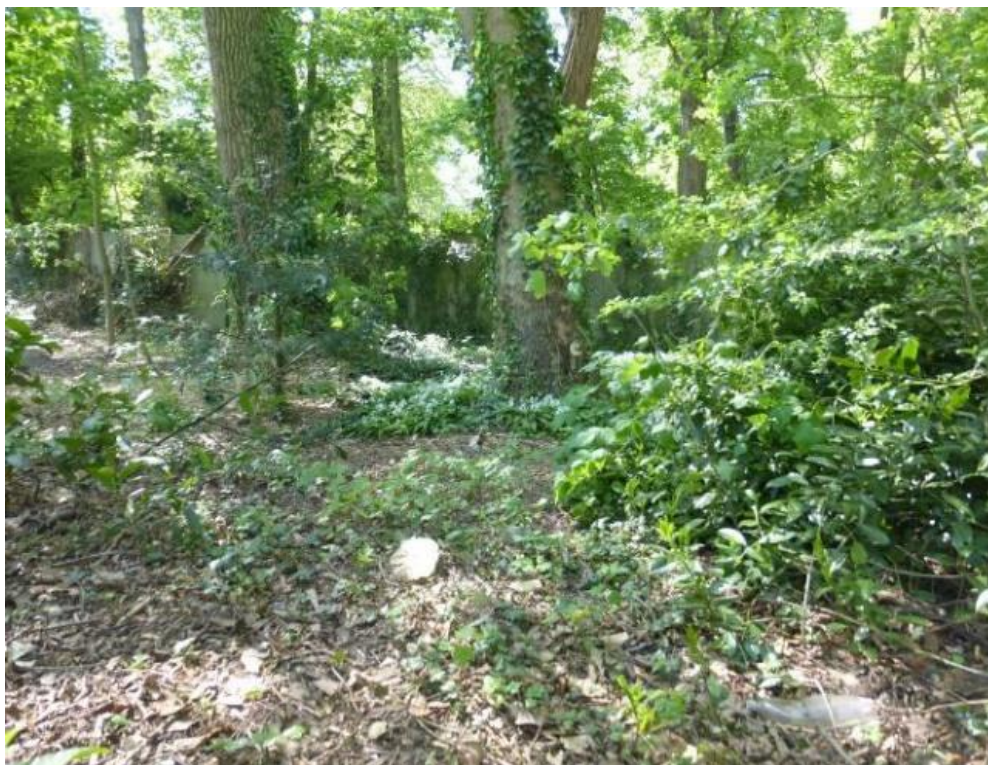
1. Zicht op de betonmuur vanuit zijde appartementsgebouw
