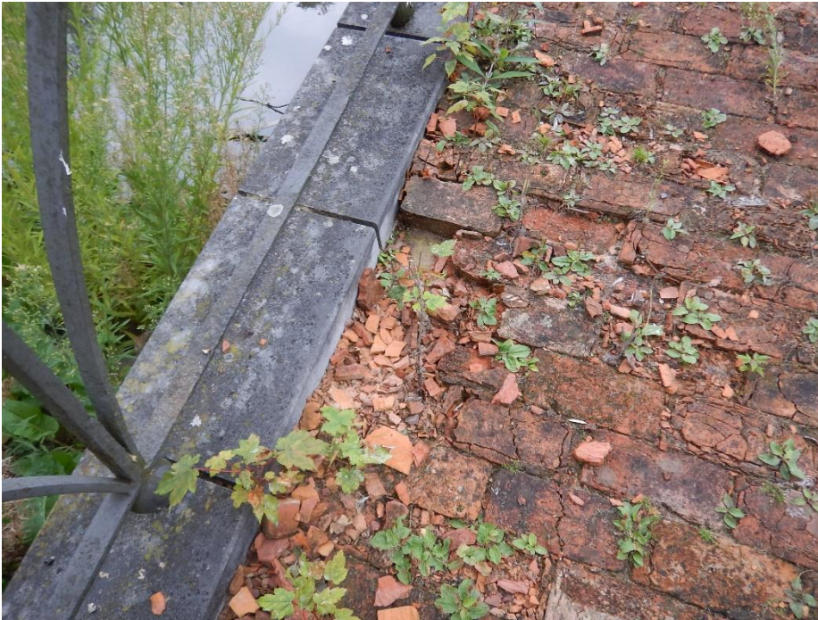
Kleiklinkers op brug naar park
