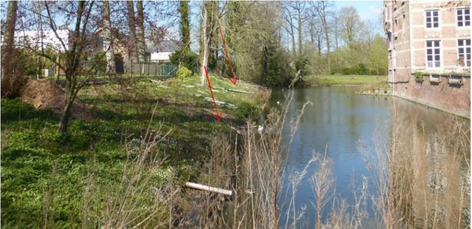
Afvoerbuizen van de woningen naar de gracht.
