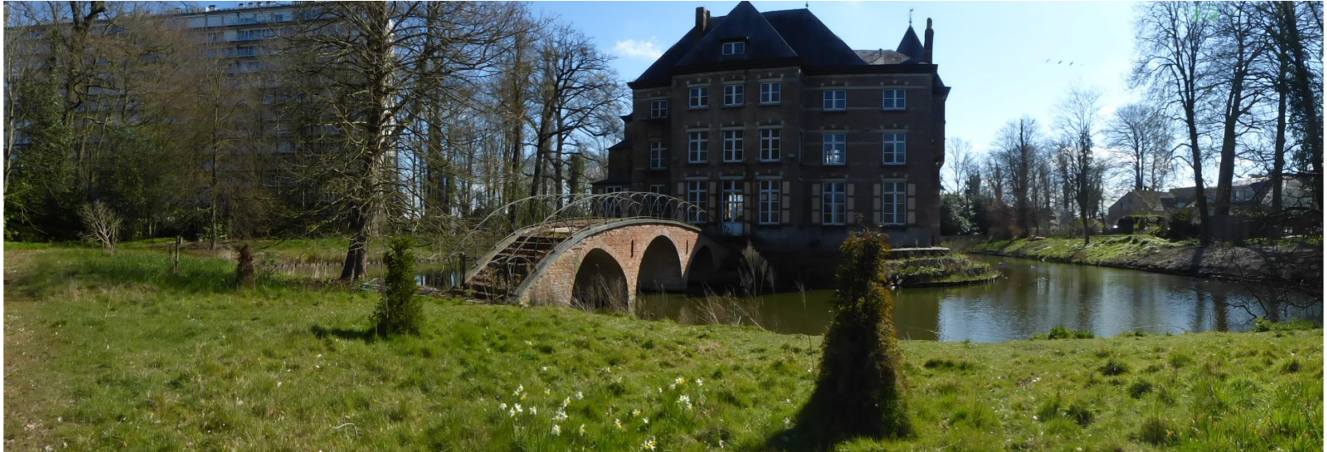
Foto 3: Algemeen zicht op achtergevel en slotgracht met brug
