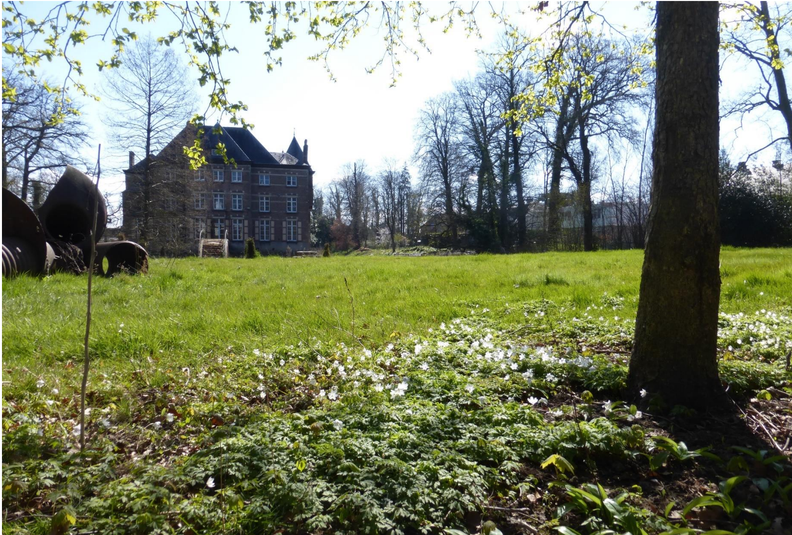
Foto 13: Zicht op achtergevel met brug vanaf achterste gracht over grasvlakte
