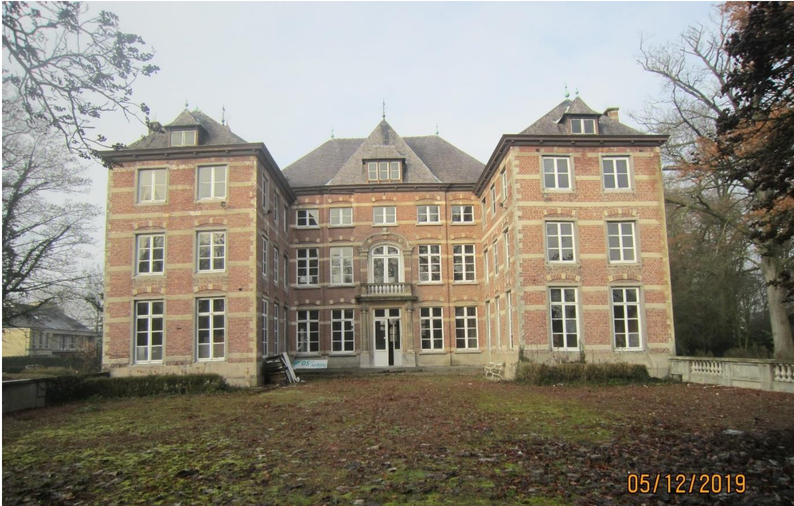
Foto 1: Algemeen zicht op voorgevel met binnenkoer
