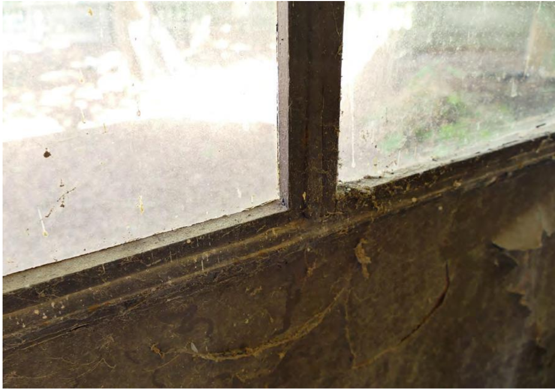
Houten latjes als "anslag" langs de interieurzijde
