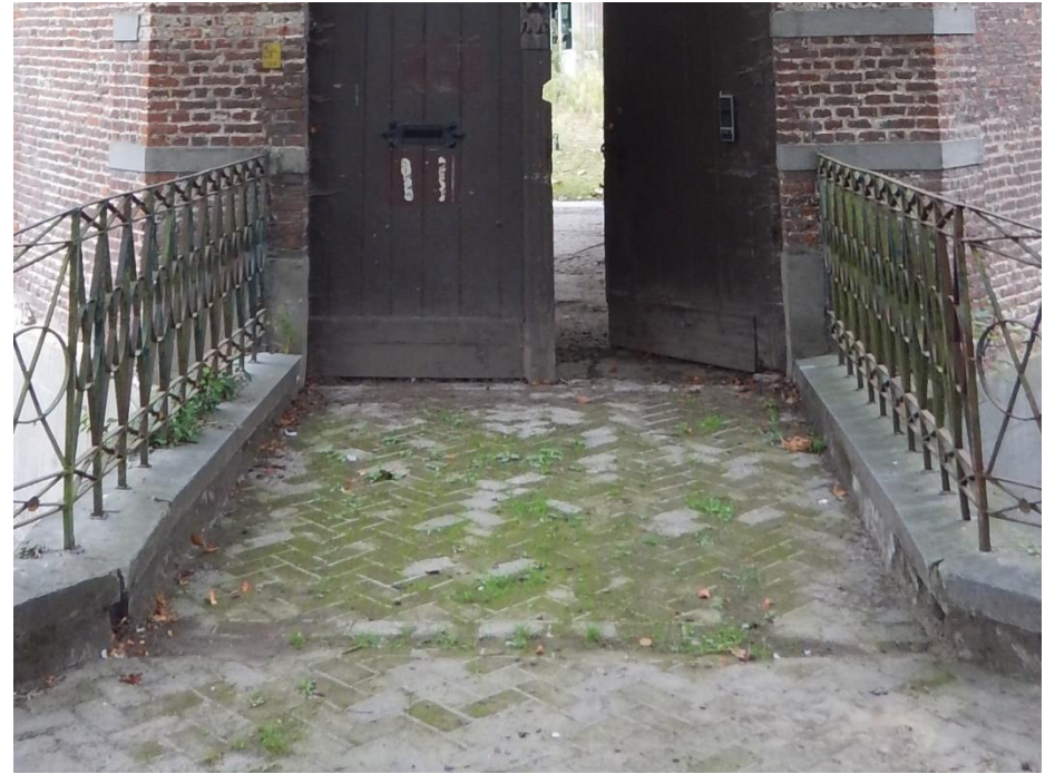
Kleiklinkers op brug naar poortgebouw
