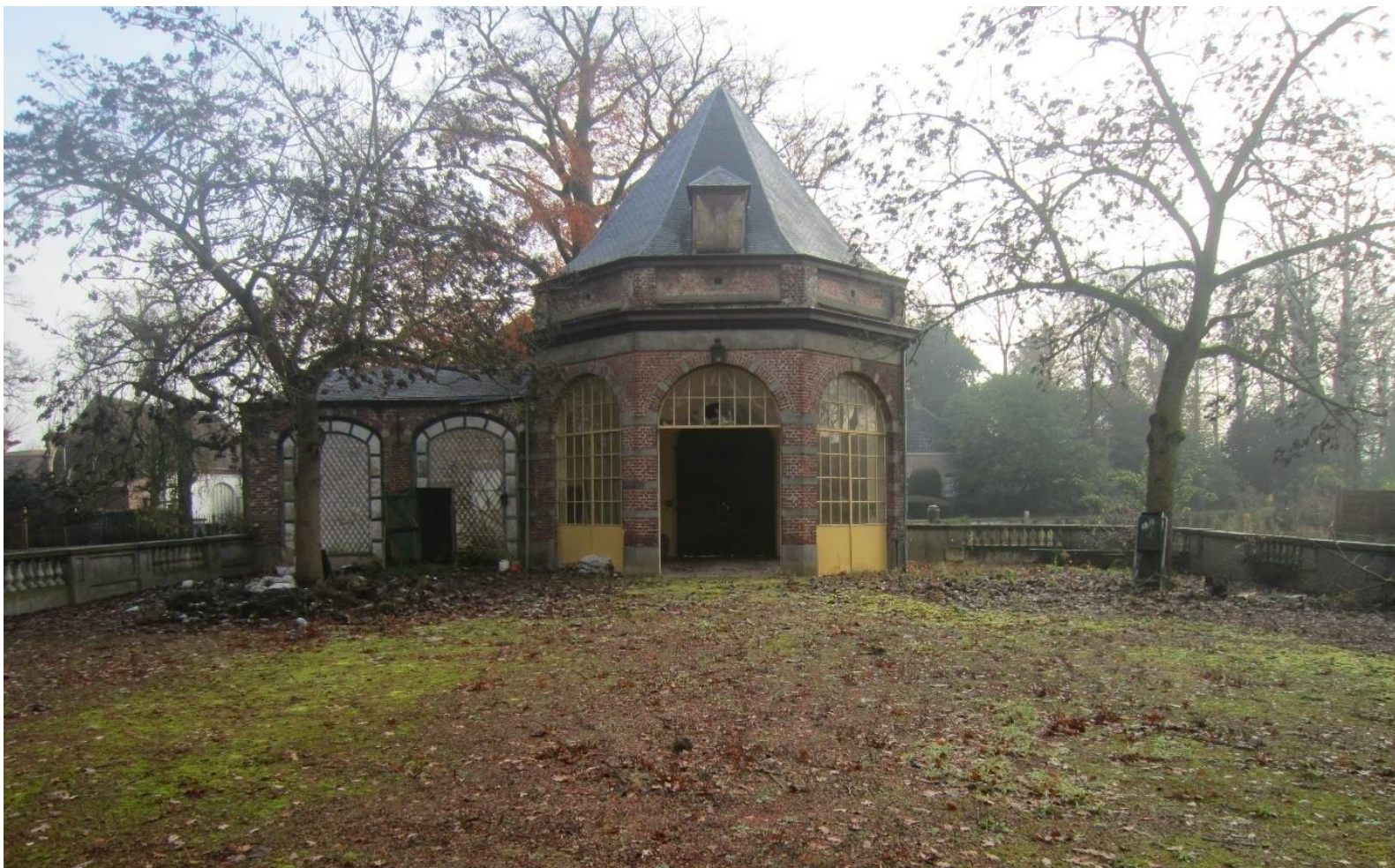
Foto 4: Poortgebouw met slotgracht
