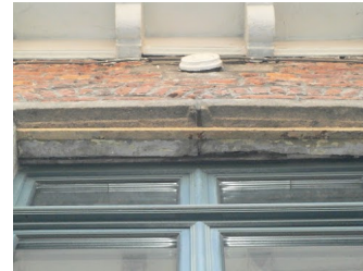
kalkzandsteen-lateien zijn aangepast
