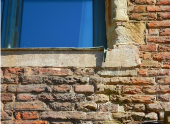
baksteen-ververing en verdieping voegwerk
