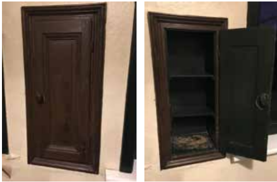
De eetplaats en keuken zijn voorzien van muurkastjes. Het front heeft een sierlijst en is voorzien van een slot.
