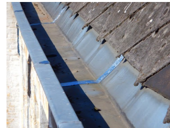
bakgoot-herstellingen door ons aangebracht
