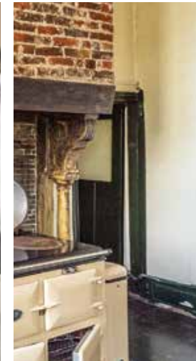
Onderaan de keukenmuur aan de Noordgevel bevond zich een sierplint in hout. Deze is grotendeels beschadigd en verrot. 2 originele panelen zijn bewaard als referentie voor reconstructie.
