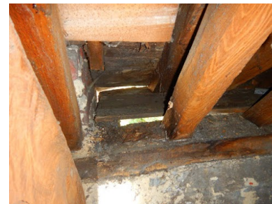
dakvoet koerzijde-inrotting
