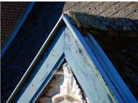
topgevel-windveer en aansluiting in zink
