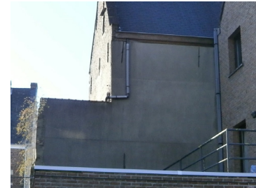
noordwestgevel-berging en achterbouw (gecementeerd)
