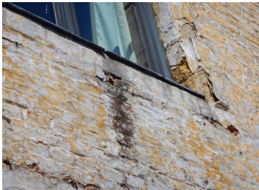
achterbouw-vochtbelasting muurwerk via dorpels
