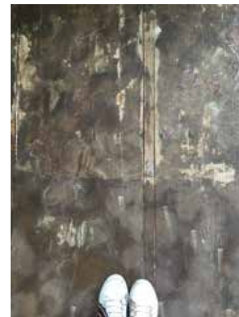
Vloer in slaapkamer 1 bijna volledig bedekt met lijmresten.
