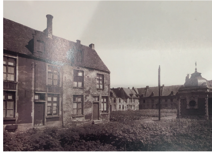
Huizen in het pleinbegijnhof van Aalst, in 1945 ten prooi gevallen aan dverkrotting bron : " Vlaamse Begijnhoven, werelderfgoed" Suzanne van Aerschot & Michiel Heiremans Davidsfonds / Leuven
