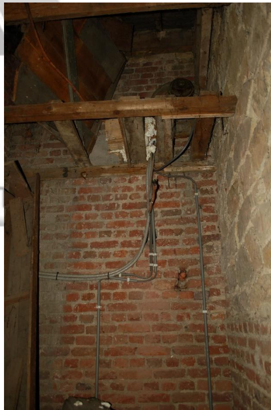
Situering: Veldwezelt I Sint Lambertuskerk. Beschrijving: Foto 142 | Orgel | Locatie motor windvoorziening. Bron: Architectenburo Erik Martens & Partners bvba I 2020.
