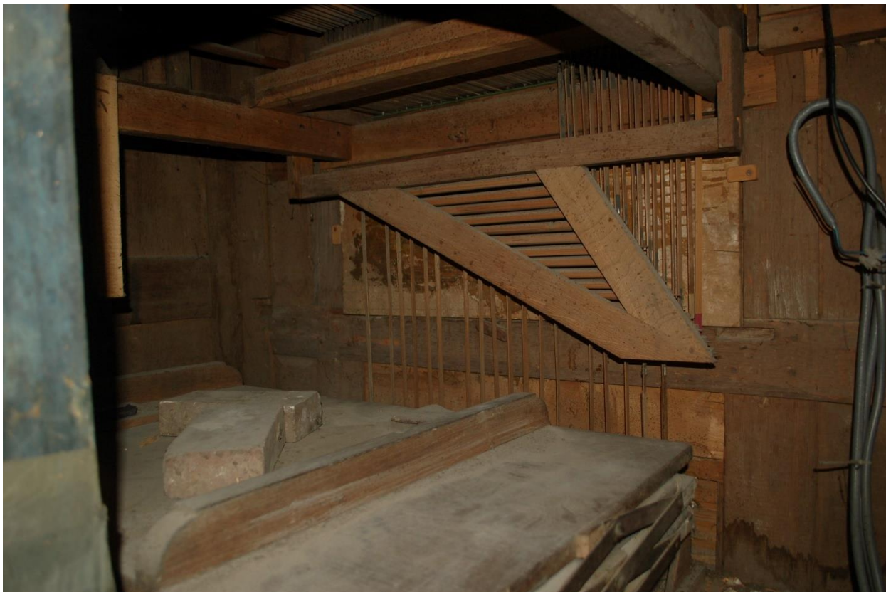
Situering: Veldwezelt | Sint Lambertuskerk. Beschrijving: Foto 148 | Orgel | Het pedaalwellenbord tegen de binnenzijde van de voorkant van het basement. Bron: Architectenburo Erik Martens & Partners bvba | 2020.
