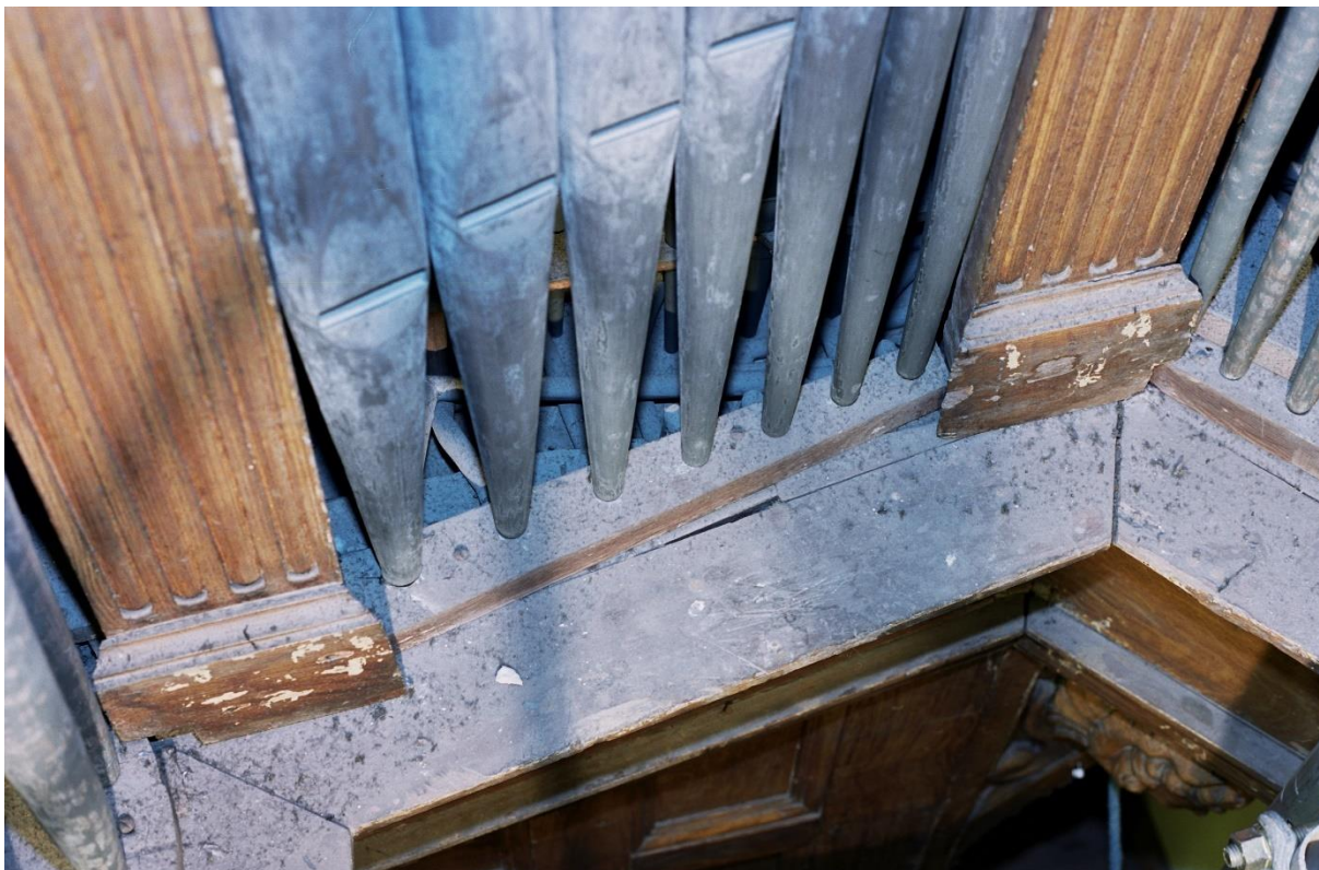
Situering: Veldwezelt | Sint Lambertuskerk. Beschrijving: Foto 77 | Orgel | Frontpijpen van Joseph Binignat (1806) in het linker tussenveld. Niet-originele frontstok. Bron: Orgeldeskundige Dick Zweers | 2008.
