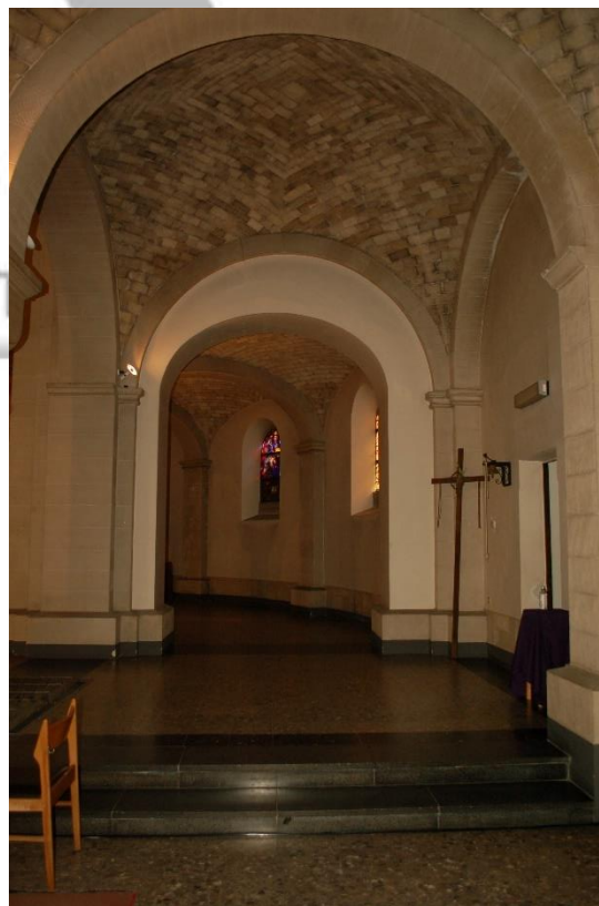
Situering: Veldwezelt | Sint Lambertuskerk. Beschrijving: Foto 46 | Algemene zichten | Interieur (pandgang achter koor). Bron: Architectenburo Erik Martens & Partners bvba | 2020.
