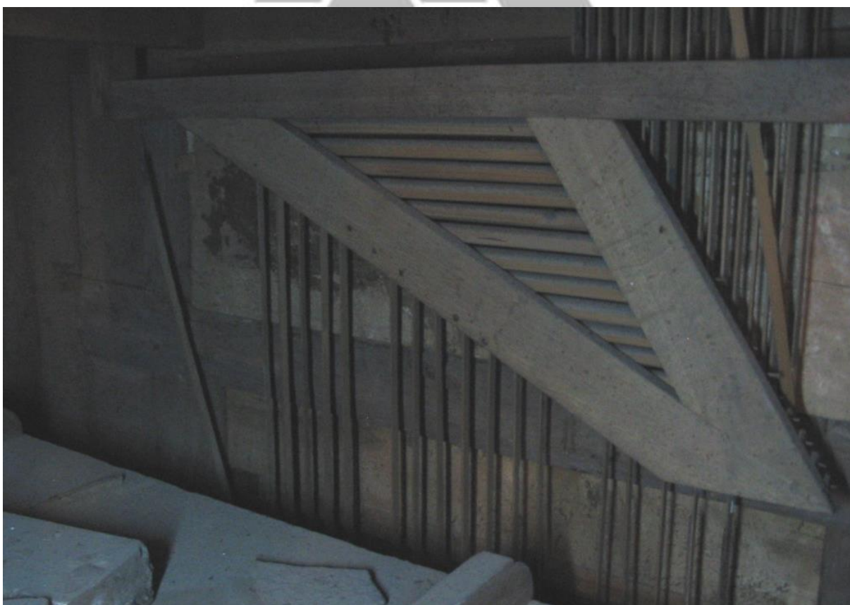
Situering: Veldwezelt I Sint Lambertuskerk. Beschrijving: Foto 147 | Orgel | Het pedaalwellenbord tegen de binnenzijde van de voorkant van het basement. Bron: Orgeldeskundige Dick Zweers | 2008.
