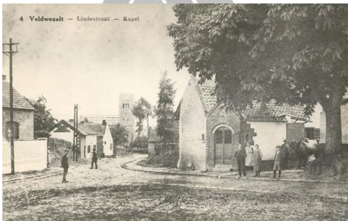
Afbeelding 6 | Bouw van de nieuwe kerk gezien vanaf het lindeplein 8 .
