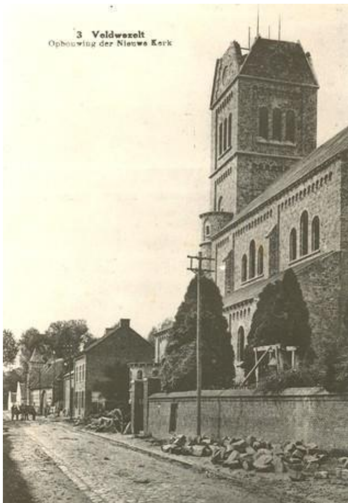
Afbeelding 7 | Bouw van de nieuwe kerk 9 .
