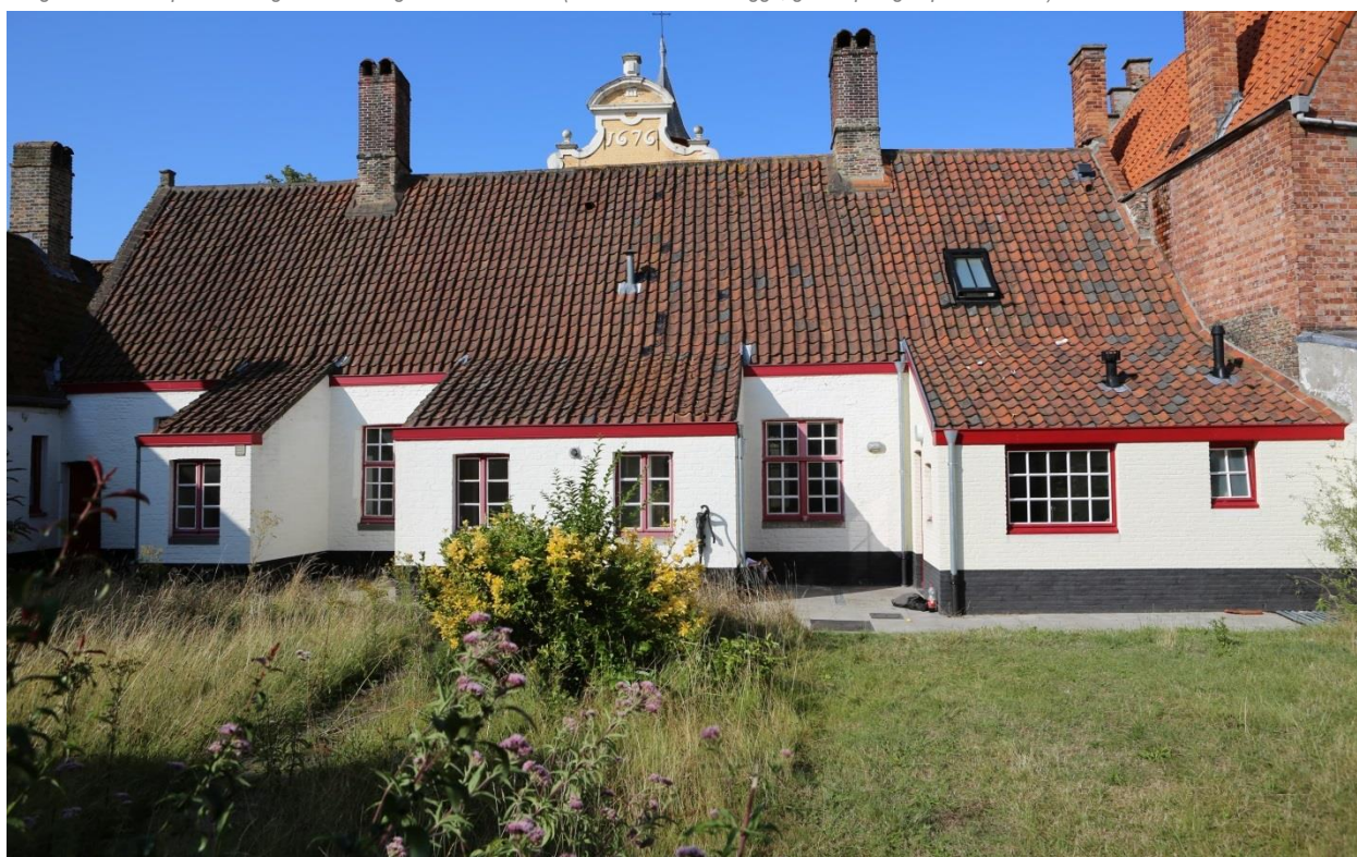
Figuur 52 Zicht op de achtergevel van het godshuis dd. 2019 (08.08.2019)
