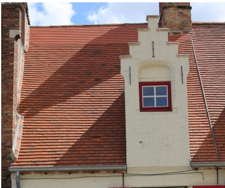
Figuur 18 Straatzijde tegelpannen woning nr. 79, als referentiebeeld voor de globale toestand van het godshuis zoals deze zal bestaan na de werken in 2020 (03.07.2019)
