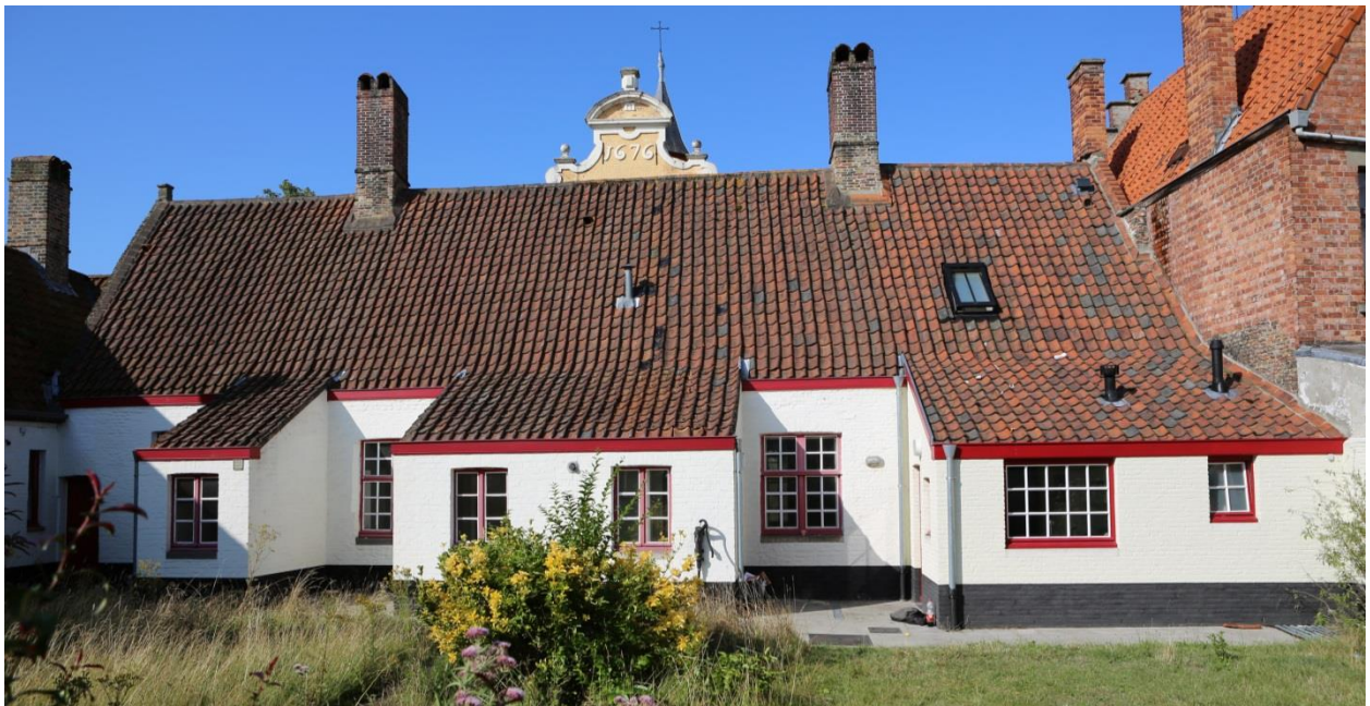
Figuur 15 Achtergevel voor de werken in 2020 (13.08.2019)
