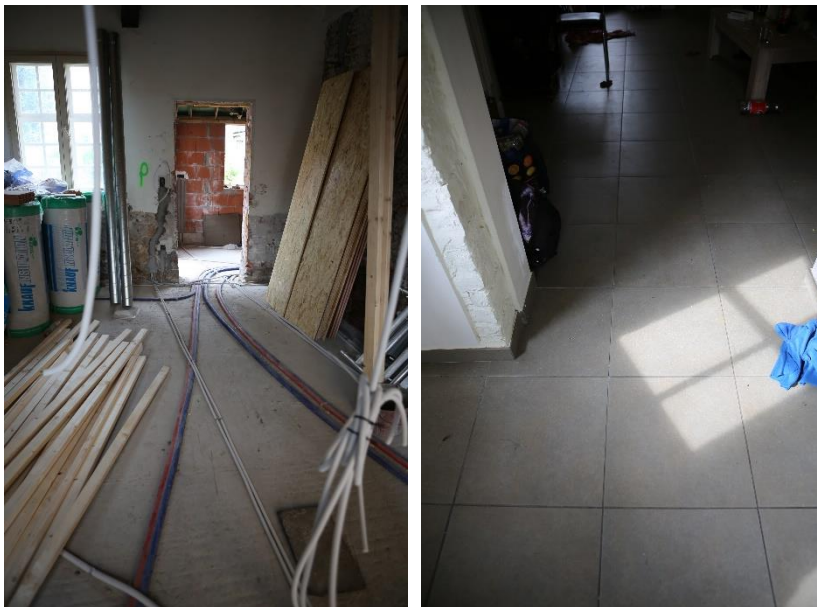
Figuur 43 Vloerpakket in opbouw in woning nr. 81 (08.08.2019) & Figuur 44 Recente vloeropbouw in woning nr. 79 (08.08.2019)
