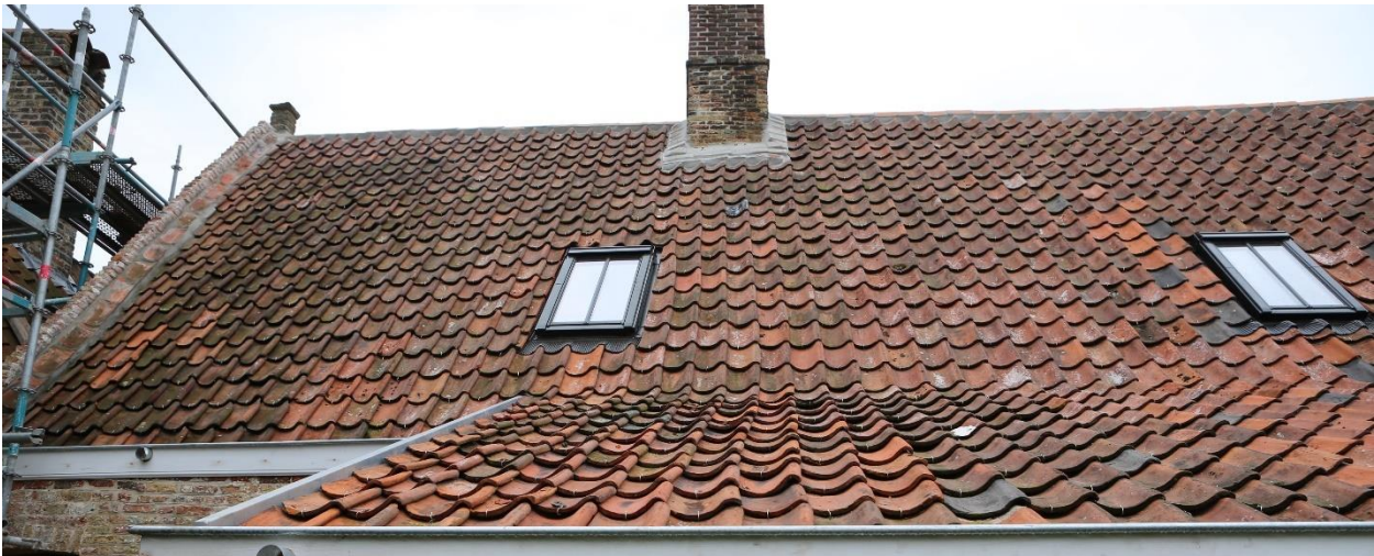
Figuur 19 Tuinzijde in recuperatie rode Vlaamse golfdakpannen (03.09.2020)
