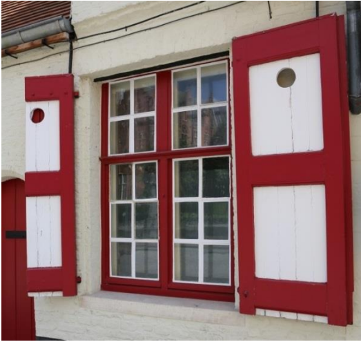
Figuur 25 Houten schrijnwerk voorgevel (03.07.2019) & Figuur 26 Houten schrijnwerk kapellen voorgevel voor de renovatie in 2020 (03.07.2019)
