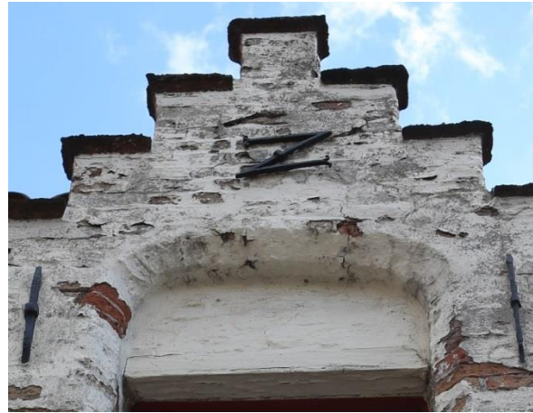
Figuur 32 Muurankers linker kapel straatgevel (03.07.2019) & Figuur 33 Muurankers op de rechter kapel straatgevel (03.07.2019)
