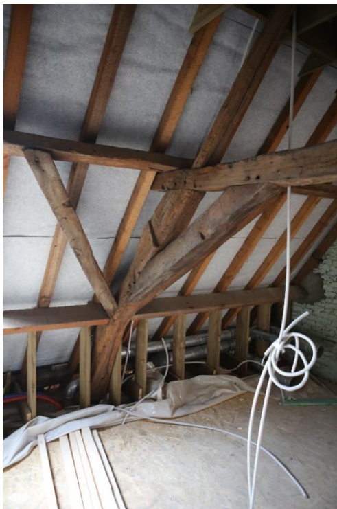
Figuur 36 Huidige toestand dakspant woning nr. 83 (03.09.2020)
