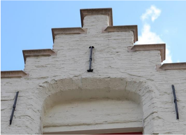
Figuur 32 Muurankers linker kapel straatgevel (03.07.2019) & Figuur 33 Muurankers op de rechter kapel straatgevel (03.07.2019)
