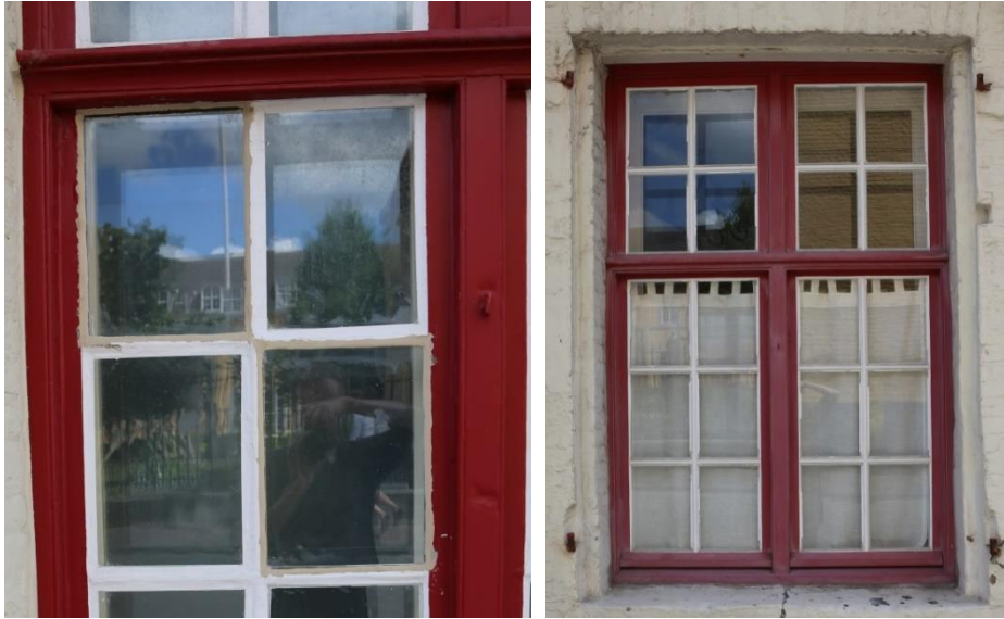
Figuur 29 Herstelling raam woning 79 (03.07.2019) & Figuur 30 Toestand raam straatzijde woning nr. 81 voor de werken in 2020 (03.07.2019)
