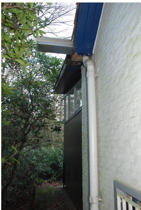
Afb. 97: betimmering van aanbouw uit 1962 en zicht- metselwerk van zijvleugel noordoostzijde.
