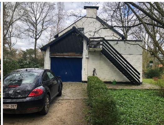
Afb. 72: zicht vanaf de oprit richting garage in zijvleugel
