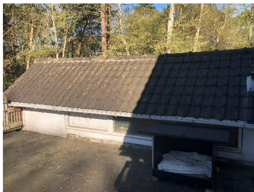
Afb.116: zicht op zadeldak boven de vliering en garage, met luik en horizontaal geplaatst venster
