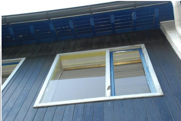
Afb. 110: detail blokraam met lichtblauwe afwerking kozijn gevel
