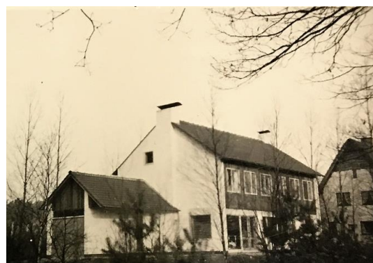
Afb.22: foto achterzijde woning kort na de bouw. Rechts op de foto is het buurhuis in regionalistische stijl te zien. Bron: Archief Familie De Roover-Van Coillie
