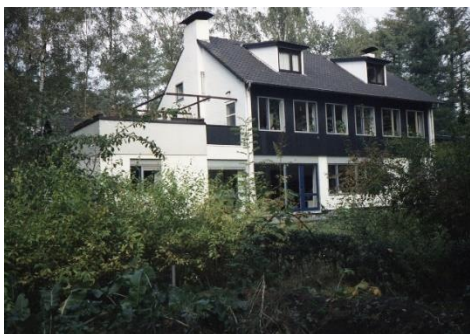
Afb. 48: foto omstreeks 1991 na de realisatie van de aanbouw. Bron: Archief Familie De Roover-Van Coillie
