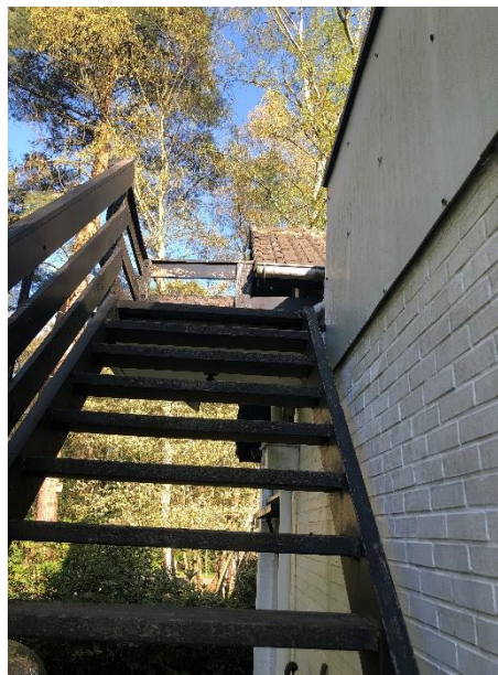
Afb. 114: trap naar het terras boven de aanbouw
