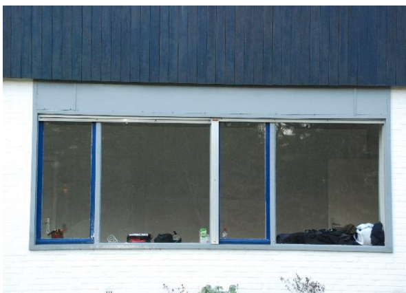
Afb. 107: twee identieke blokramen ter hoogte van de woonkamer Op de centrale vensterstijl is een aluminiumplaat bevestigd voor de geleiding van het pvc-rolluik.
