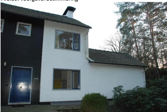
Afb. 91: betimmering en zichtmetselwerk hoofdvolume en flankerende zijvleugel
