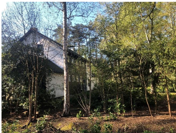
Afb. 95: zicht vanaf buurperceel richting voorgevel hoofdvolume en flankerende zijvleugel noordoostzijde
