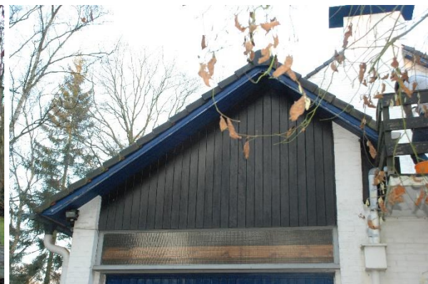
Afb. 104: betimmering en gewapend glasraam onder zadeldak
