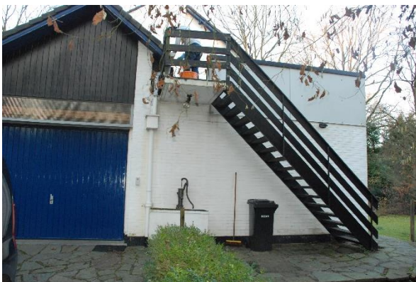
Afb.103: zuidwestelijke gevel met links de garage en rechts de aanbouw van 1978. Op de grens tussen beide zie je de slordig uitgevoerde afvoerbuis in pvc.
