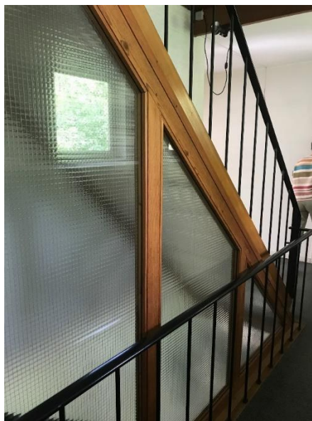
Afb. 49: foto trapkast om het gelijkvloers van de eerste verdieping te scheiden. 2017
