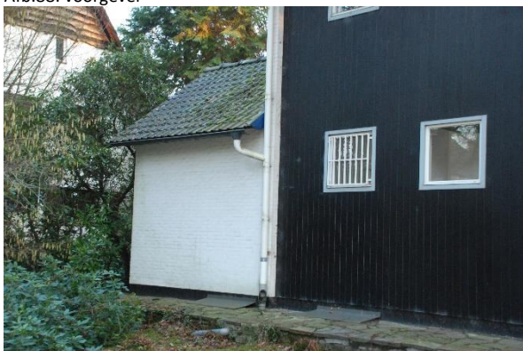
Afb. 90: betimmering voorgevel en flankerende zijvleugel aan noordoostelijke zijde
