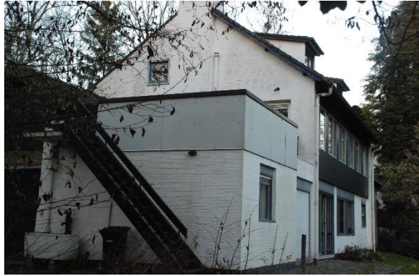
Afb. 112: storende aanbouw uit 1978 en achterliggend hoofdvolume
