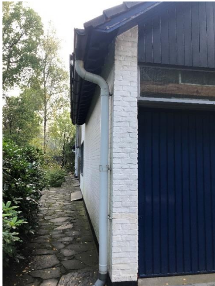
Afb. 102: storende pvc-afvoerbuis
