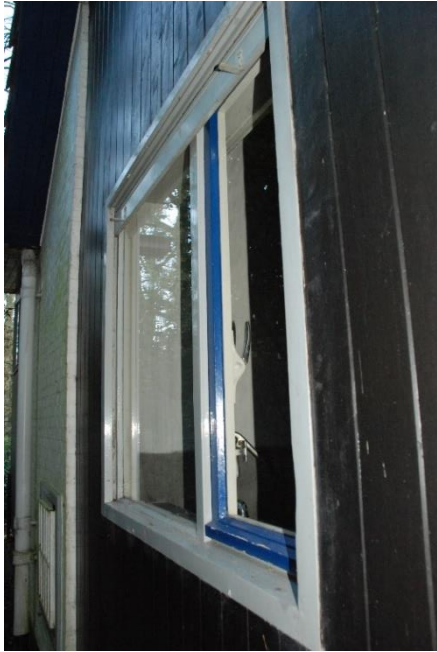
Afb.99: zelfde locatie met zicht op blokraam
