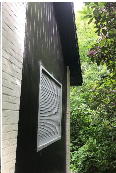
Afb.98: betimmering van zijvleugel noordoostzijde met gesloten houten rolluik ter hoogte van wasplaats
