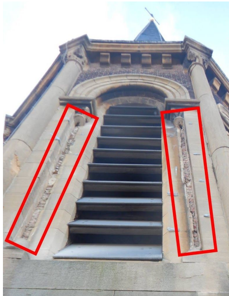
toren [1]-noord weggenomen kolommen
