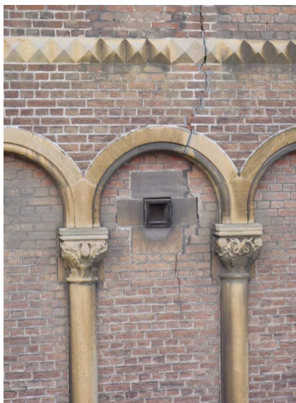
scheurvorming
