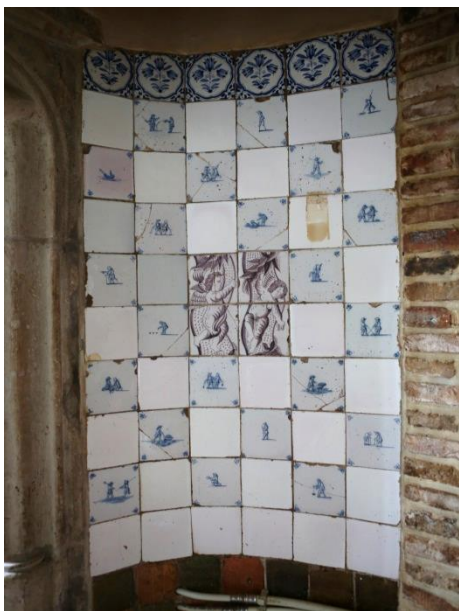
Figuur 133 Huidige toestand haardtegels woning 1 (dd. 08.08.2019) & Figuur 134 Schadebeeld tegeltjes slaapkamer woning 2 (dd. 08.08.2019)
