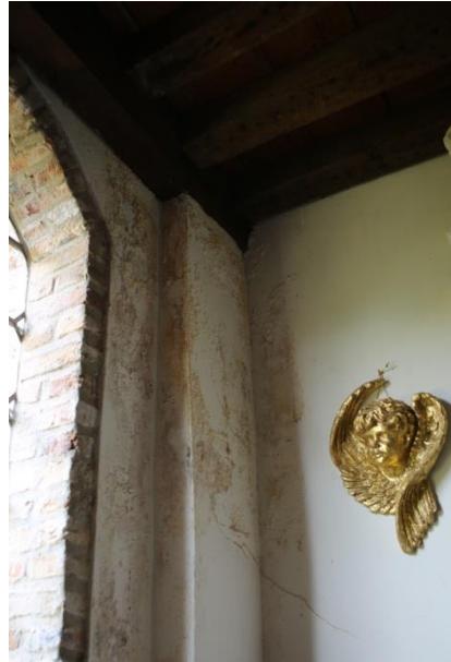
Figuur 94 Schade door roet of vocht in woning 3 (dd. 08.08.2019) & Figuur 95 Vochtschade in de kapel (dd. 08.08.2019)
