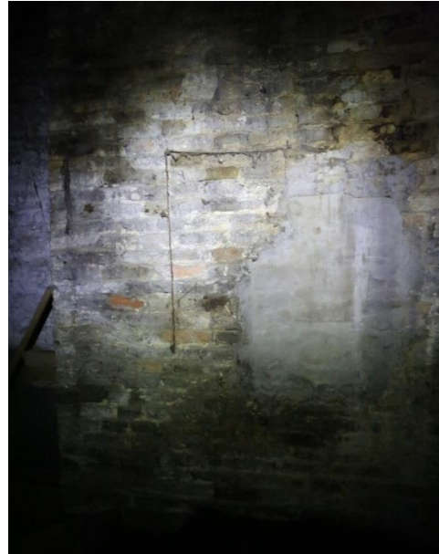
Figuur 90 Ruwe pleisterlaag aan de binnenzijde van de topgevels van vleugel 1634 (dd. 08.08.2019) & Figuur 91 Restanten van verf zolder achttiende-eeuwse vleugel (dd. 08.08.2019)
