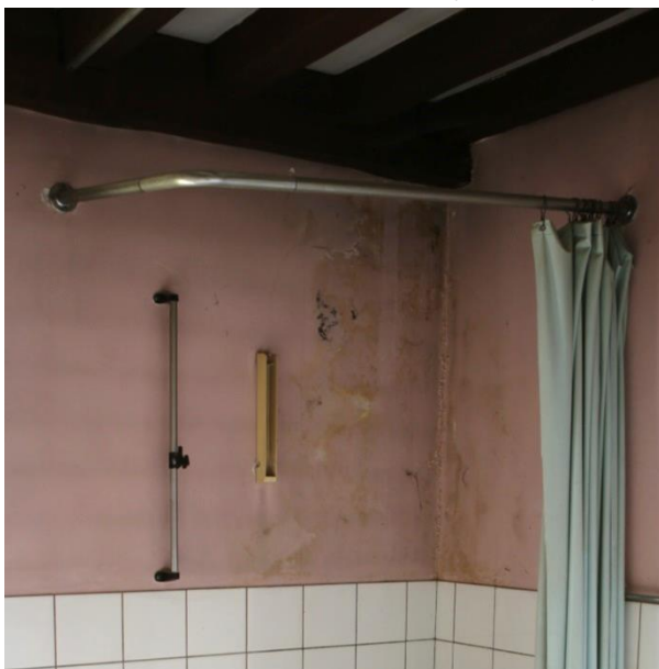
Figuur 96 Vochtschade woning 4 (dd. 08.08.2019) & Figuur 97 Fijne barsten zolder vleugel 1634 (dd. 08.08.2019)
