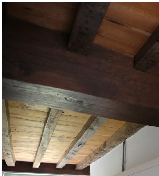
Figuur 84 Plafondbekleding met houten planken (dd. 08.08.2019) & Figuur 85 Plafondbekleding met plaatmateriaal (dd. 08.08.2019)
