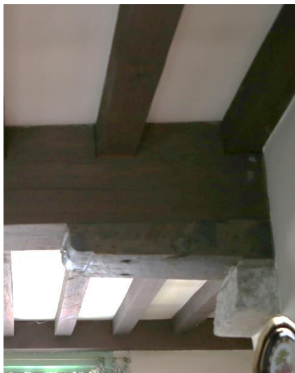
Figuur 77 Moer- en kinderbalken in de inkomhal (dd. 08.08.2019) & Figuur 78 Moerbalk in woning 3 (dd. 08.08.2019)
