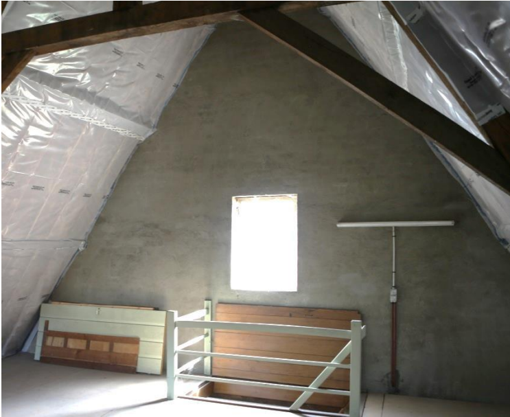
Figuur 90 Ruwe pleisterlaag aan de binnenzijde van de topgevels van vleugel 1634 (dd. 08.08.2019) & Figuur 91 Restanten van verf zolder achttiende-eeuwse vleugel (dd. 08.08.2019)
