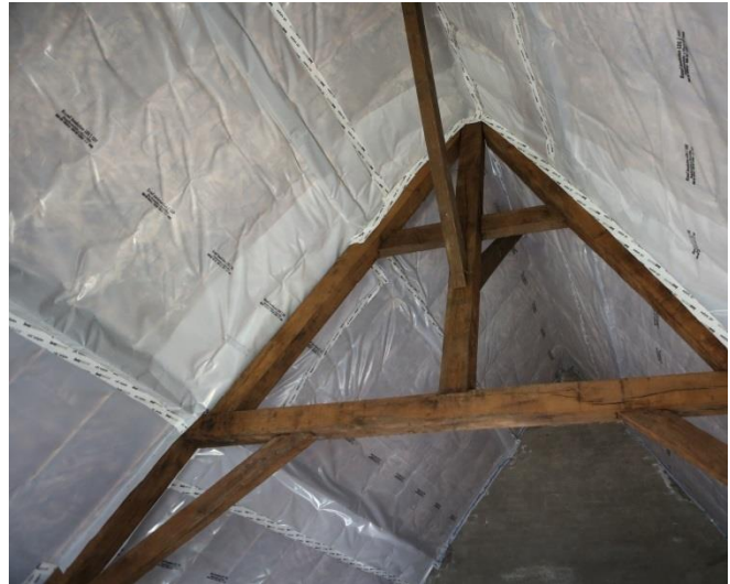
Figuur 86 Plafondbekleding met plaatmateriaal (dd. 08.08.2019) & Figuur 87 Geïsoleerd dakvlak, bekleed met folie (dd. 08.08.2019)
