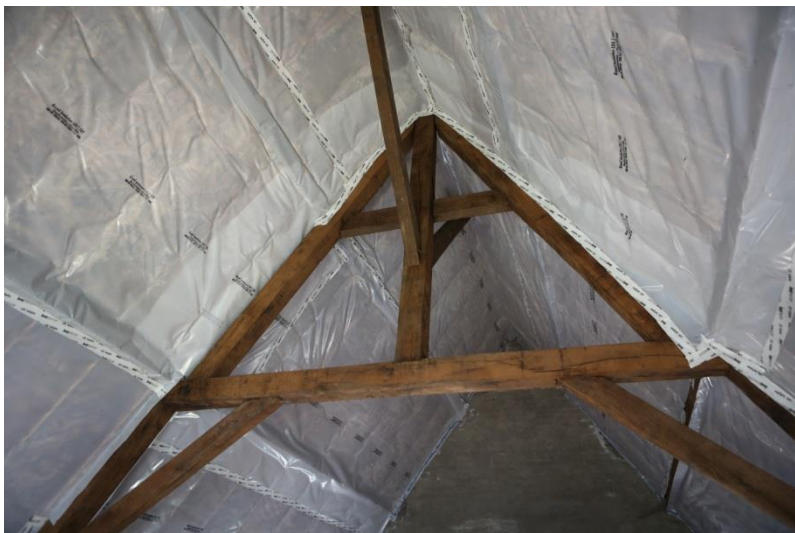
Figuur 75 Houten spantstructuur vleugel 1634 (zicht op de topgevel aan straatzijde) (dd. 08.08.2019)
