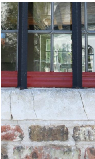
Figuur 28 Gebroken witsteen dorpel (dd. 03.07.2019) & Figuur 29 Gebroken treden in blauwe hardsteen (dd. 03.07.2019)
