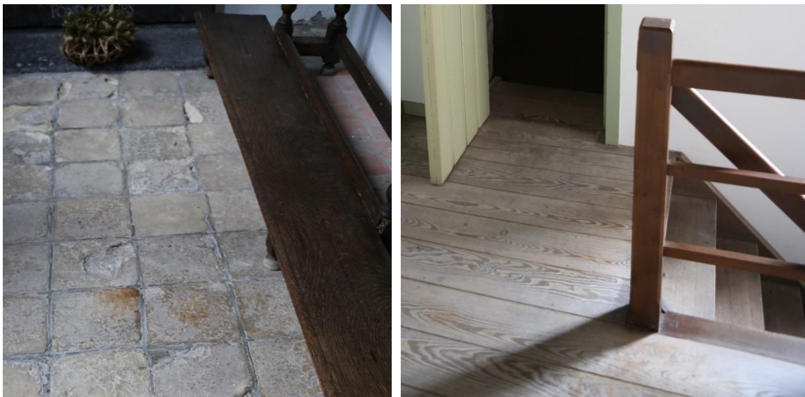
Figuur 102 Vloerafwerking kapel (dd. 08.08.2019) & Figuur 103 Vloerafwerking eerste verdieping
