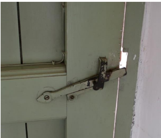
Figuur 52 Deurgrendel voordeur (dd. 08.08.2019) & Figuur 53 Huidige toestand hengen voordeur (dd. 08.08.2019)
