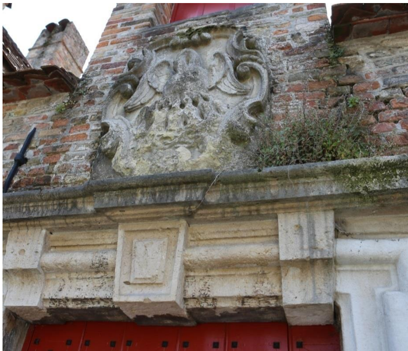
Figuur 24 Sterke vervuiling, plantengroei en uitgespoelde voegen (dd. 03.07.2019) & Figuur 25 Ontbrekende bakstenen en nokpannen schouw (dd. 08.08.2019)
