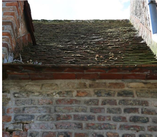
Figuur 43 Schade tegelpannen straatgevel achttiende-eeuwse gevel (dd. 03.07.2019) & Figuur 44 Schade en vervuiling dakbedekking achttiende-eeuwse vleugel (dd. 03.07.2019)
