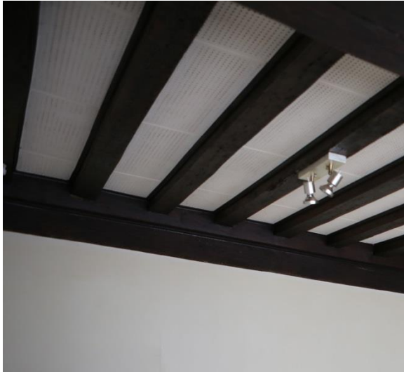
Figuur 86 Plafondbekleding met plaatmateriaal (dd. 08.08.2019) & Figuur 87 Geïsoleerd dakvlak, bekleed met folie (dd. 08.08.2019)
