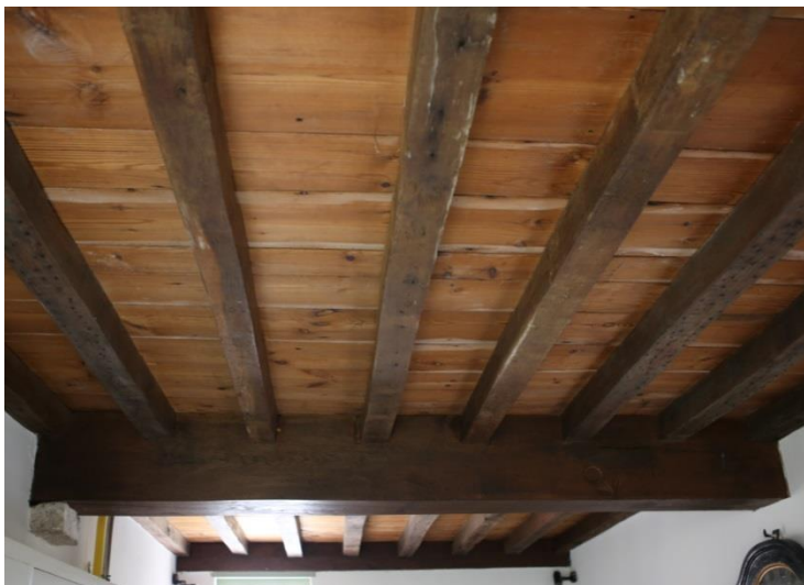
Figuur 77 Moer- en kinderbalken in de inkomhal (dd. 08.08.2019) & Figuur 78 Moerbalk in woning 3 (dd. 08.08.2019)
