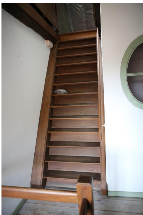
Figuur 111 Trap van eerste verdieping naar zolder (dd. 08.08.2019) &
