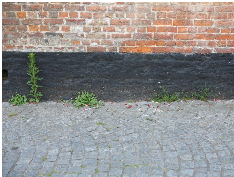
Figuur 30 Begroeiing aan de bovenzijde van de schouw (dd. 03.07.2019) & Figuur 31 Begroeiing, vervuiling plint en broos geworden stenen (dd. 03.07.2019)
