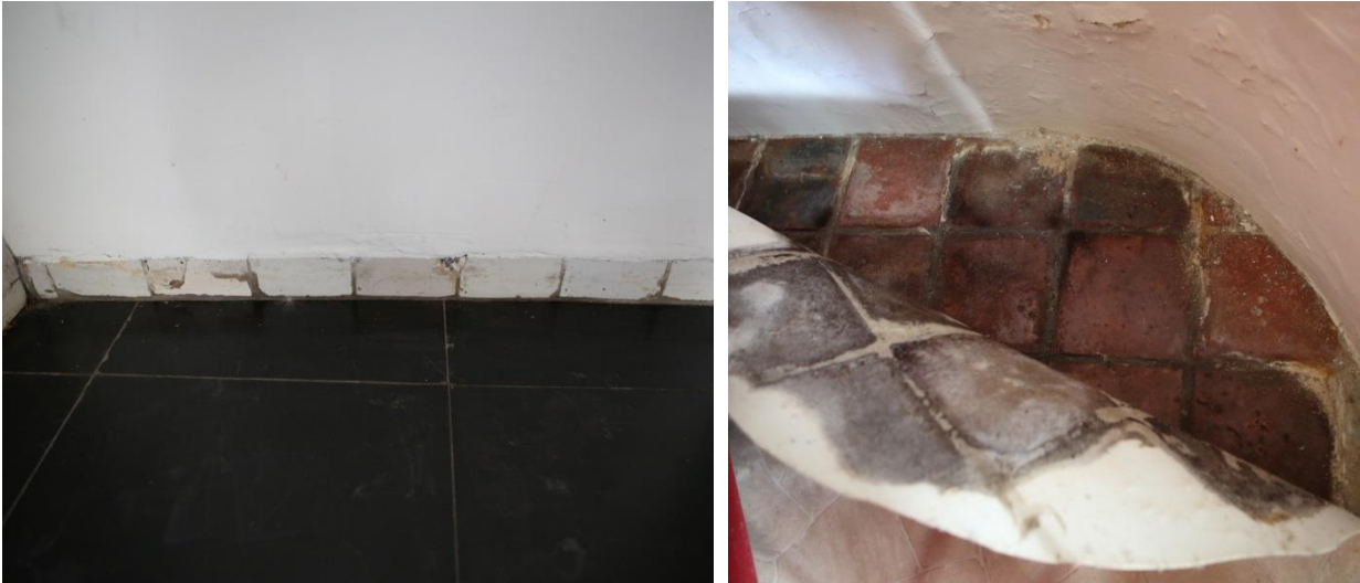
Figuur 105 Plinten in de inkomhal (dd. 08.08.2019) & Figuur 106 Huidige toestand terracottategels onder vinylvloer (dd. 08.08.2019)
