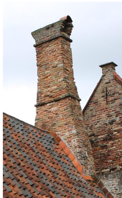
Figuur 24 Sterke vervuiling, plantengroei en uitgespoelde voegen (dd. 03.07.2019) & Figuur 25 Ontbrekende bakstenen en nokpannen schouw (dd. 08.08.2019)
