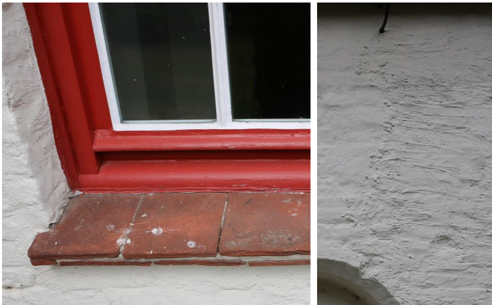
Figuur 37 Huidige toestand dorpels in terracottategels (dd. 08.08.2019) & Figuur 38 Schilderwerk boven blinde nis (08.08.2019)
