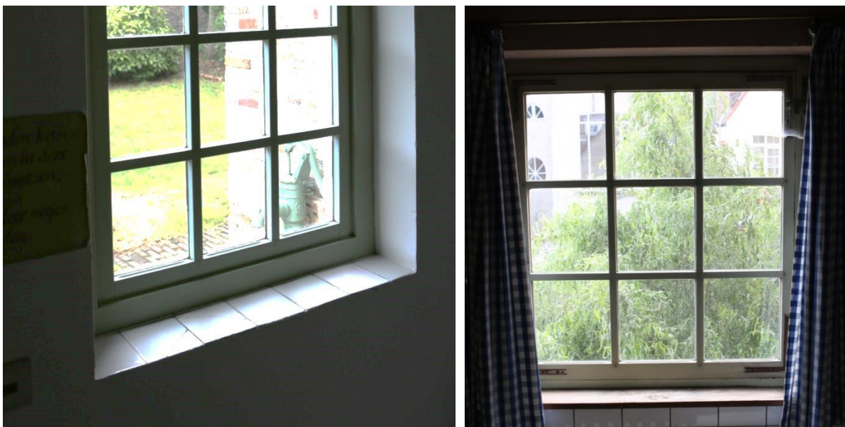
Figuur 139 Venstertablet hal met geglazuurde tegels (dd. 08.08.2019) & Figuur 140 Venstertablet woning 4 in hout (dd. 08.08.2019)
