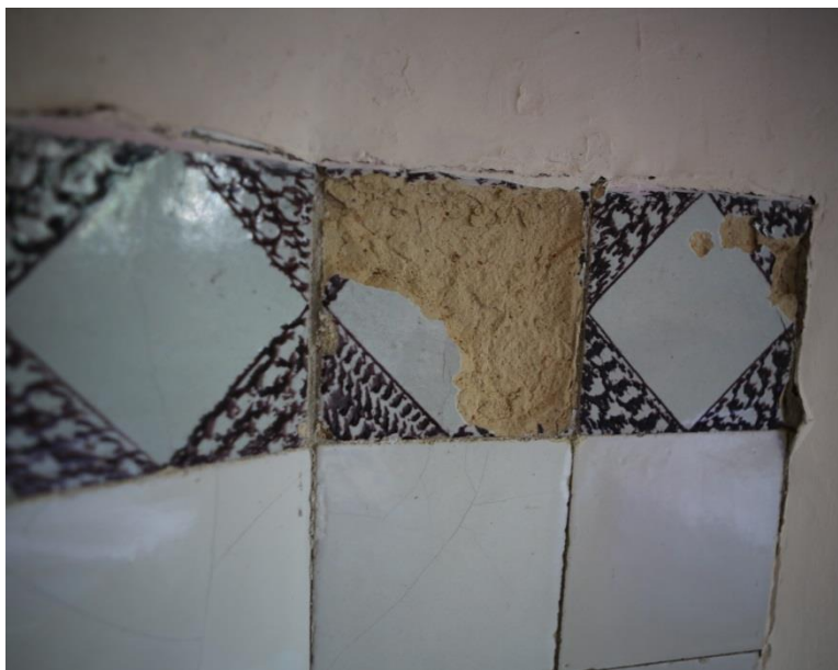
Figuur 133 Huidige toestand haardtegels woning 1 (dd. 08.08.2019) & Figuur 134 Schadebeeld tegeltjes slaapkamer woning 2 (dd. 08.08.2019)
