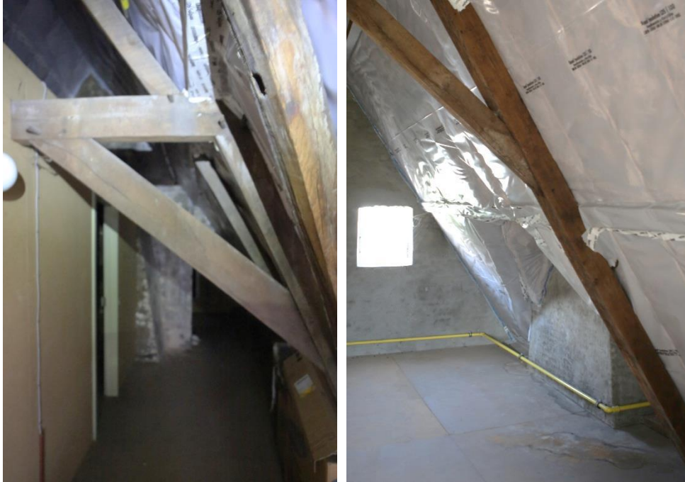
Figuur 79 Detail balkenstructuur achttiende-eeuwse vleugel (dd. 08.08.2019) & Figuur 80 Detail dakstructuur vleugel 1634 (dd. 08.08.2019)
