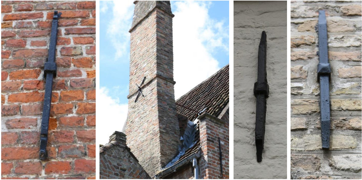
Figuur 71 Muuranker voorgevel vleugel 1634 (dd. 03.07.2019), Figuur 72 Anker en trekker centrale schouw (dd. 03.07.2019), Figuur 73 Anker achterzijde achttiende-eeuwse vleugel (dd. 08.08.2019) & Figuur 74 Anker topgevel tuinzijde (dd. 08.08.2019).
