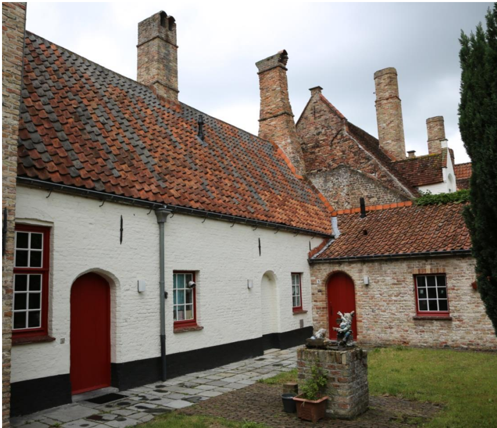
Figuur 23 Vroeg achttiende-eeuwse achtergevel, aangepast in 1971 en aanbouw dd. 1971 (dd. 08.08.2019)
