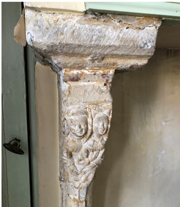
Figuur 131 Schadebeeld kopje schouw woning 1 (dd. 08.08.2019) & Figuur 132 Schadebeeld kopje schouw woning 4 (dd. 08.08.2019)
