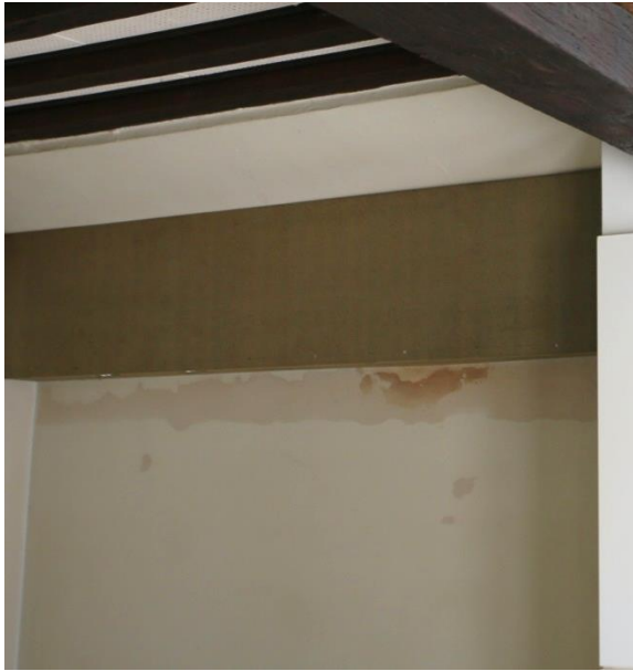
Figuur 94 Schade door roet of vocht in woning 3 (dd. 08.08.2019) & Figuur 95 Vochtschade in de kapel (dd. 08.08.2019)
