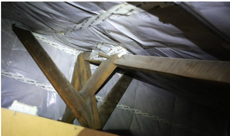
Figuur 76 Houten spantstructuur achttiende-eeuwse vleugel (dd. 08.08.2019)
