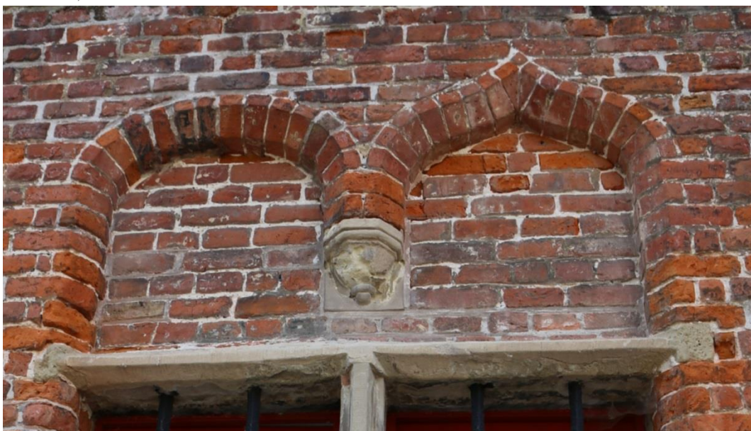
Figuur 32 Beschadigde witsteen en broos geworden bakstenen (dd. 03.07.2019)
