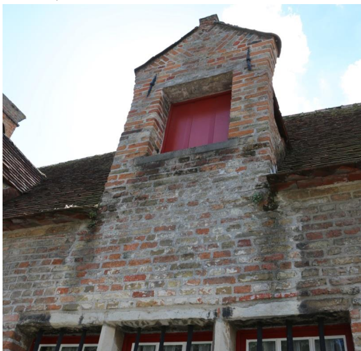
Figuur 26 Vervuiling op het metselwerk en de witsteen (dd. 03.07.2019) & Figuur 27 Plantengroei op de dakkapel (dd. 03.07.2019)
