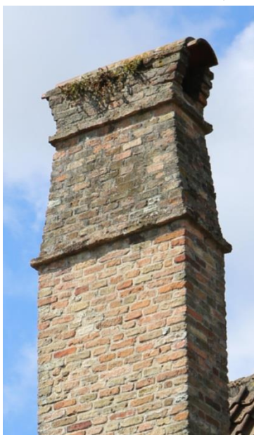
Figuur 30 Begroeiing aan de bovenzijde van de schouw (dd. 03.07.2019) & Figuur 31 Begroeiing, vervuiling plint en broos geworden stenen (dd. 03.07.2019)
