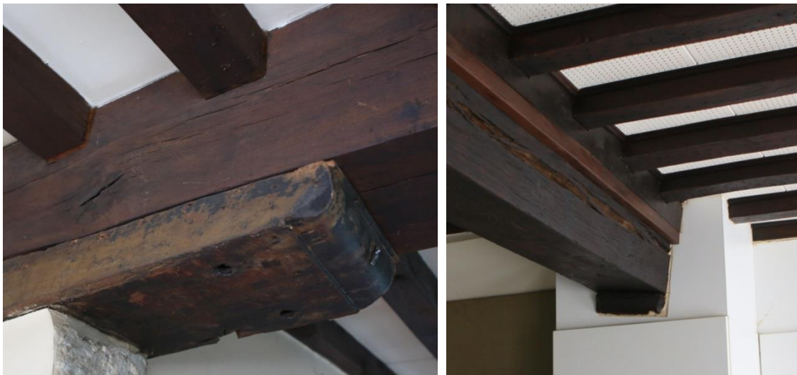
Figuur 81 Detail moerbalk met balksleutel in woning 3 (dd. 08.08.2019) & Figuur 82 Detail moerbalk woning 3 (dd. 08.08.2019)
