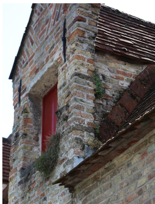
Figuur 26 Vervuiling op het metselwerk en de witsteen (dd. 03.07.2019) & Figuur 27 Plantengroei op de dakkapel (dd. 03.07.2019)
