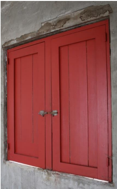
Figuur 70 Binnenzijde luik topgevel (dd. 08.08.2019)
