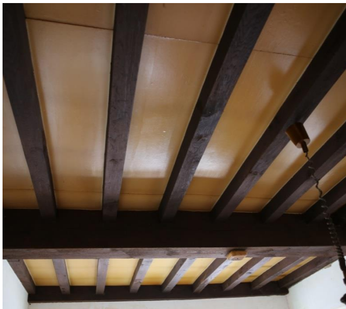
Figuur 84 Plafondbekleding met houten planken (dd. 08.08.2019) & Figuur 85 Plafondbekleding met plaatmateriaal (dd. 08.08.2019)
