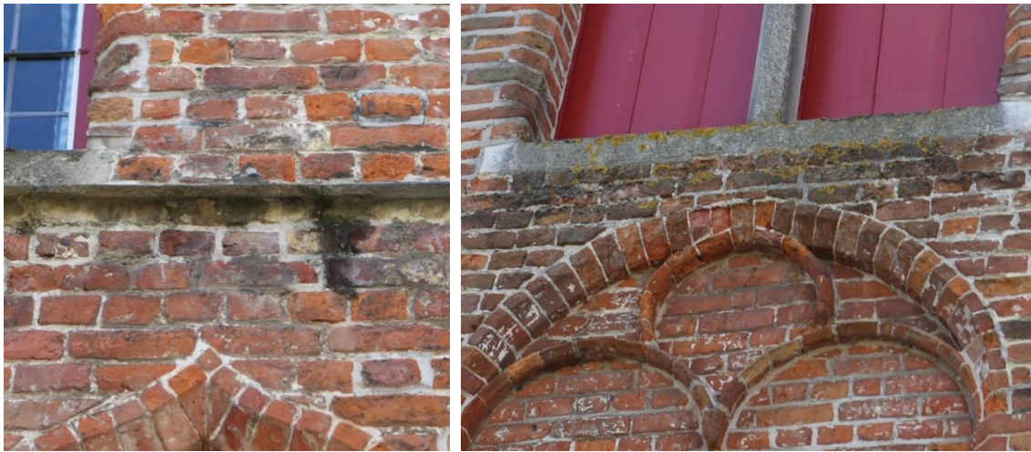
Figuur 33 Vervuiling witsteen (dd. 03.07.2019) & Figuur 34 Vervuiling witsteen en broos geworden stenen
