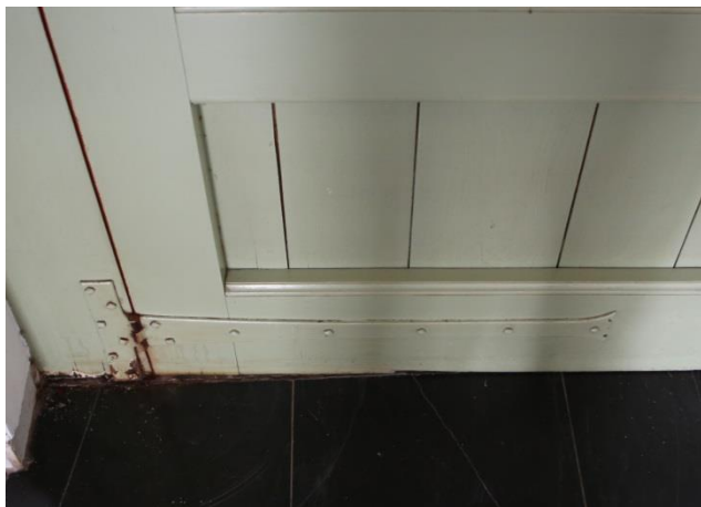
Figuur 52 Deurgrendel voordeur (dd. 08.08.2019) & Figuur 53 Huidige toestand hengen voordeur (dd. 08.08.2019)
