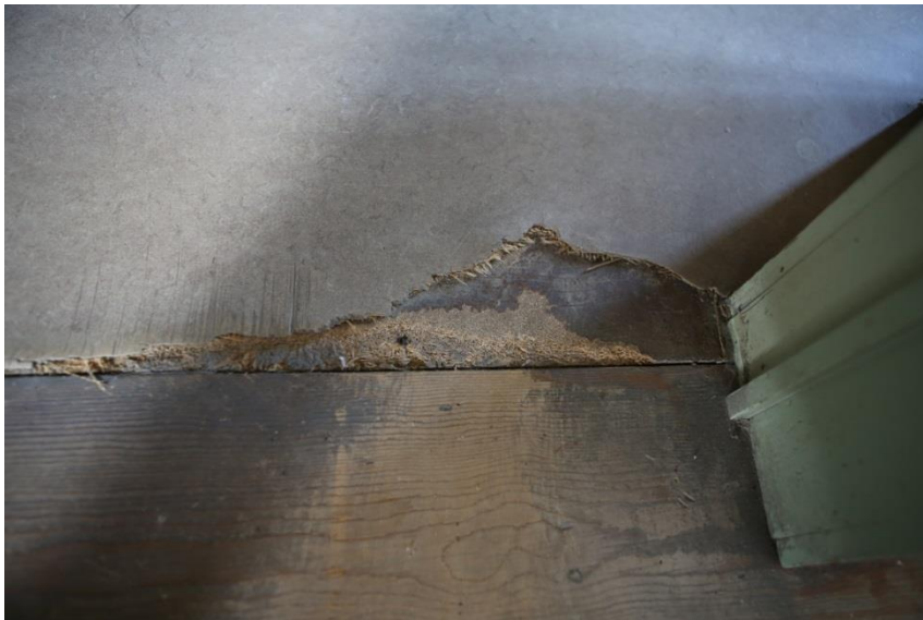
Figuur 104 Detail houten beplanking en afwerking in linoleum (dd. 08.08.2019)
