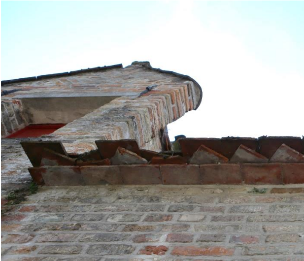
Figuur 43 Schade tegelpannen straatgevel achttiende-eeuwse gevel (dd. 03.07.2019) & Figuur 44 Schade en vervuiling dakbedekking achttiende-eeuwse vleugel (dd. 03.07.2019)
