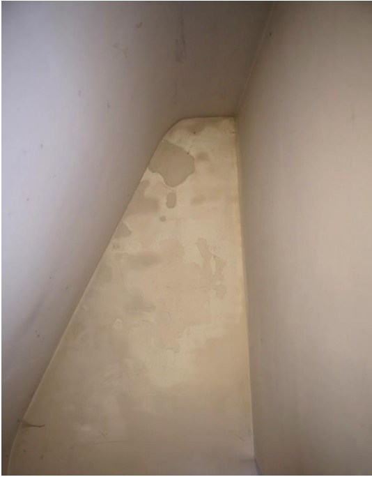
Figuur 105 Vervuiling en vochtschade op de wanden (dd. 08.08.2019) & Figuur 106 Vochtschade in het interieur (dd. 08.08.2019)
