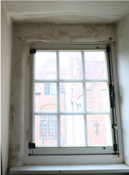
Figuur 88 Vochtschade dakkapel (dd. 08.08.2019) & Figuur 89 Schadebeeld onderdorpel raam eerste verdieping (dd. 08.08.2019)
