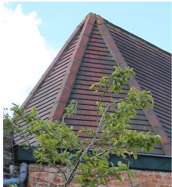
Figuur 21 Vervuiling dakrand (dd.08.08.2019) & Figuur 22 Vervuiling, voornamelijk ter hoogte van aansluiting nok en hoekkepers (dd. 08.08.2019)
