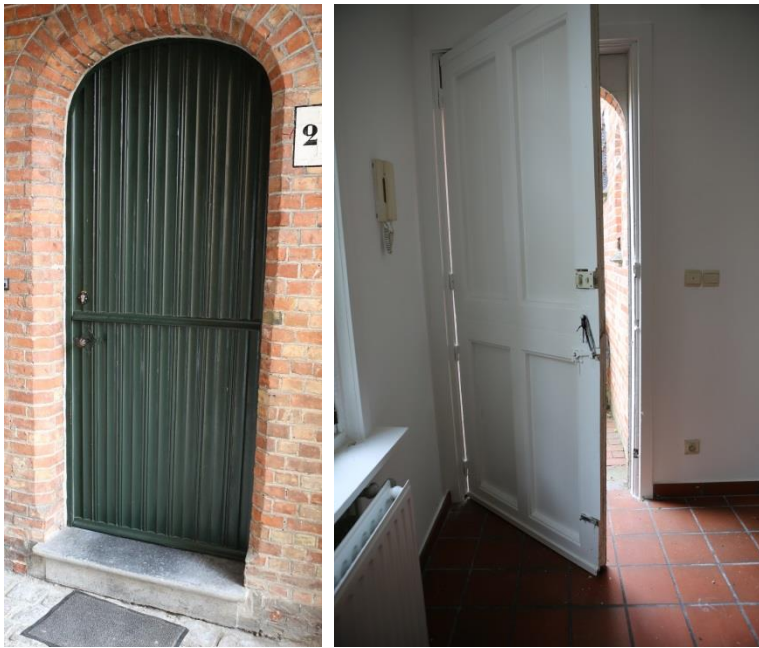
Figuur 75 Inkomdeur woning (dd. 08.08.2019) & Figuur 76 Achterzijde inkomdeur woning (dd. 08.08.2019)
