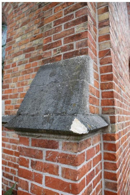
Figuur 16 Overzicht toestand metselwerk en witsteen (dd. 08.08.2019) & Figuur 17 Schade aan een witsteen afzaat (dd. 08.08.2019)
