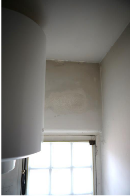
Figuur 105 Vervuiling en vochtschade op de wanden (dd. 08.08.2019) & Figuur 106 Vochtschade in het interieur (dd. 08.08.2019)
