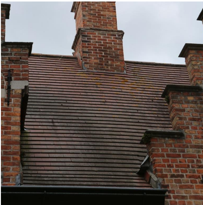
Figuur 69 Algemeen beeld vervuiling bedaking (dd. 08.08.2019) & Figuur 70 Afgevalen tegelpan (dd. 08.08.2019)
