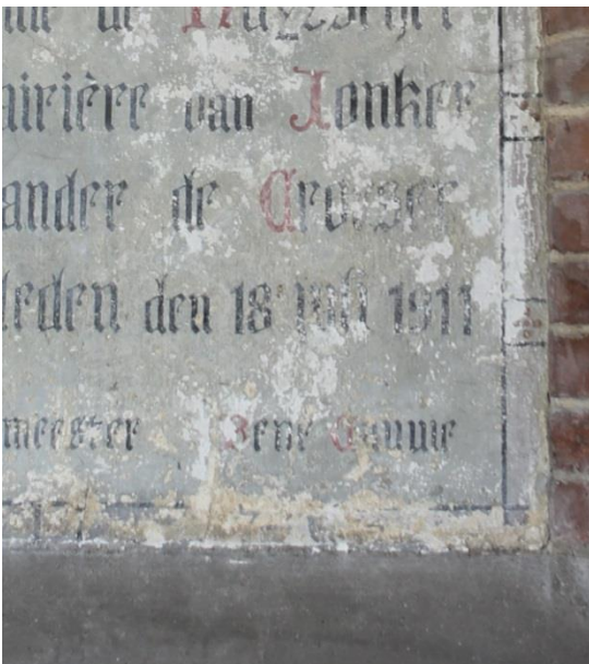
Figuur 45 Detail schadebeeld opschrift (dd. 08.08.2019) & Figuur 46 Detail schadebeeld decoratieve schildering (dd. 08.08.2019)
