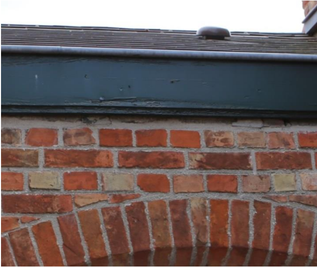
Figuur 71 Verweerde verf en schade hout (dd. 08.08.2019) & Figuur 72 Afgevallen nokpannen (dd. 08.08.2019)
