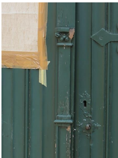
Figuur 25 Detail van de beschadigde onderzijde van de deur (08.08.2019) & Figuur 26 Detail van de beschadigde deurnaald (dd. 08.08.2019)
