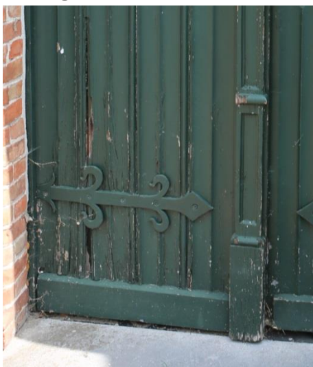
Figuur 25 Detail van de beschadigde onderzijde van de deur (08.08.2019) & Figuur 26 Detail van de beschadigde deurnaald (dd. 08.08.2019)
