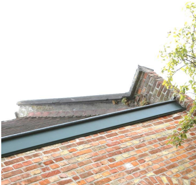
Figuur 21 Vervuiling dakrand (dd.08.08.2019) & Figuur 22 Vervuiling, voornamelijk ter hoogte van aansluiting nok en hoekkepers (dd. 08.08.2019)
