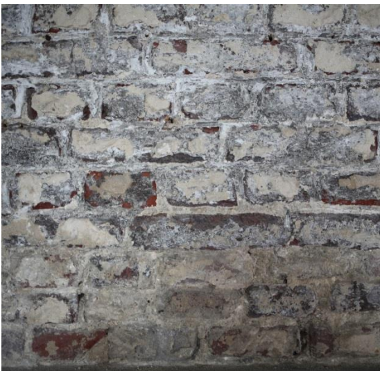
Figuur 38 Detail baksteenmuur (dd. 08.08.2019) & Figuur 39 Sterk vervuilde bepleistering (dd/ 08.08.2019)
