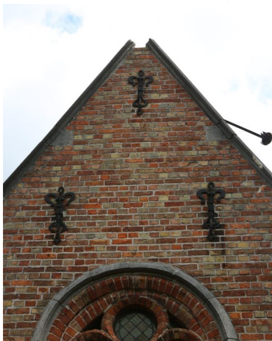
Figuur 18 Afgefallen witsteen kruis topgevel (dd. 08.08.2019) & Figuur 19 Barst in metselwerk linker schouderstuk (dd. 08.08.2019)
