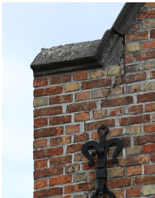
Figuur 18 Afgefallen witsteen kruis topgevel (dd. 08.08.2019) & Figuur 19 Barst in metselwerk linker schouderstuk (dd. 08.08.2019)
