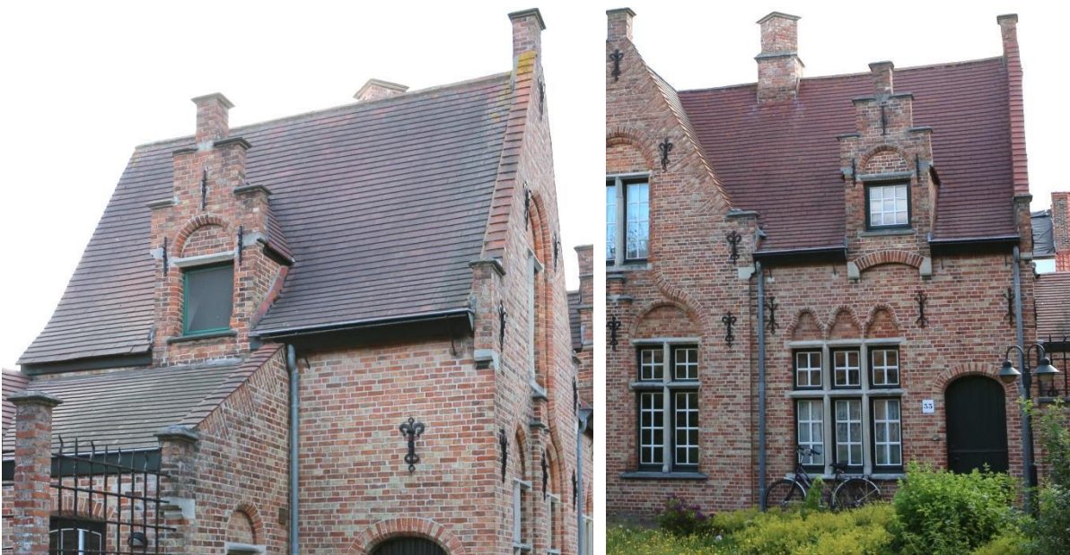
Figuur 66 Overzicht bedaking (dd. 08.08.2019) & Figuur 67 Overzicht bedaking (dd. 08.08.2019)
