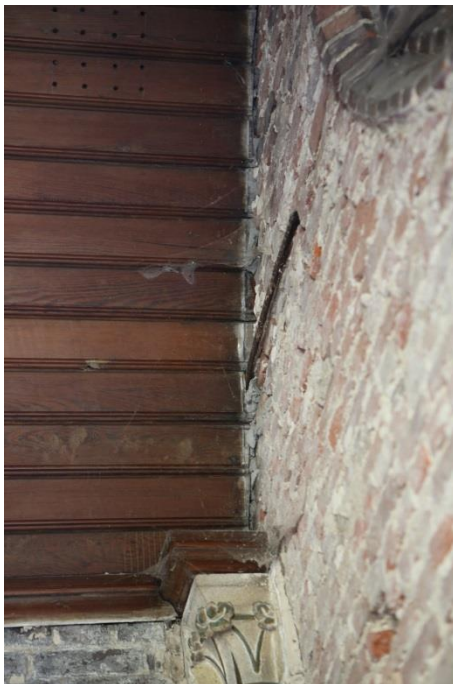
Figuur 33 Aansluiting houten beplanking/gevel (dd. 08.08.2019) & Figuur 34 Schadebeeld sierlijst (dd. 08.08.2019)
