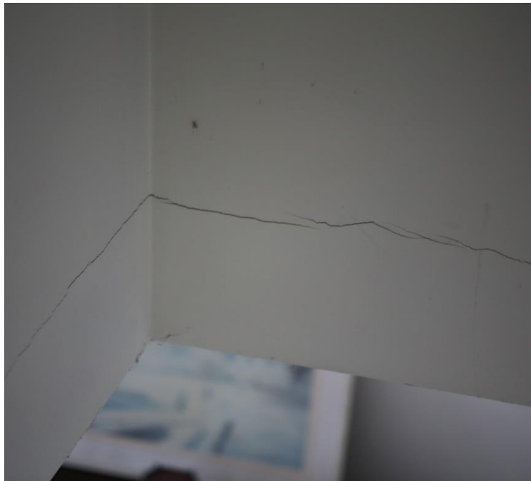
Figuur 107 Fijne barst in de haardboezem (dd. 08.08.2019) & Figuur 108 Scheurvorming ter hoogte van trapgat (dd. 08.08.2019)
