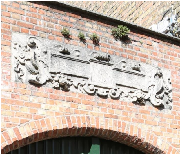
Figuur 60 Schade beeld metselwerk en cartouche boven inkompoort (dd. 08.08.2019) & Figuur 61 Scheurvorming trapgevel (dd. 08.08.2019)
