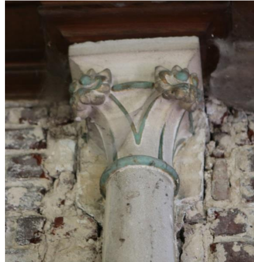
Figuur 40 Schade natuursteenlijst (dd. 08.08.2019) & Figuur 41 Kapiteel halfzuil en achterliggend metselwerk (dd. 08.08.2019)
