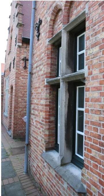
Figuur 62 Vervuiling witsteen (dd. 08.08.2019) & Figuur 63 Vervuiling witsteen (08.08.2019)
