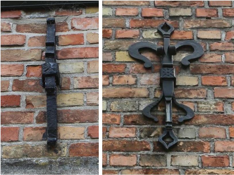
Figuur 30 Sober muuranker zijgevel (dd. 08.08.2019) & Figuur 31 Versierd muuranker voorgevel (dd. 08.08.2019)
