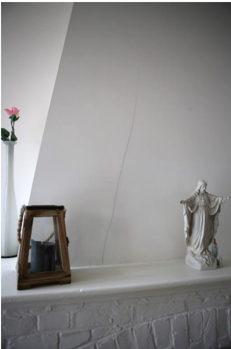
Figuur 107 Fijne barst in de haardboezem (dd. 08.08.2019) & Figuur 108 Scheurvorming ter hoogte van trapgat (dd. 08.08.2019)
