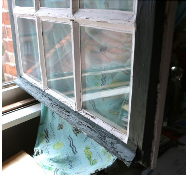
Figuur 88 Vochtschade dakkapel (dd. 08.08.2019) & Figuur 89 Schadebeeld onderdorpel raam eerste verdieping (dd. 08.08.2019)
