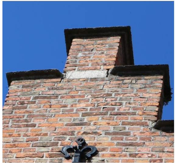
Figuur 60 Schade beeld metselwerk en cartouche boven inkompoort (dd. 08.08.2019) & Figuur 61 Scheurvorming trapgevel (dd. 08.08.2019)
