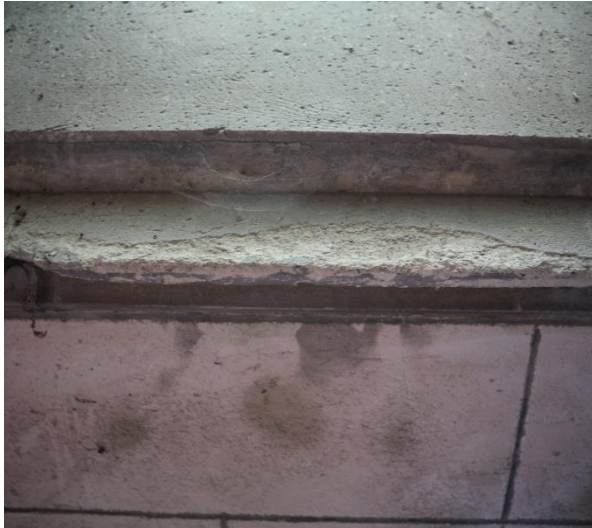
Figuur 40 Schade natuursteenlijst (dd. 08.08.2019) & Figuur 41 Kapiteel halfzuil en achterliggend metselwerk (dd. 08.08.2019)
