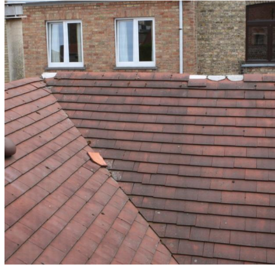
Figuur 71 Verweerde verf en schade hout (dd. 08.08.2019) & Figuur 72 Afgevallen nokpannen (dd. 08.08.2019)
