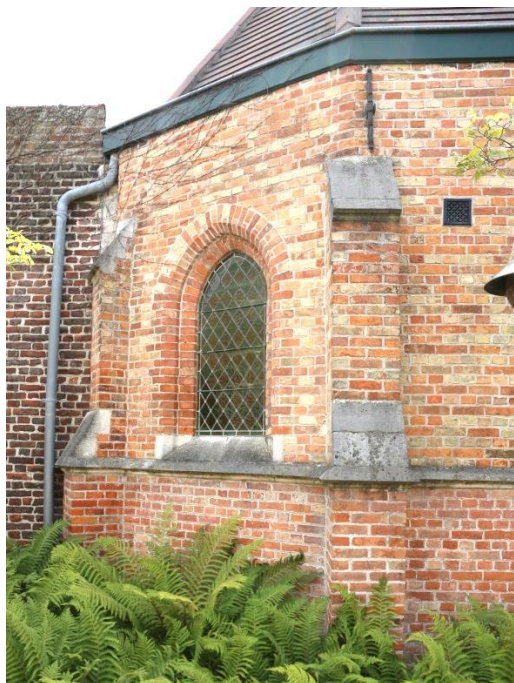
Figuur 16 Overzicht toestand metselwerk en witsteen (dd. 08.08.2019) & Figuur 17 Schade aan een witsteen afzaat (dd. 08.08.2019)
