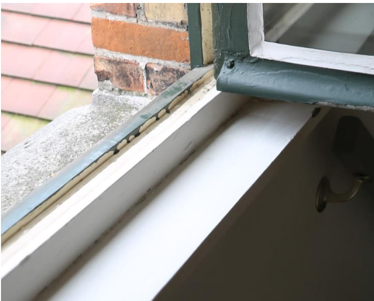
Figuur 120 Gebruikerssporen en beschadiging aan raamtablet (dd. 08.08.2019)
