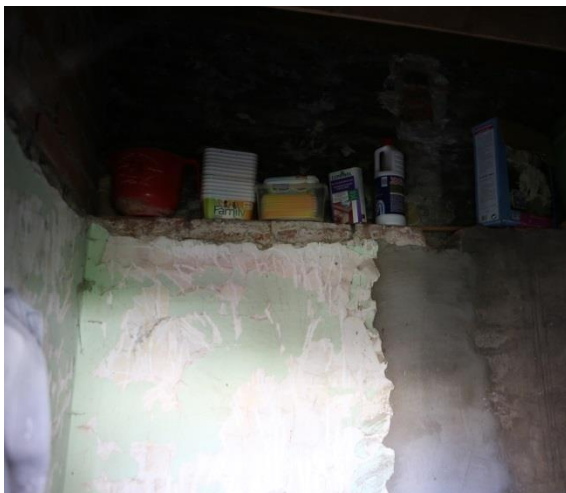
Figuur 76 Wandafwerking bijgebouwtje tuin (04.07.2019)
