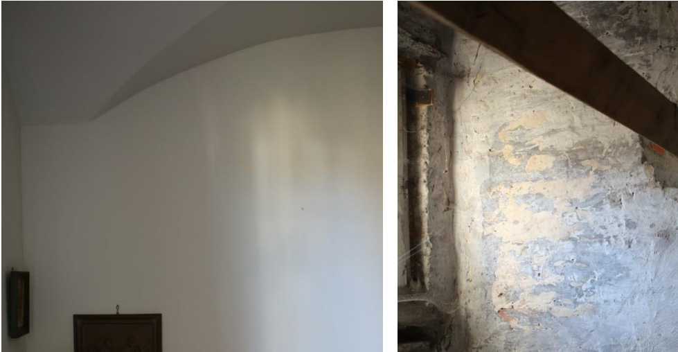
Figuur 77 Detail wand slaapkamer woning straatzijde (04.07.2019) & Figuur 78 Detail wand zolder woning straatzijde (04.07.2019)
