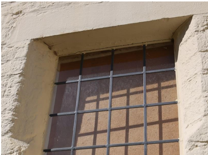
Figuur 60 Barst tussen glas-in-lood en gevel bij bovenlicht tuingevel woning straatzijde (04.07.2019) & Figuur 61 Binnenzijde luik tuitgevel woning straatzijde (04.07.2019)
