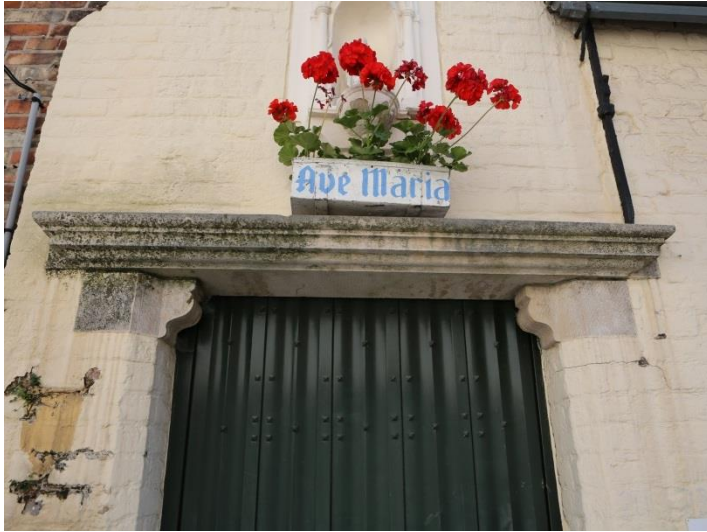
Figuur 32 Vervuiling linteel inkompoort straatgevel (03.07.2019) & Figuur 33 Ontbrekend muuranker tuingevel woning achteraan (04.07.2019)
