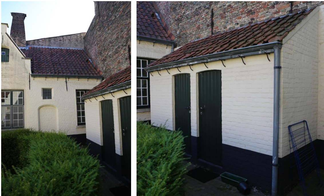
Figuur 26 Tuingevel woningen aan de achterzijde (04.07.2019) & Figuur 27 Bijgebouwtje tegen de rechter scheidingsgevel (04.07.2019)
