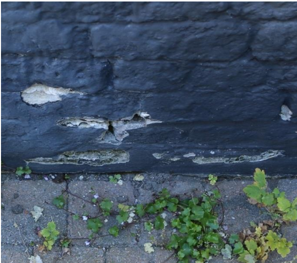
Figuur 28 Afschilferend schilderwerk tuingevel woning achterzijde (04.07.2019) & Figuur 29 Plantengroei in ontbrekende voegen rechts van de inkompoort in de straatgevel (03.07.2019)
