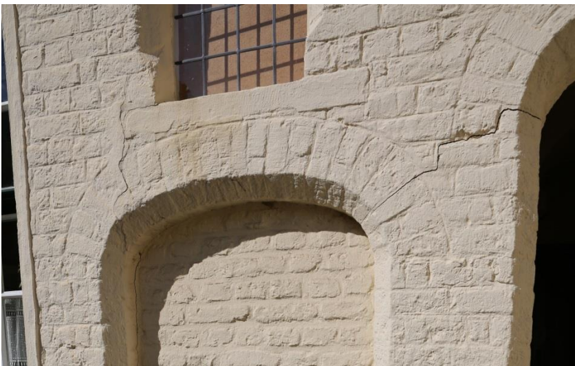
Figuur 30 Scheurvorming in het metselwerk tuingevel woning straatzijde (04.07.2019) & Figuur 31 Algemene vervuiling schilderwerk (04.07.2017)
