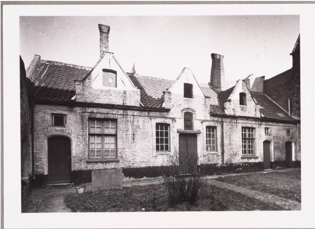
Figuur 12 Toestand tuingevel woning achteraan tijdens of vlak voor de restauratie dd. 1953 (bron: beeldbank Brugge, geraadpleegd op 08.07.2019)
