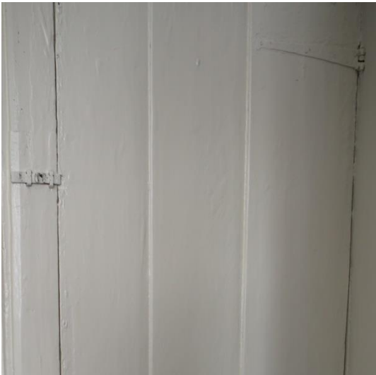
Figuur 99 Detail hang- en sluitwerk deur naar zolder (04.07.2019)
