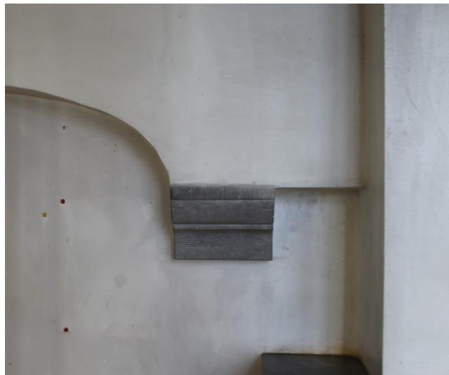
Figuur 102 Korbogen en console slaapkamer woning achteraan (04.07.2019) & Figuur 103 Console leefruimte woning achteraan (04.07.2019)
