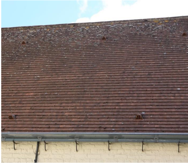
Figuur 38 Tegelpannen straatzijde (03.07.2019), Figuur 39 Hanggoot straatzijde (03.07.2019) & Figuur 40 Regenwaterafvoer straatzijde (03.07.2019)
