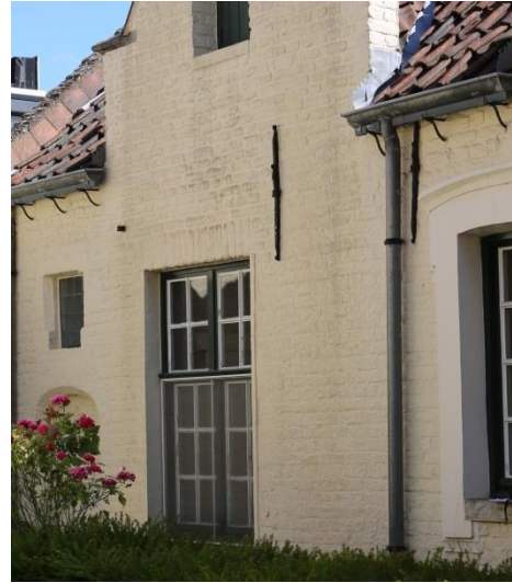
Figuur 32 Vervuiling linteel inkompoort straatgevel (03.07.2019) & Figuur 33 Ontbrekend muuranker tuingevel woning achteraan (04.07.2019)
