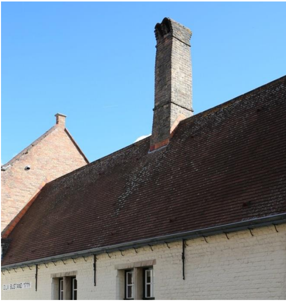
Figuur 34 Zadeldak (straatzijde) woning straat met dakbedekking in rode tegelpannen (03.07.2019) & Figuur 35 Zadeldak (tuinzijde) woning straat met dakbedekking in rode tegelpannen (04.07.2019)
