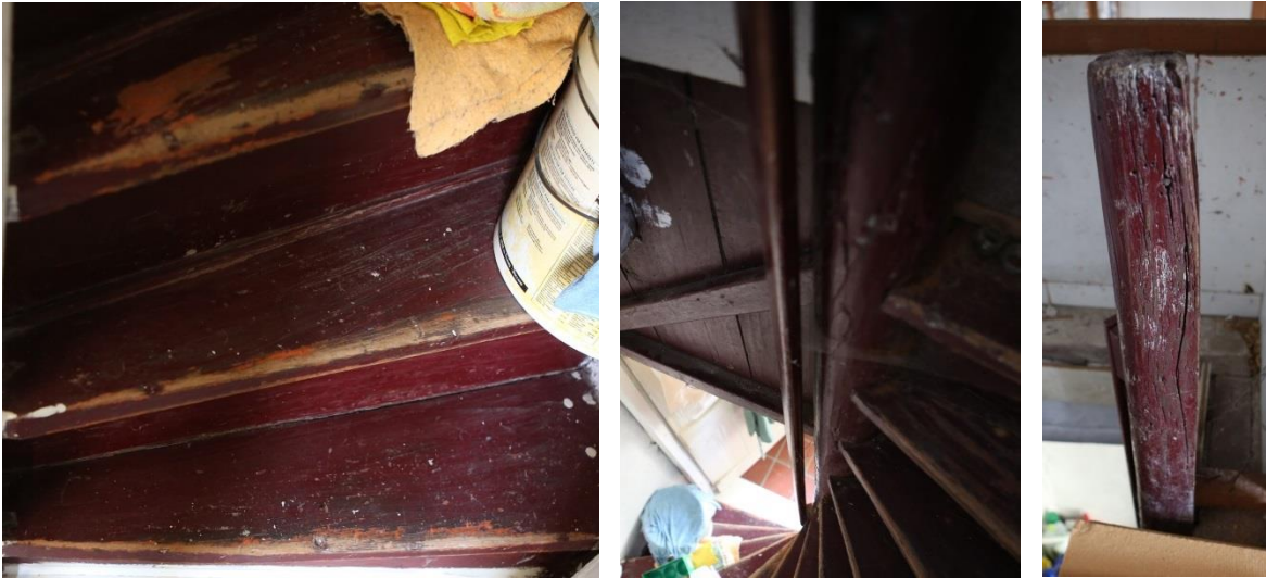
Figuur 90 Detail traptreden (04.07.2019), Figuur 91 Handgreep en trappaal (04.07.2019) & Figuur 92 Bovenzijde trappaal (04.07.2019)
