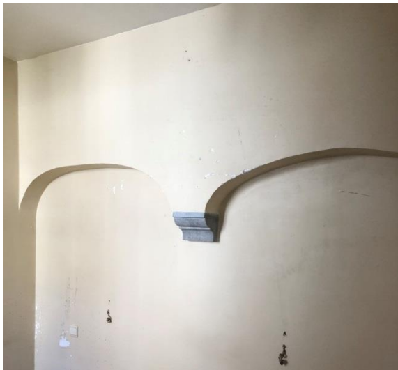
Figuur 102 Korbogen en console slaapkamer woning achteraan (04.07.2019) & Figuur 103 Console leefruimte woning achteraan (04.07.2019)
