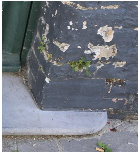
Figuur 28 Afschilferend schilderwerk tuingevel woning achterzijde (04.07.2019) & Figuur 29 Plantengroei in ontbrekende voegen rechts van de inkompoort in de straatgevel (03.07.2019)
