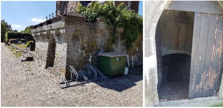
Figuur 2-17: Zuidelijke (links) en oostelijke (rechts) toegang
