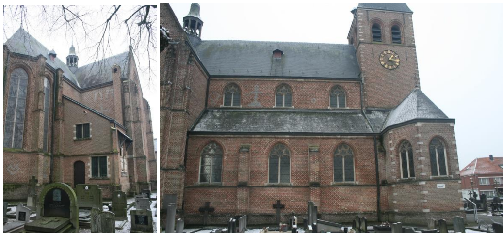
Figuur 2.2-1: Noordelijk transept en koor, ARAT 2019 (links) en Noordelijke zijgevel, ARAT 2019 (rechts)
