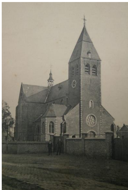
Figuur 2.2-13: De kerkhofmuur, gezien vanuit de Kerkstraat. De poort is gesloten en ondoorzichtig. Door het plaatsen van een nieuwe grille betekende dit bij de veranderingswerken dus dat het zicht op de kerk sterk zou verbeteren. Ook het poortje naar de pastorie is zichtbaar (in hout). De muur heeft twee verschillende hoogtes, en het achterste deel (tussen de inkom en de tuin van de pastorie) wijkt nog een flink stuk achteruit. De huidige kerkhofmuur werd dus voor dit deel verder naar voor geplaatst en het kleine poortje is verdwenen (maar ingewerkt in een ander deel van de kerkhofmuur – tegenover de ingang van de kerk).
