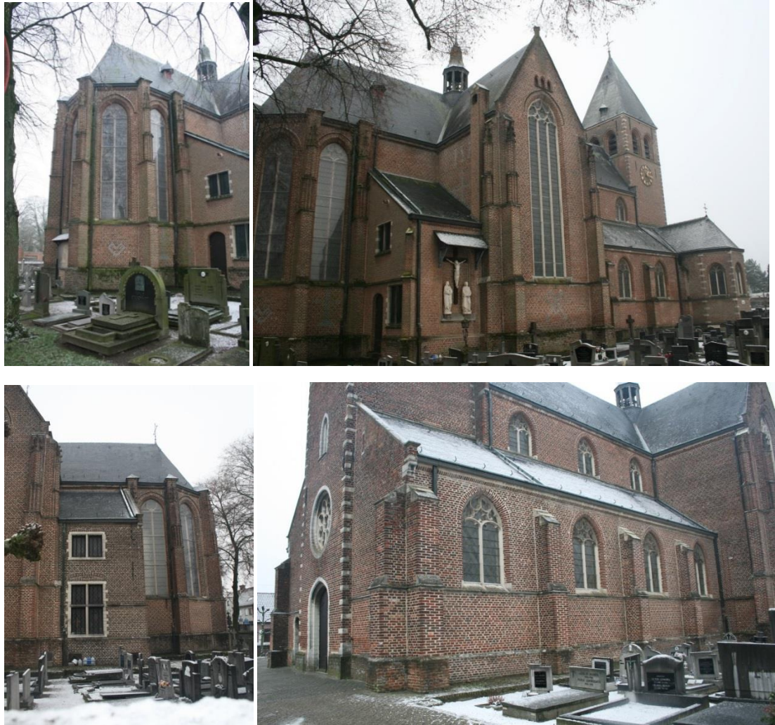
Figuur 3.2-1: a, b, c & d: Zicht op het koor, de noordelijke gevel, de zuidelijke koorzijde en zuidelijke zijbeuk, ARAT 2019
