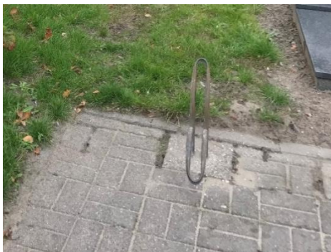
Figuur 3.3-21: Verharding fietsenstalling
