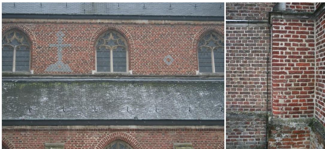
Figuur 3.2-3: Zicht op de metselairsteken van de noordelijke gevel, ARAT 2019 (links) en duidelijk verschil in baksteen tussen doopkapel en westtoren, ARAT 2019 (rechts)
