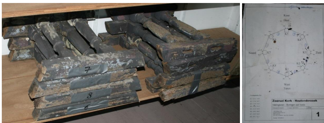
Figuur 3.2-7: De ontmantelde balustrade van de vieringstoren in de toren en verslag van houtboringen door Triconsult, ARAT 2019
