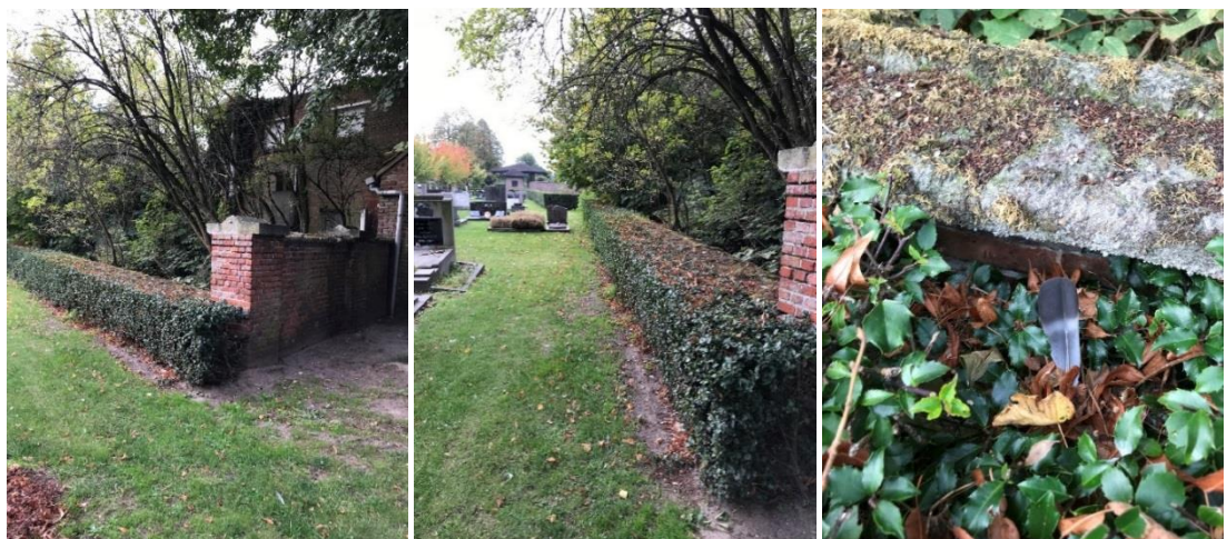
Figuur 3.3-36: Ommuring in het westen
