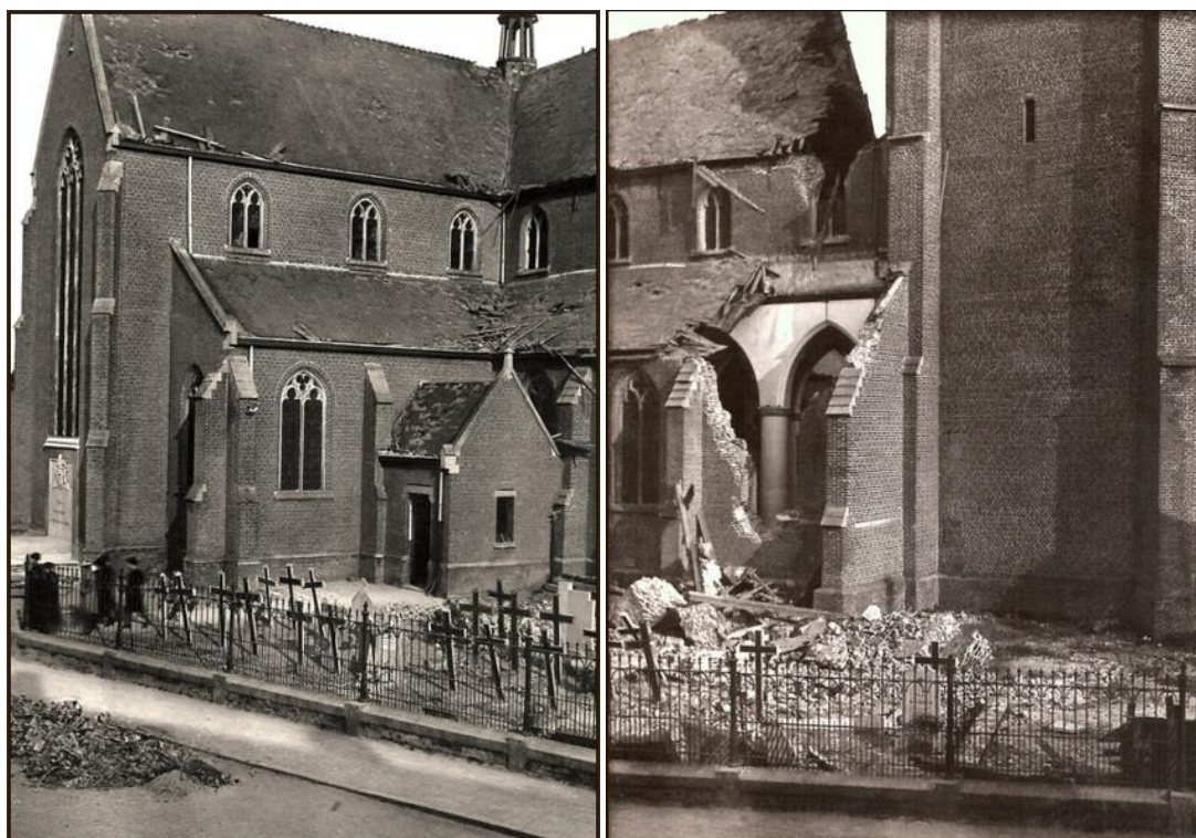
Figuur 2.2-62: op deze foto's is de verwoesting duidelijk te zien. Heel wat graven zijn onherstelbaar beschadigd.
