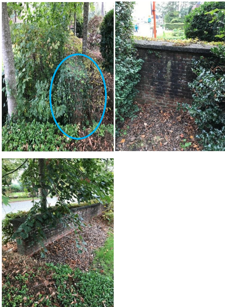
Figuur 3.3-35: Ommuring in het zuiden
