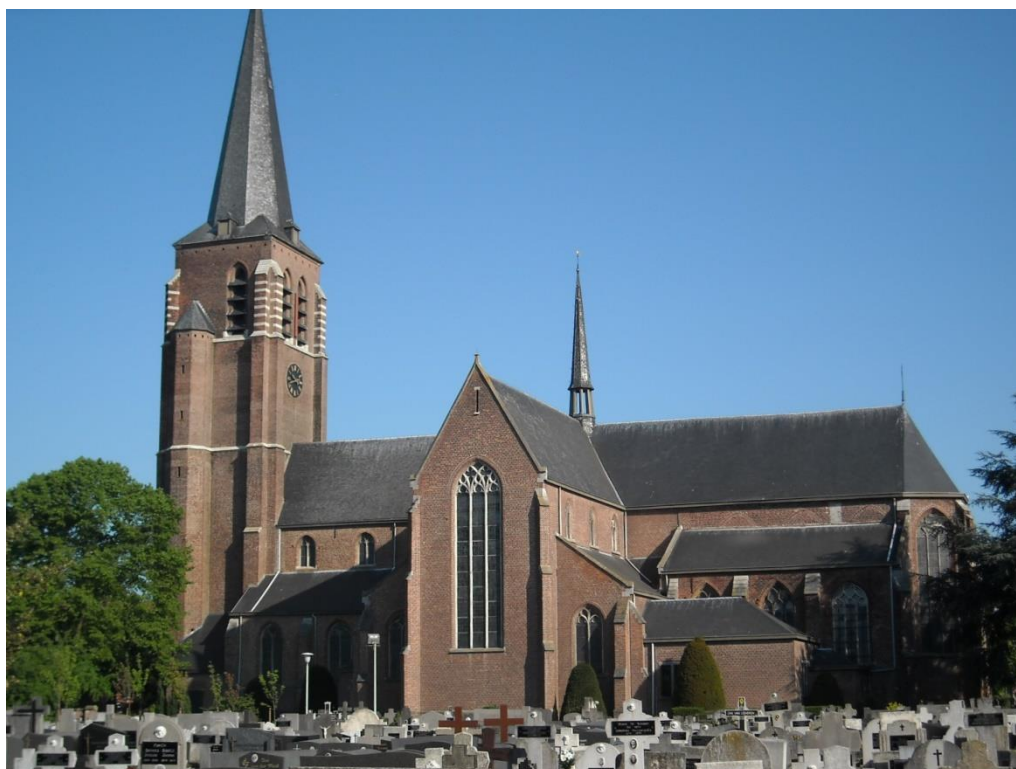
Figuur 3.2-1: Zicht op de zuidelijke gevel van de kerk, ARAT 2014
