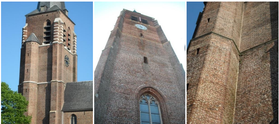
Figuur 3.2-3: Zicht op het metselwerk van de toren, ARAT 2018
