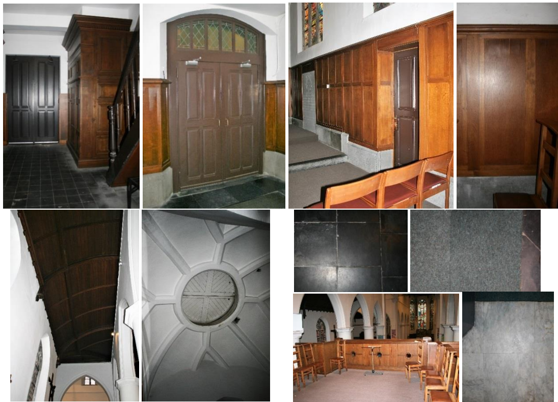
Figuur 3.2-9: Enkele beelden van het schrijnwerk, lambrisering, tongewelf, gewelf toren, natuurstenen vloeren, tapijt en doksaal, ARAT 2019
