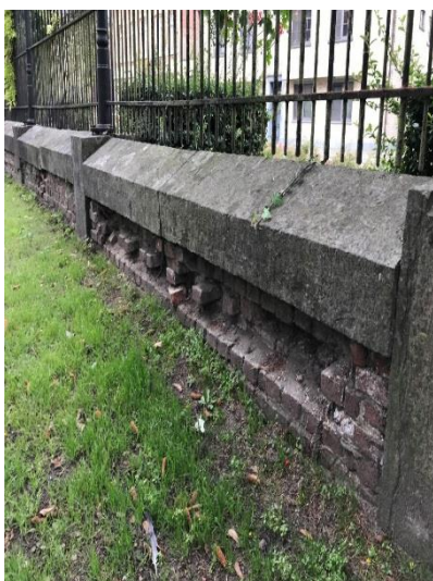
Figuur 3.3-39: laag muurtje waarop hekwerk geplaatst is
