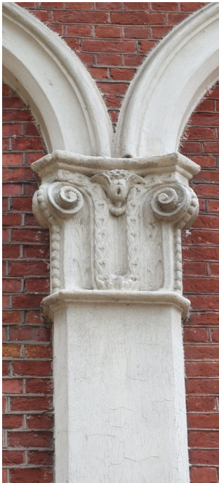
afb. 40: Detail van een pilaster
