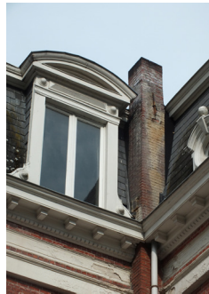
afb. 49: Details van de achtergevel: bakgoot, paneeldecoratie en gedenksteen op het aangebouwde deel aan de achtergevel
