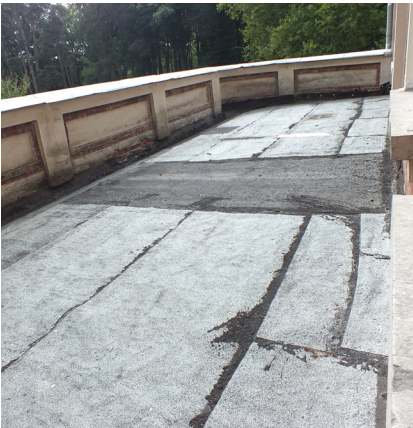
afb. 53: Plat dak aan de achtergevel
