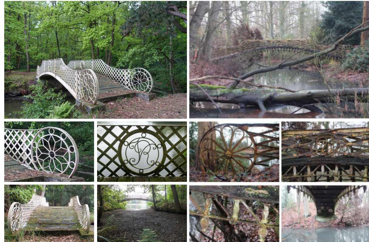
afb. 137: Foto's van de ijzeren brug uit 1871, het centrale medaillons draagt de initialen van de opdrachtgevers
