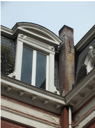
afb. 52: Detail van het dak
