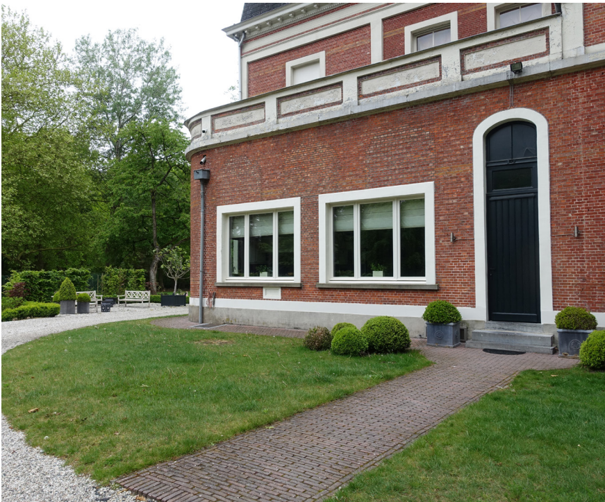
afb. 49: Details van de achtergevel: bakgoot, paneeldecoratie en gedenksteen op het aangebouwde deel aan de achtergevel
