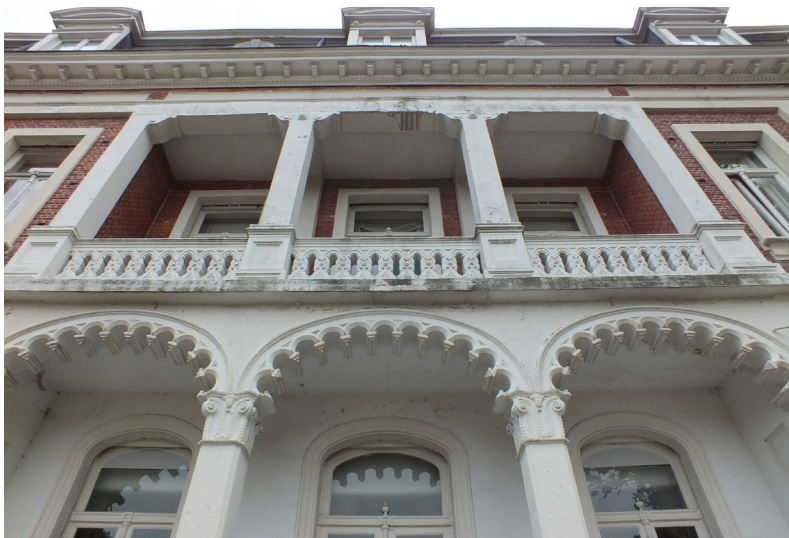
afb. 42: Detail van de inspringing van de voorgevel over twee niveaus
