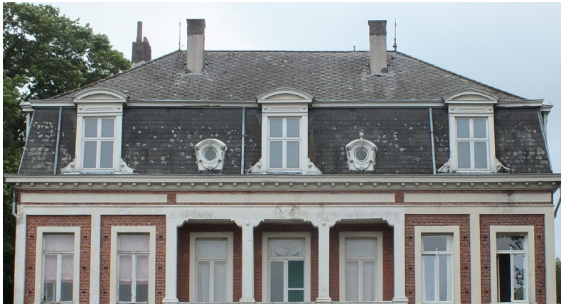
afb. 54: Zicht op het Frans dak - voorgevel zijde
