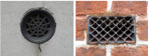
afb. 46: Twee types ventilatiegaten
