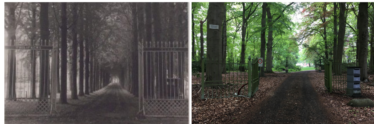
afb. 140: De oorspronkelijke toegangspoort met hekwerk is verdwenen
