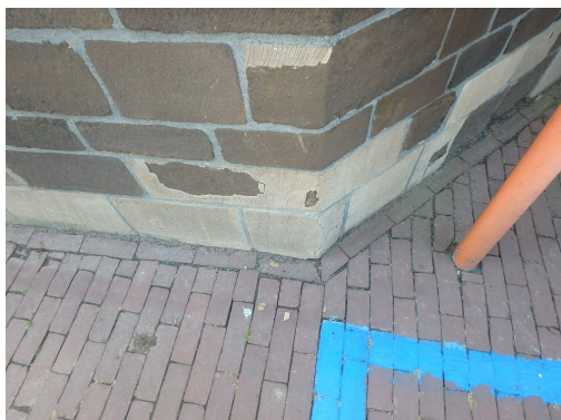
Gearsten mortelherstelling onderaan vleugel [7].
