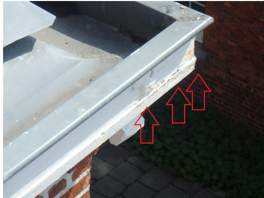
Afbladderend schilderwerk van de kroonlijst aan vleugel [3].
