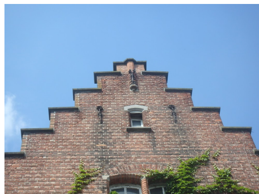
Sterk uitgespoeld voegwerk voornamelijk ter hoogte van top- en schouderstukken.
