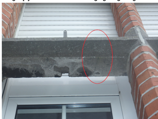
Uitgespoeld voegwerk van de lijst boven de plint van vleugel [1]-noord met vochtindringing tot gevolg.
