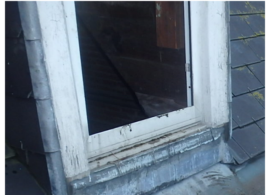
Afbladderend schilderwerk van de dakkapel kader aan dak [2]-west.
