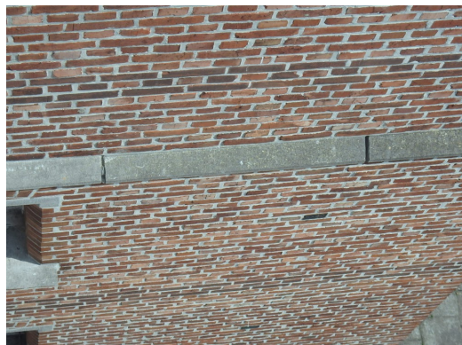
Uitgespoeld voegwerk van de uitkragende lijsten.
