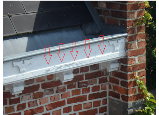
Afbladderend schilderwerk van de kroonlijst aan vleugel [1]-zuidoost.
