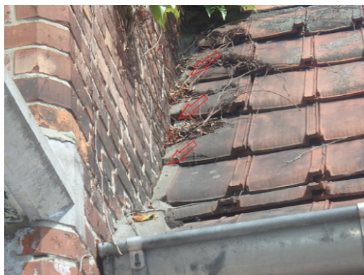
Vleugel [5]-zuidwest: losscheurende mortelaanwerking. Vleugel [5]-zuidoost: losscheurende mortelaanwerking.
