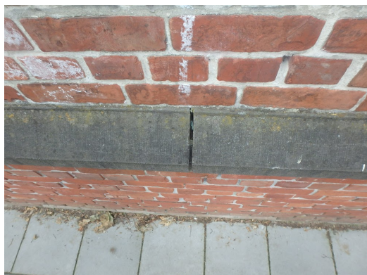
Uitgespoeld voegwerk van de lijst boven de plint van vleugel [1]-noord met vochtindringing tot gevolg.
