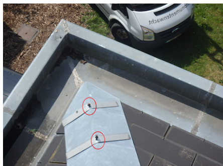
Dak [3]: opgedrukte vernageling van de hoekkeperafwerking.
