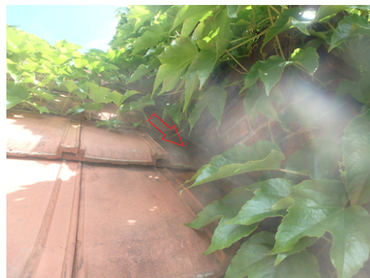
Vleugel [5]-zuidwest: losscheurende mortelaanwerking. Vleugel [5]-zuidoost: losscheurende mortelaanwerking.
