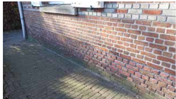
afb. 308: Plint met uitgespoelde voegen
