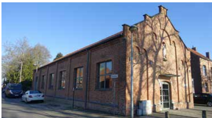
afb. 244: Zijgevel west en voorgevel
