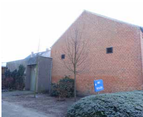
afb. 250: Achtergevel met recente aanbouw ten oosten
