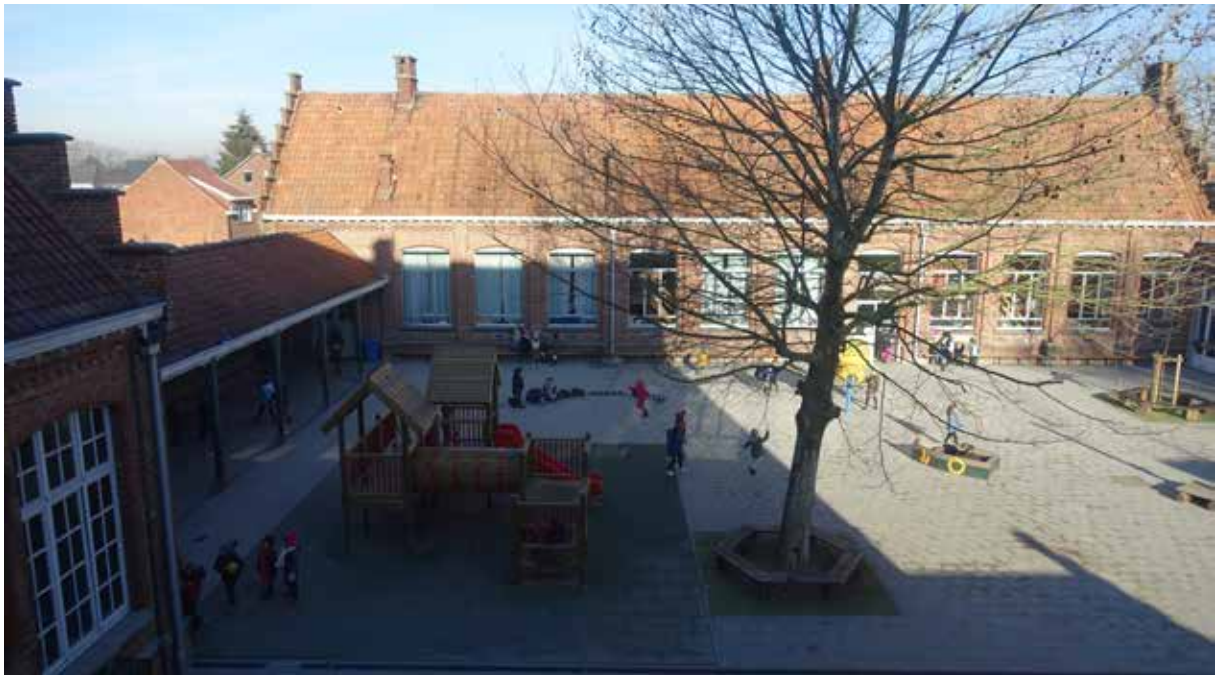
afb. 340: Zicht op de speelplaats vanuit het kloostergebouw
