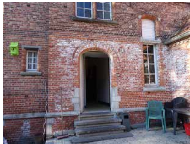
afb. 316: Bouwspoor van een aanbouw aan de achtergevel
