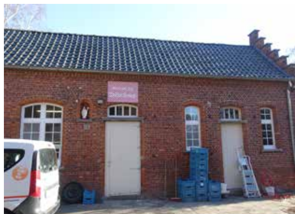
afb. 322: Voorgevel van het bijgebouw
