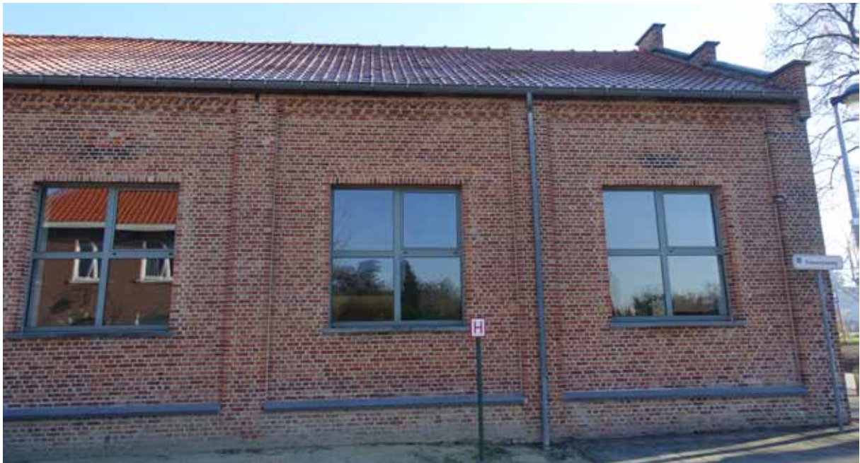
afb. 257: Recente bijbouw ten oosten van oorspronkelijk gebouw
