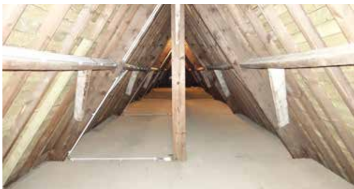
afb. 182: De houten dakstructuur boven het schip
