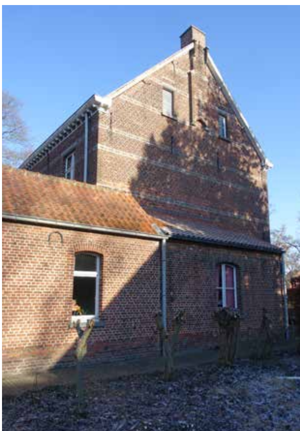
afb. 278: Zuidgevel met recentere aanbouw
