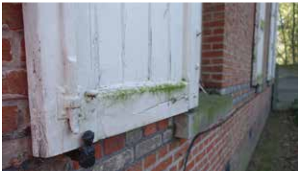
afb. 307: Verschaald houtwerk
