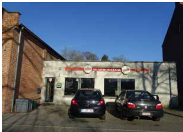
afb. 246: Recente bijbouw ten oosten van oorspronkelijk gebouw
