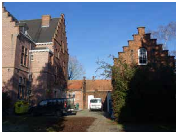
afb. 315: Zicht op de achtergevel van het klooster met bijgebouw
