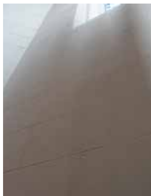
afb. 167: Huidige witte muurafwerking met schijnvoegen
