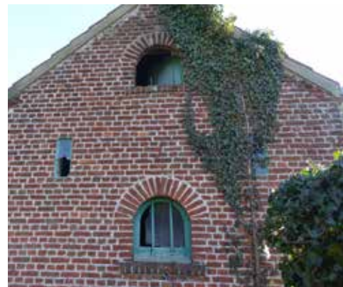
afb. 286: Schrijnwerk in de kopse gevel van de aanbouw
