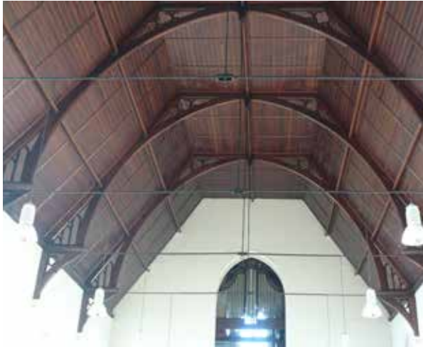
afb. 176: Ziende kap met trekstangen boven het schip
