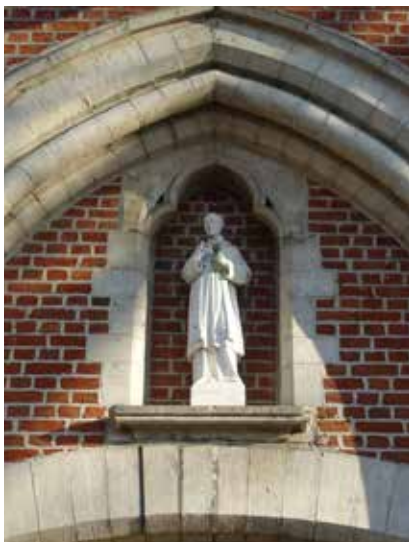
afb. 156: Detail van het hoofdportaal
