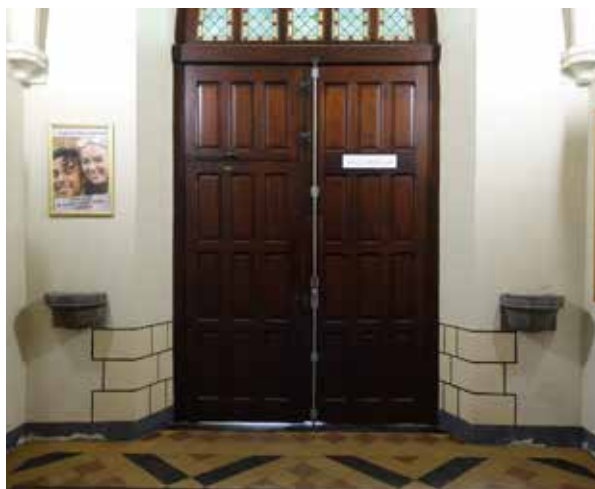
afb. 171: Details van dubbele toegangsdeur naar het schip
