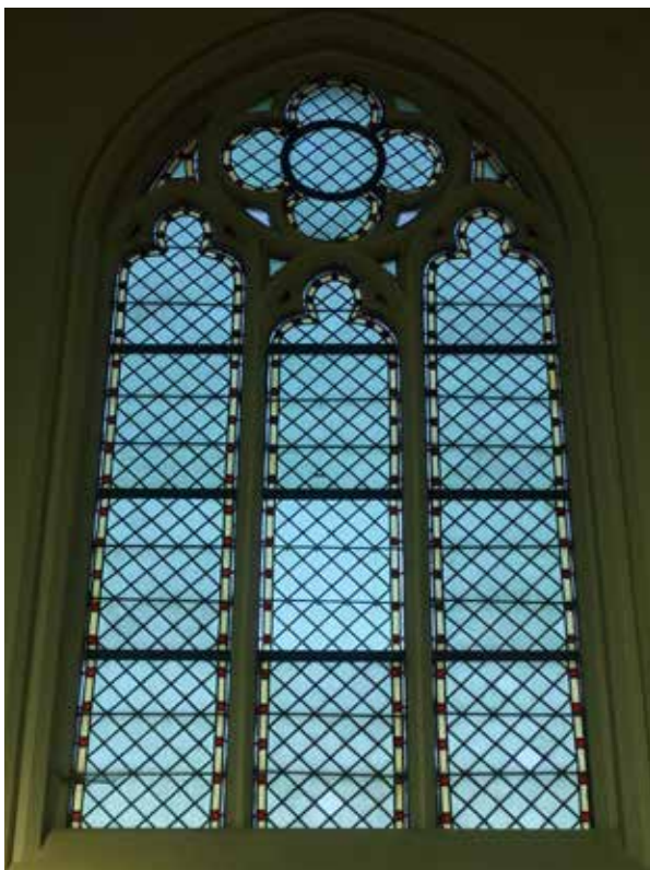
afb. 173: Een drielichtvenster met vierlob in het schip
