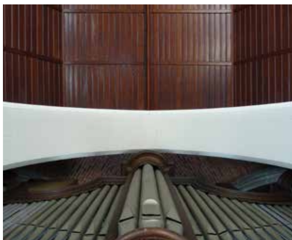
afb. 185: Ziende kap, scheiboog en bakstenen gewelf boven orgel
