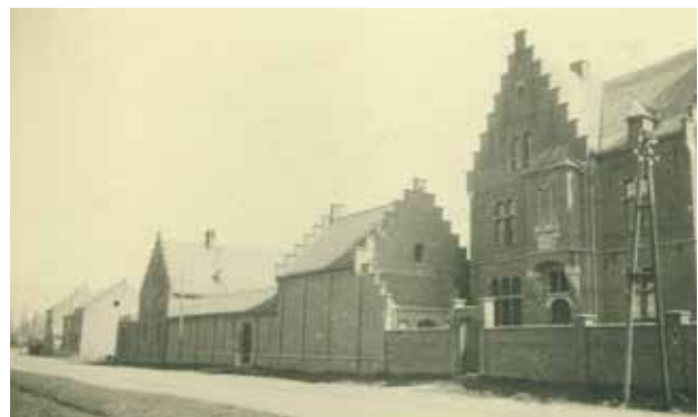
afb. 106: Het schoolgebouw en klooster in 1939 © Delcampe
