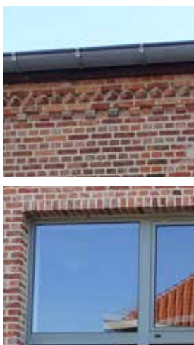
afb. 249: Detail muizentand, detail schrijnwerk, detail zijgevel west
