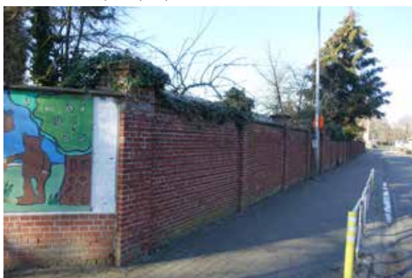
afb. 333: Detail van de afsluitingsmuur aan de Schoolstraat
