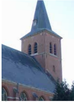
afb. 162: Noord- en oostgevel
