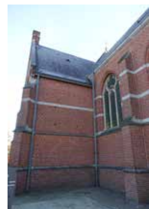
afb. 148: Voorbeelden van regenwatafvoer met standpijpen
