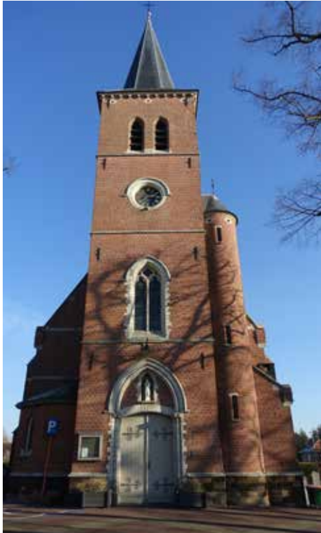
afb. 158: De toren met portaal en uurwerk
