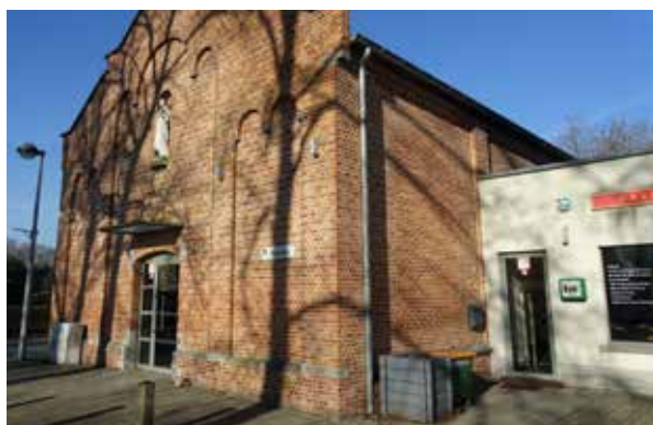
afb. 247: Recente bijbouw ten oosten van oorspronkelijk gebouw
