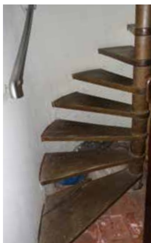
afb. 184: Draaitrap in de traptoren
