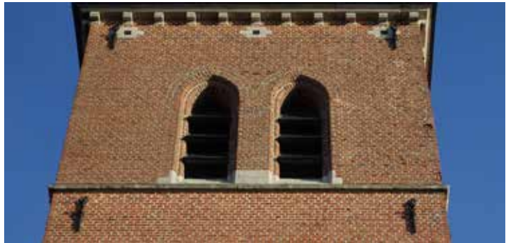
afb. 159: De vierde geleding met galmgaten en bovenaan steigergaten
