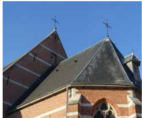
afb. 147: Het lessenaarsdak van het koor met afgeschuinde hoeken aan de absis
