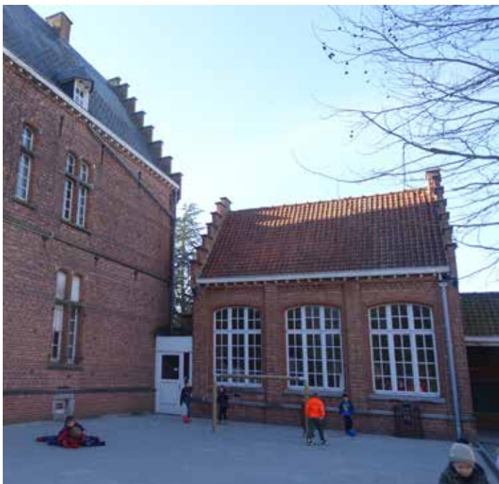
afb. 336: Kloostergebouw links met aanpalend de aparte klasruimte
