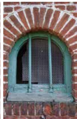
afb. 309: Verschaald hout
