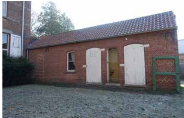
afb. 290: Zicht op noordmuur van aanbouw
