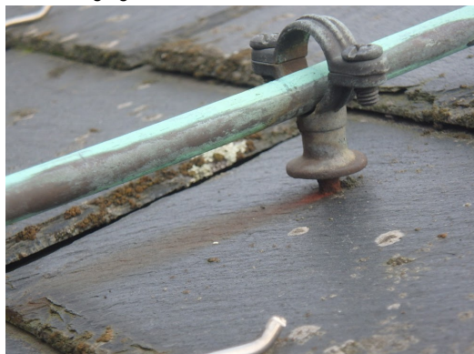
De bevestiging is niet waterdicht.
