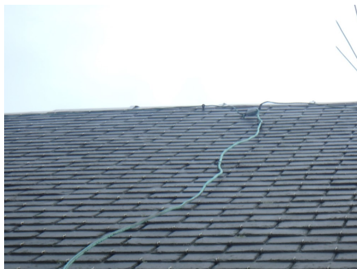
De bevestiging is niet waterdicht.
