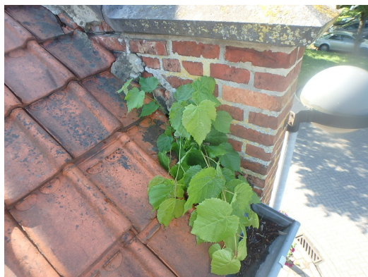
Weggevalle mortelaanwerking met plantengroei tot gevolg.
