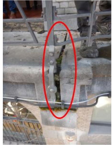
console rechts: beschadigd ankerpunt met steenschade + open voeg
