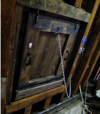
Breng stevige handgrepen en een valketting aan bij torenluiken. ① ②
