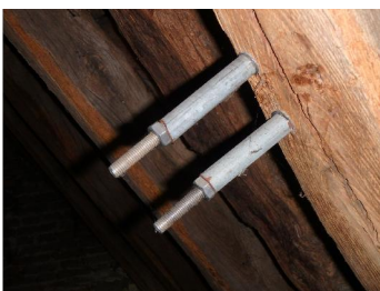
Bevestiging ladderhaken zijn bij voorkeur zichtbaar aan de binnenkant.
