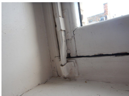
straatzijde: raam 2de verdieping
