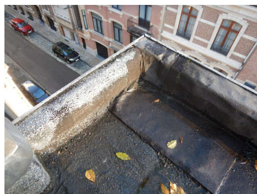
dak [1]-oost: herstelling
