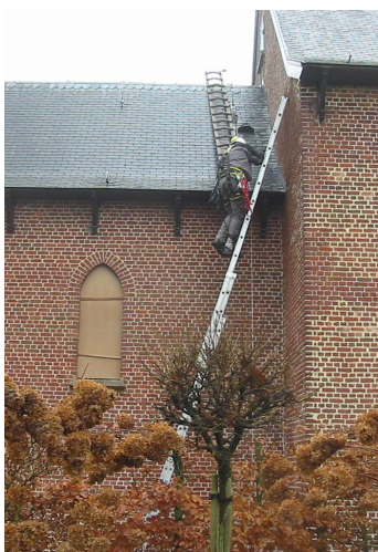
De zolder is bereikbaar met behulp van een ladder, leiladder en de nodige ladderhaken.
