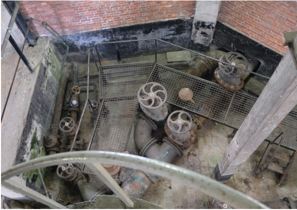
afb. 31: Onderaan machinekamer gelijkvloers en bovenaan schacht ter hoogte van de kuip met wenteltrap.
