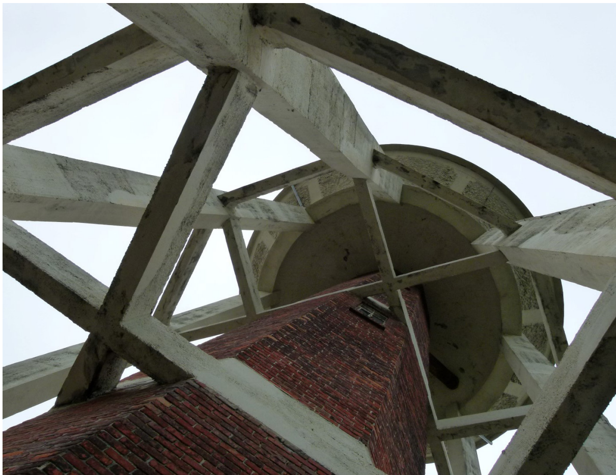
afb. 22: De watertoren Umicore in Olen langs de binnenzijde © Inventaris Onroerend Erfgoed
