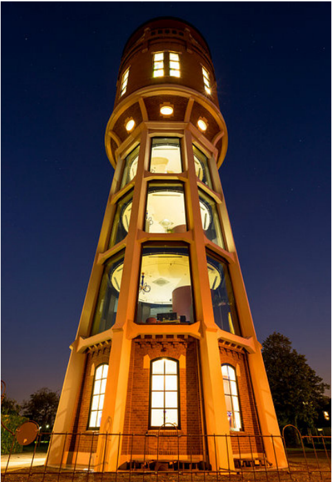
afb. 36: Referentiebeeld van watertoren met verlichting © Watertoren in Hazerswoude.
