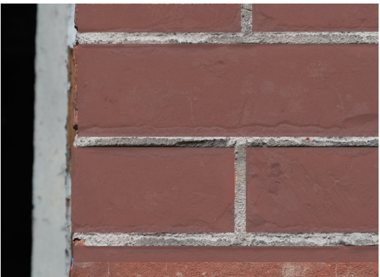
afb. 51: Simulatie knipvoegen met roodschildering.
