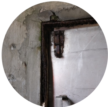
afb. 54: Sluitwerk aan deur bovenaan dakconstructie
