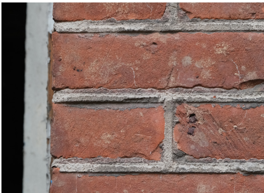
afb. 52: Huidige toestand voegwerk met gedegreerde knipvoegen en roodschildering.
