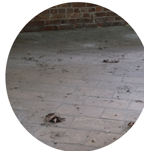
afb. 34: Verzakte tegelvloer
