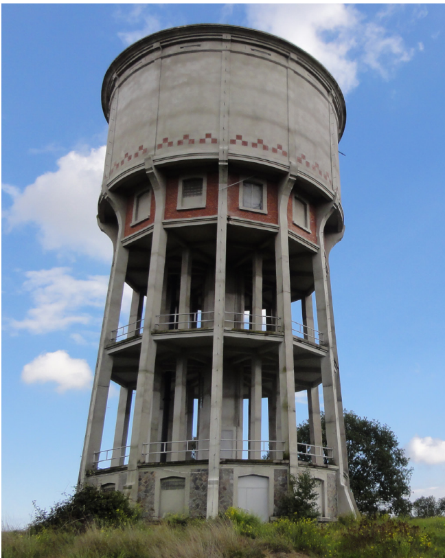
afb. 20: De watertoren bij Leopoldsburg in Hechtel (militair domein) uit 1923 met verticale doorsnede, en een inhoud van 1000 m³ © W. Van Craenenbroeck, Eenheid in verscheidenheid: watertorens in België , Brussel, 1991: 94.
