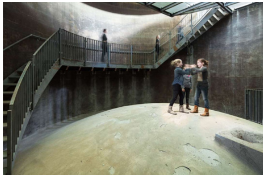
afb. 41: Herbestemming van watertoren Sint Jansklooster naar uitkijktoren, Barsbeek, Nederland, interieur van de betonnen kuip © ZECC Architecten.
