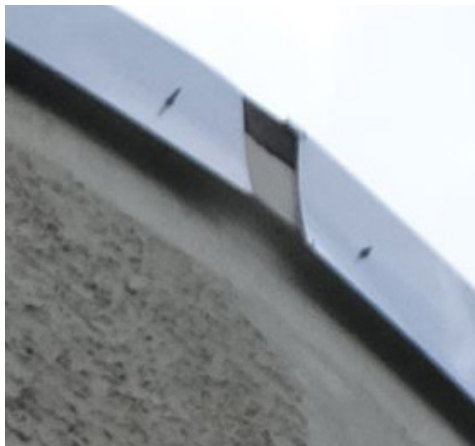
afb. 63: Opening in metalen kuiprand met zicht op betonnen kuiprand
