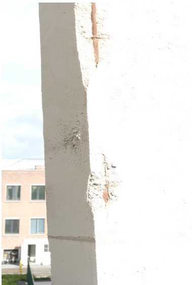
afb. 58: Geroeste wapening aan betonskelet.
