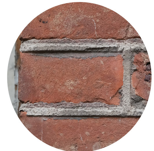
afb. 35: Knipvoegen met roodschildering
