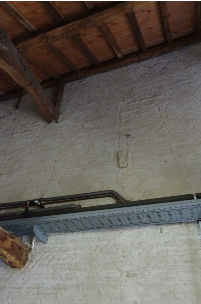
Afbeelding 55. K0.01, dichtgemetseld venster.
