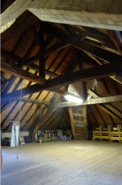
Afbeelding 86. K2.01. de rookkanalen worden ondersteund door verankerde houten constructies.
