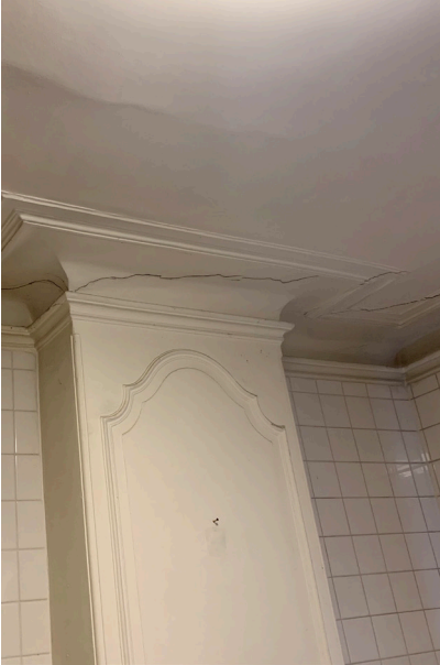
Afbeelding 144. Reparatie aan de deur tussen K0.02 en K0.03.
