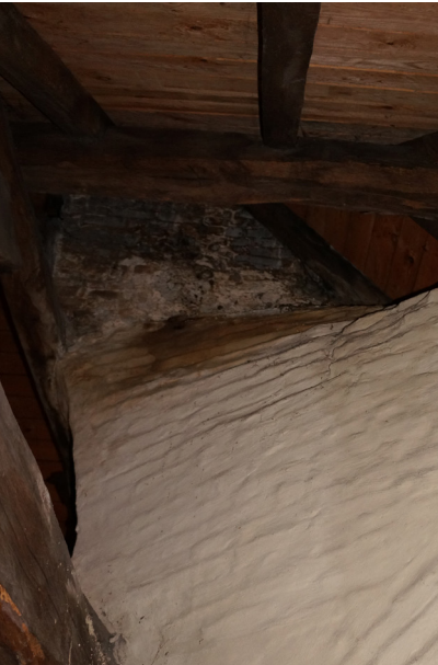
Afbeelding 137. Vocht- en roetdoorslag op de rookkanalen.
